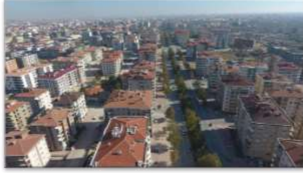
Şekil 3.14. Konya Eski Garaj Kentsel Dönüşüm Projesi uygulama sonrası (Karatay Belediyesi, 2018)
