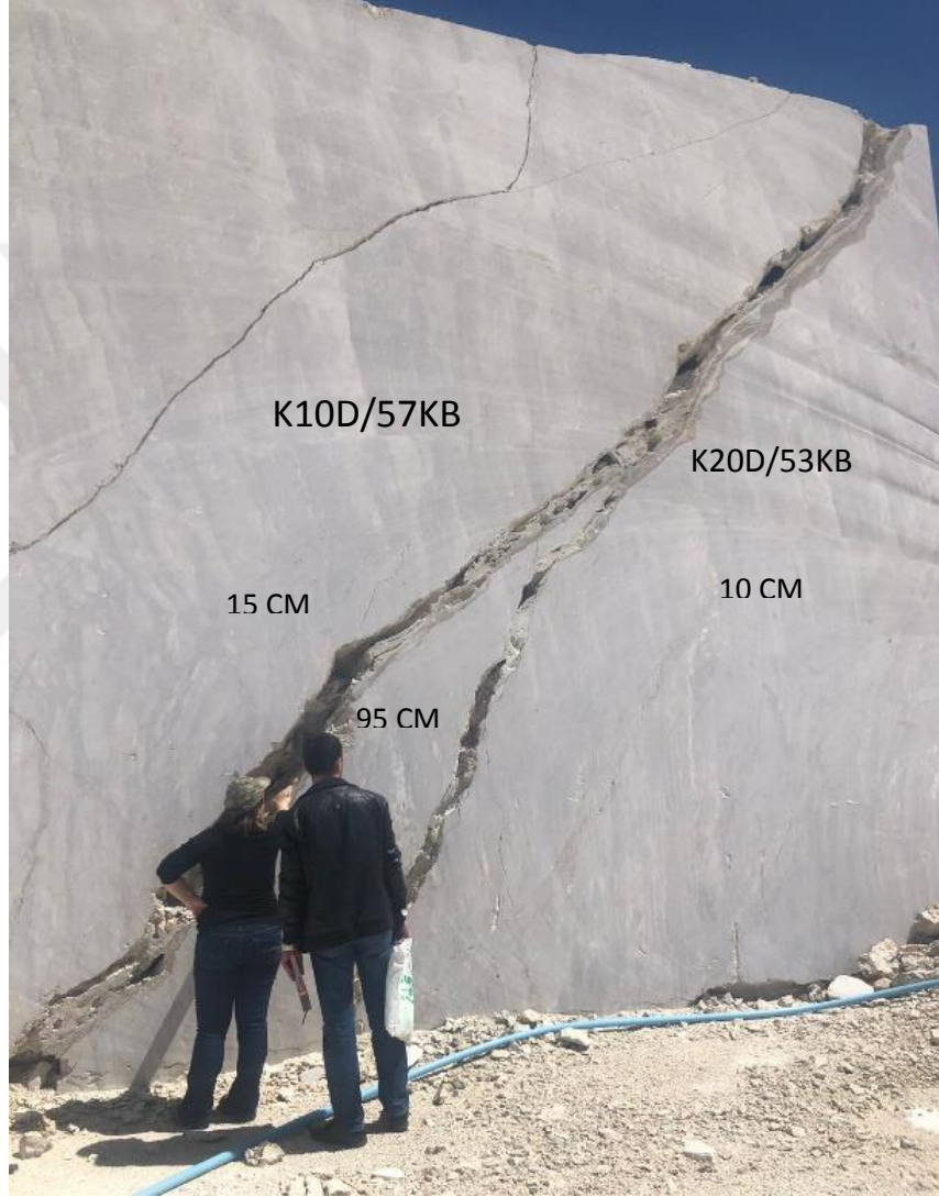
Şekil 4.11. Ayna üzerinde görülen erime boşluğu ve aragonit oluşumu (Kademe 4)
