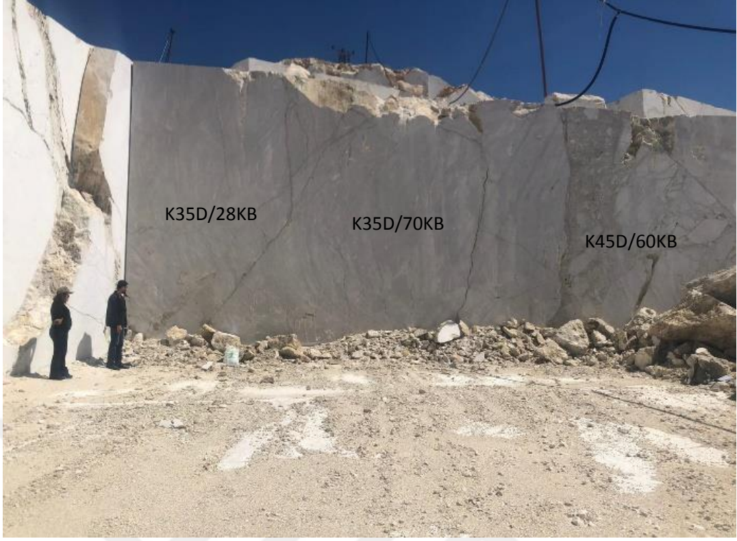
Şekil 4.9. Ocakta aynada gözlenen çatlaklar, kil dolgusu ve breşleşme (Kademe 4)
