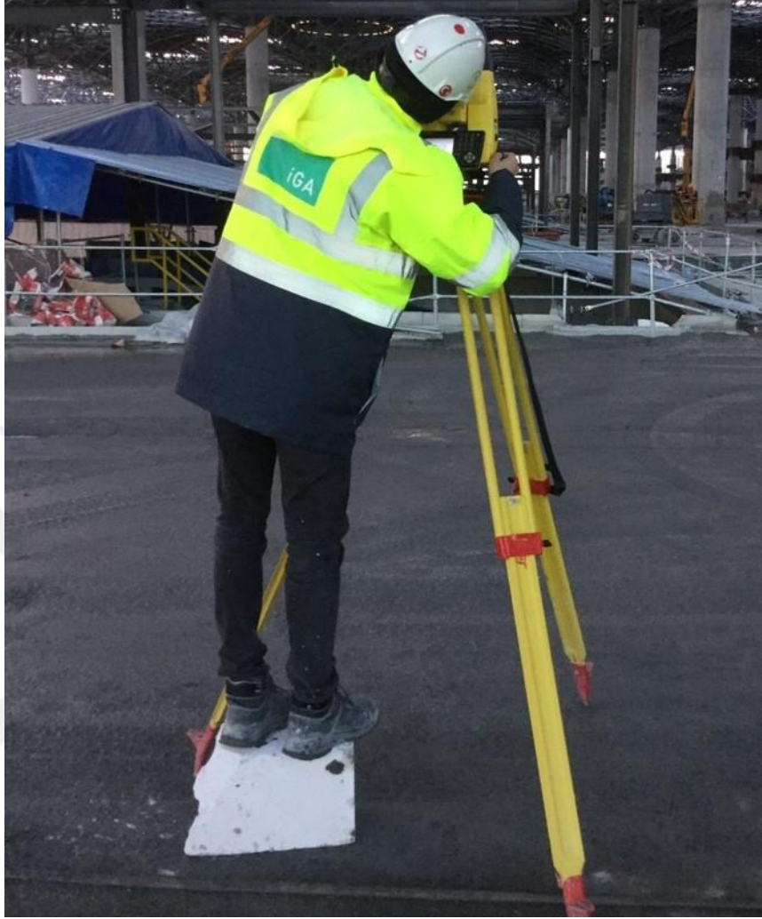
Şekil 4.7: Zemin işleri yüzünden aksayan ölçme işlemi
