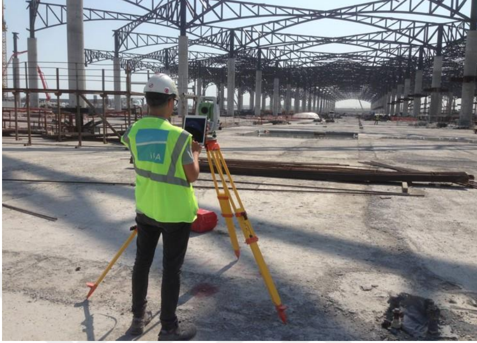
Şekil 3.32: Robotik total station ile imalat kontrolü
