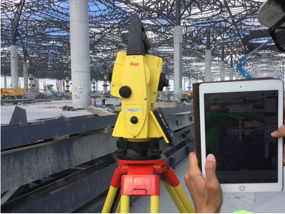
Şekil 4.10: İTYBYS ile mekanik sistemlerin kontrolü
