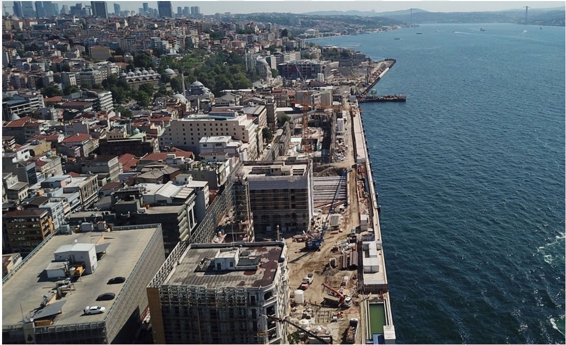
Şekil 5.48: 2019 yılı Galataport inşaatı ve yıkılan Karaköy Yolcu Salonu. (Url-137)
