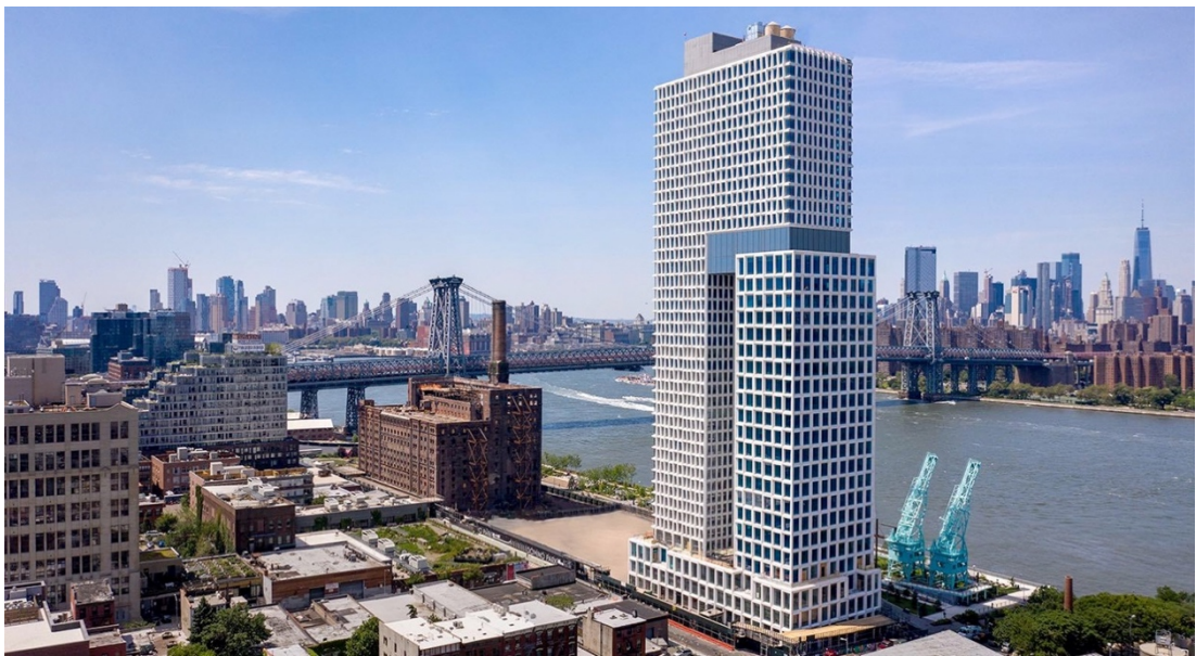
Şekil 5.23: Domino Şeker Fabrikası projesinin tamamlanan ilk yapıları. Yıl:2019 (Url-116)
