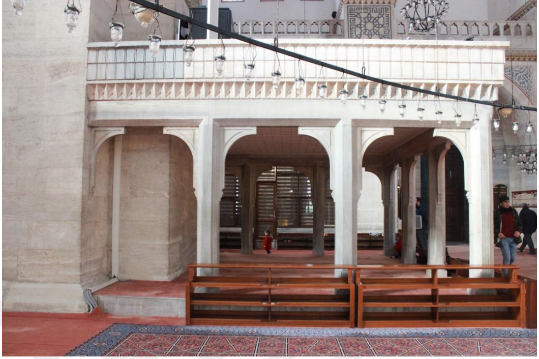
Fot.36. Şehzade Camii Müezzin Mahfili Güney Cephesi
