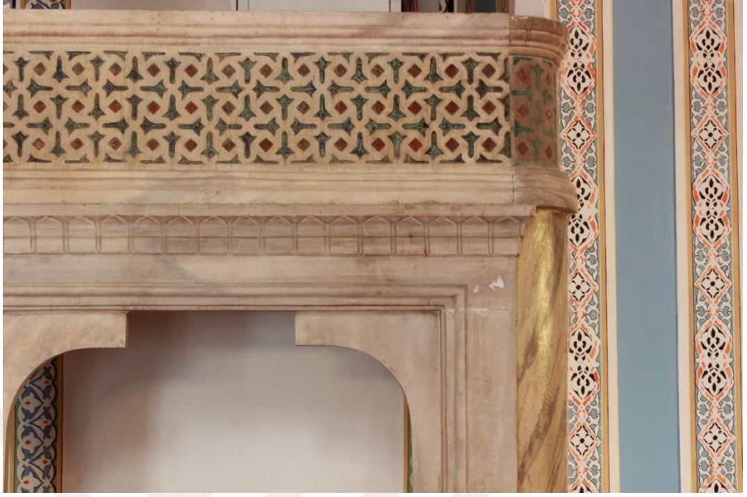
Fot.50. Sinan Paşa Camii Müezzîn Mahfili Tezyinat Detayı
