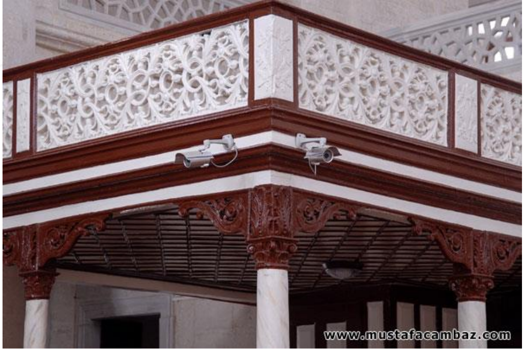
Fot.18. Nişancı Mehmed Paşa Camii Müezzin Mahfili 307
