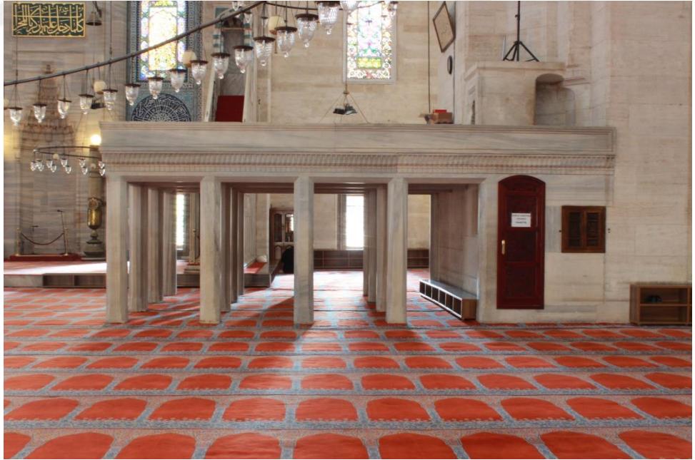
Fot.53. Süleymaniye Camii Müezzın Mahfilı Kuzey Cephesi
