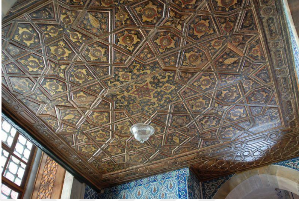
Fot.58. Rüstem Paşa Camii Müezzîn Mahfili Kalem İşleri 316
