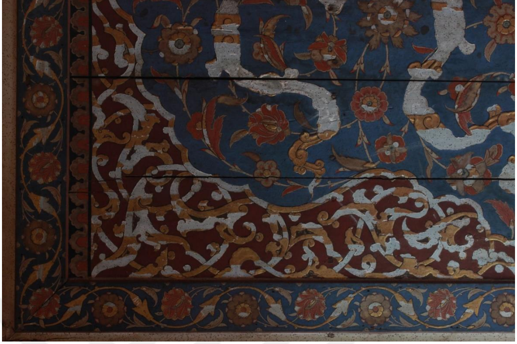
Fot.48. Kara Ahmed Paşa Camii Müezzin Mahfili Döşeme Altı Tavanı Kalem İşi Süsleme Detayı
