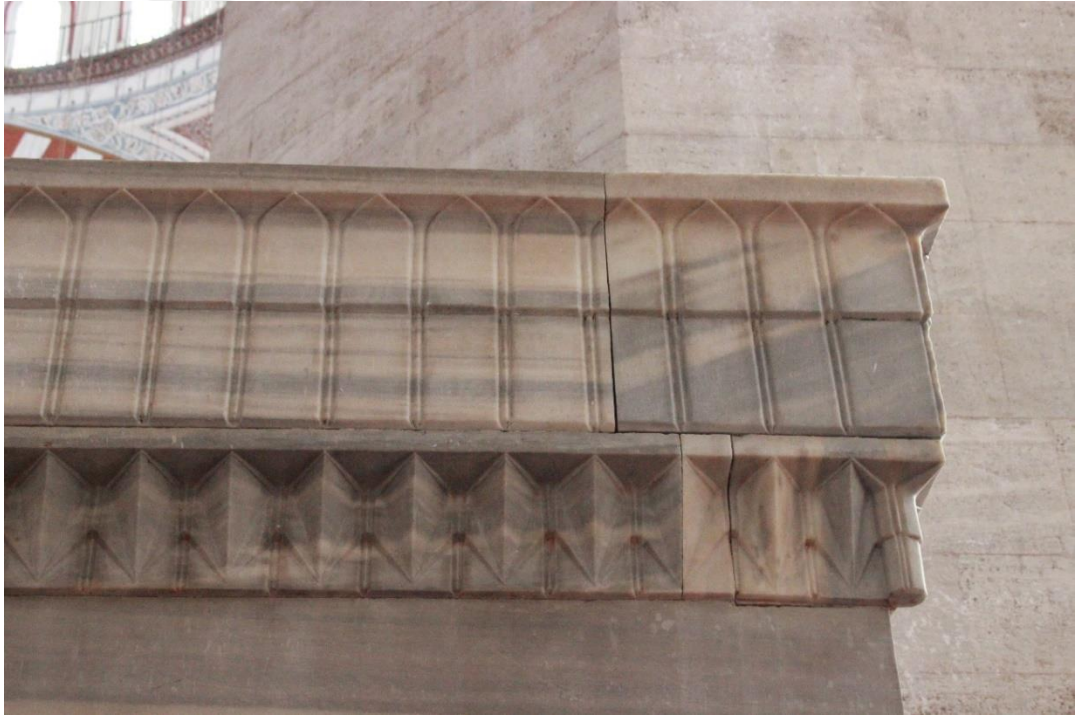
Fot.35. Şehzade Camii Müezzin Mahfili Kuzey Cephe Detay
