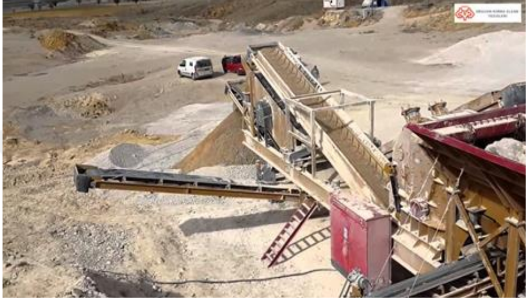
Şekil 4.30. Olivin İşletmesindeki kırma eleme sistemi
