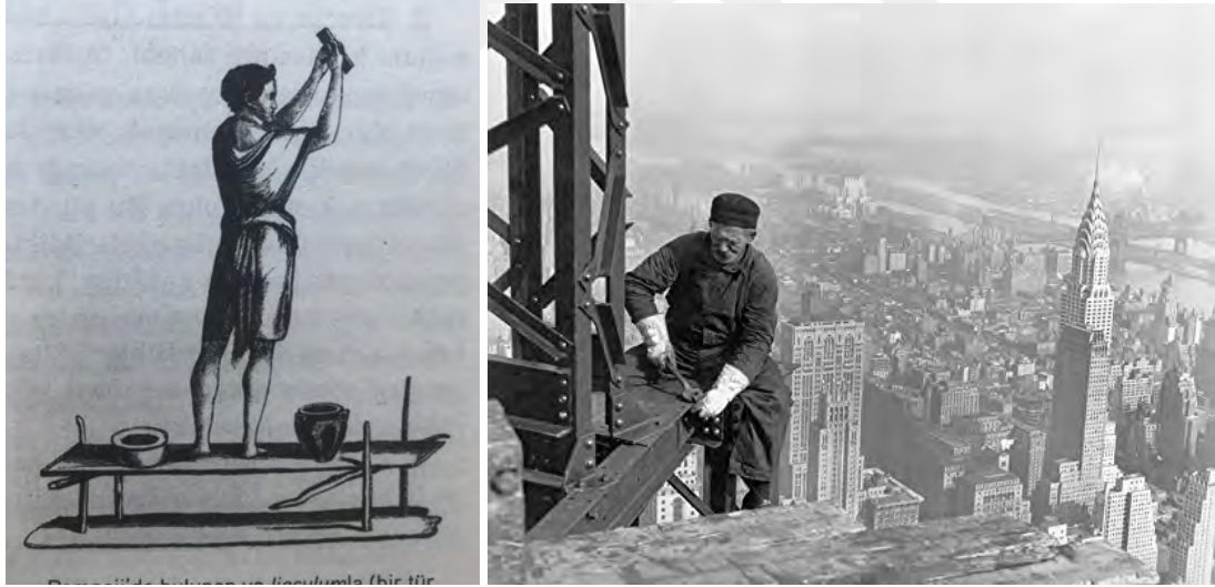
Şekil 3.6 : Antik Çağ’da duvarları perdahlayan bir işçi tasviri (soldaki) (Vitruvius, 2017, s. 71) ve New York’ta bir şantiye (sağdaki) (Tanyeli, 2011, s. 198).
