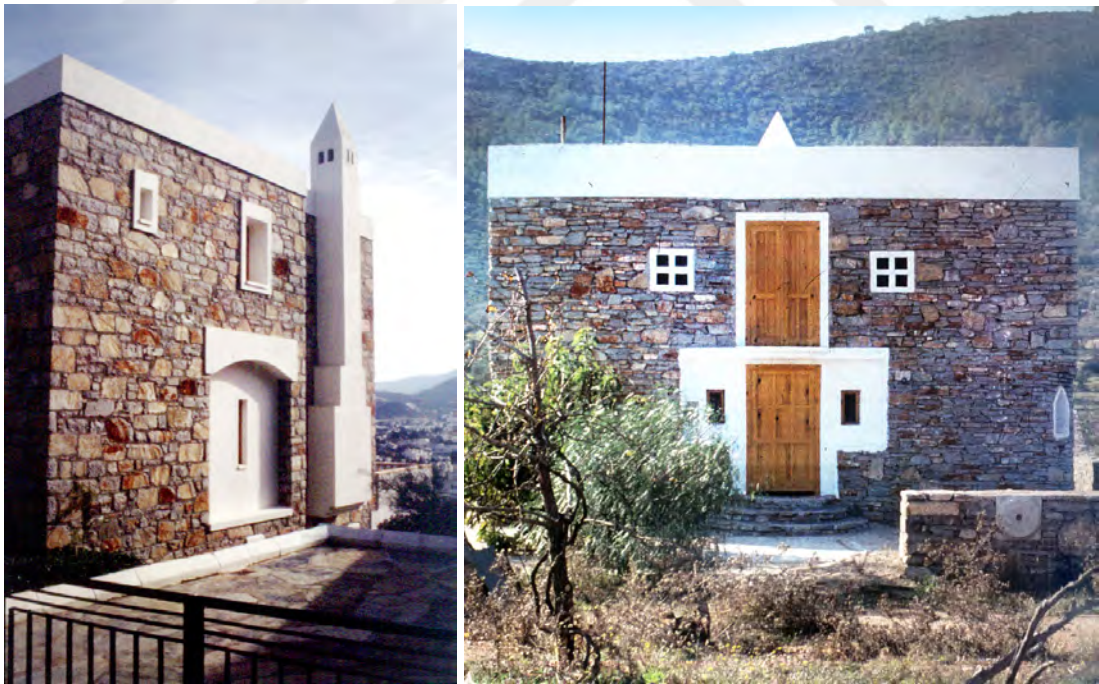
Şekil 4.1 : Akın Balkan Evi (soldaki) (Url-12) ve Yula Evi (sağdaki) taş örgü duvarlarda görülen ustalık farklılıkları (Url-13).
