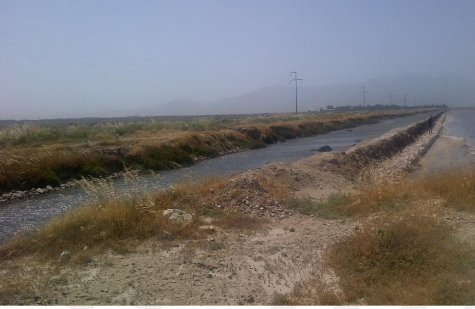
Şekil 2.2. Çamaltı Tuzlası su iletim kanalları
