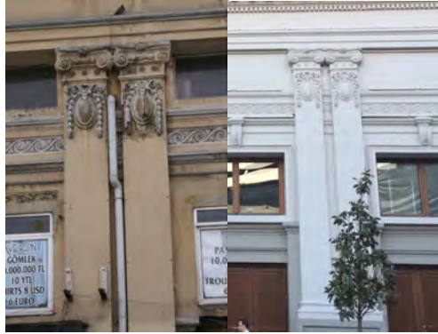
Şekil 4.16: Cephe Çift Sütun Yapı Elemanı, Eski ve Yeni Karşılaştırması
