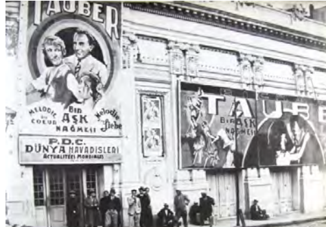
Şekil 4.3: 1930'larda Majik sineması görünüşü (Gülersoy, 1986, s.127).
