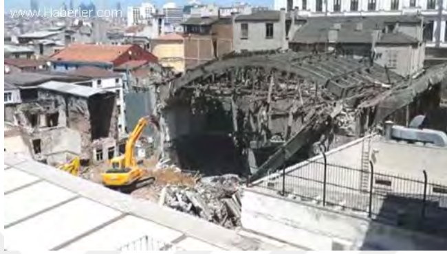
Şekil 3.20: Emek Sineması Yıkımı (URL-10, 2016)
