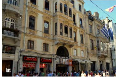
Şekil 3.13: Halep Apartmanı ve Pasajı
