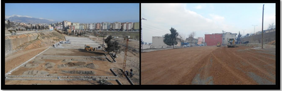
Şekil 4.3. Yıkımı Tamamlanan Rekreasyon, Otopark ve Spor Alanlarının Yapım Aşaması
