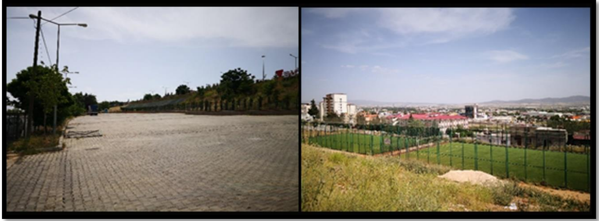
Şekil 4.4. Yapımı Tamamlanan Otopark ve Spor Alanı
