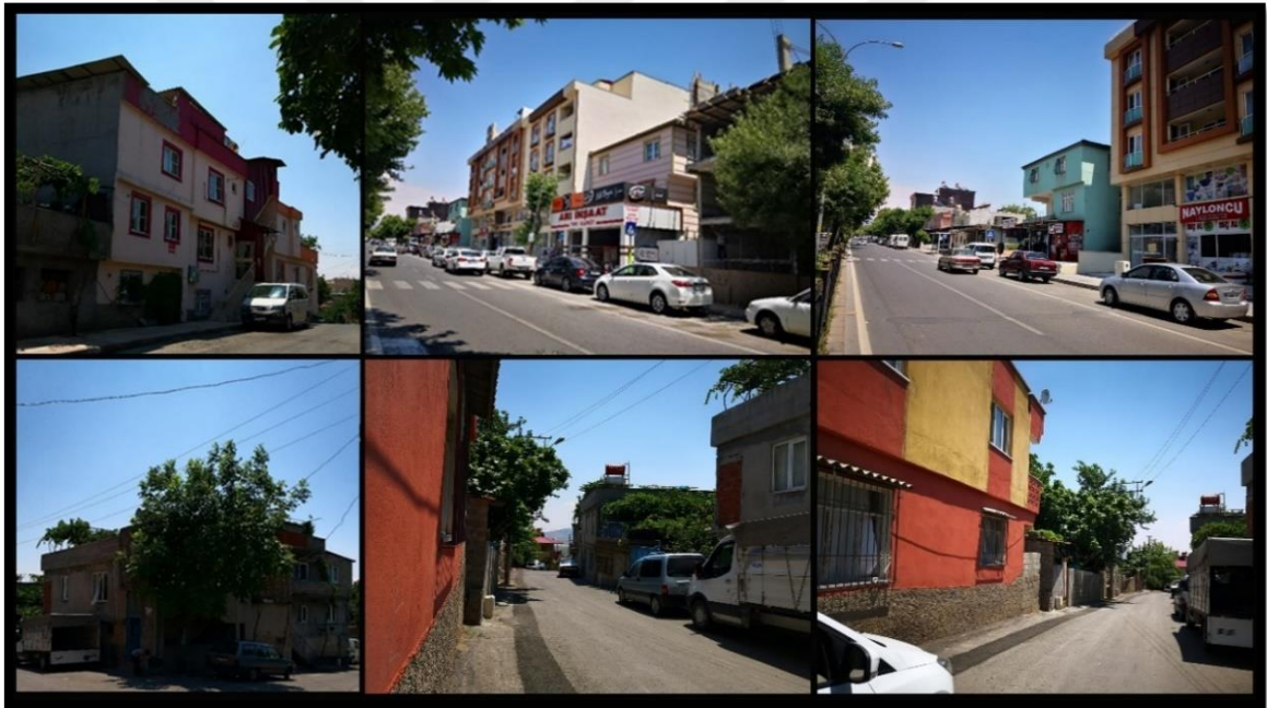
Şekil 4.18. Malik Ejder Mahallesinde Riskli ve Yerleşime Uygun Olmayan Bölgede Mevcut Yapılardan Görünüm
