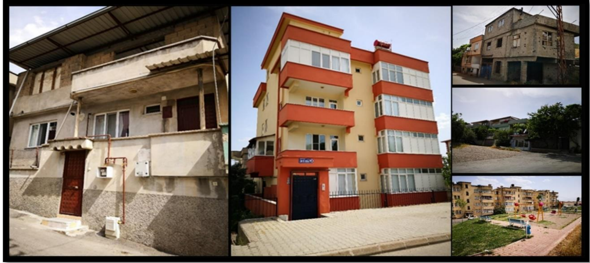
Şekil 4.6. Gayberli Mahallesinde Yerleşime Uygun Olmayan Alanda Bulunan Bazı Mevcut Yapılardan Görünüm
