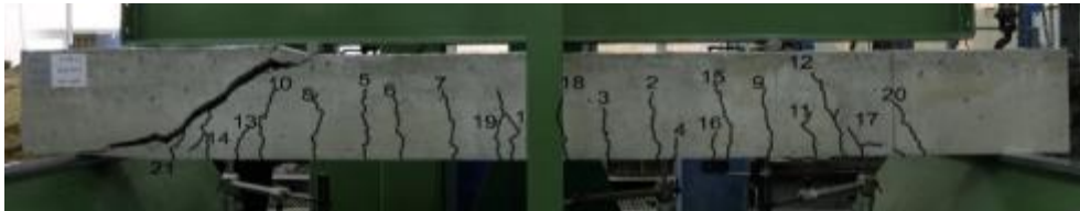
Şekil 4.92. KI-ND-1-2 Numunesinde Oluşan Çatlaklar
