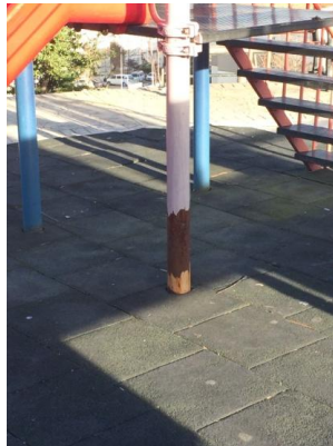
Şekil 5.33 Oyun elemanlarında bakımsızlıktan meydana gelen bozulma
