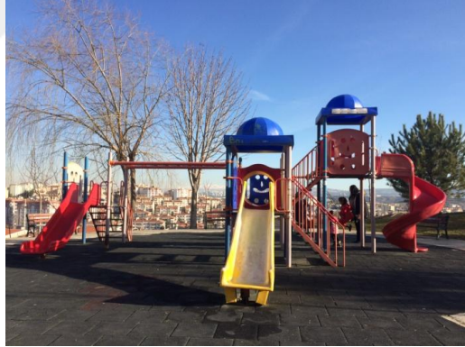
Şekil 5.32 Oyun elemanlarında bakımsızlıktan meydana gelen bozulma
