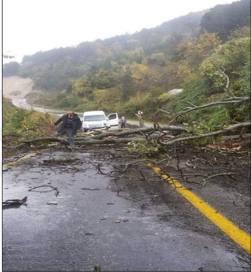
Şekil 3.31 : Çatalzeytin Merkez Didi mahallesi heyelanı 14.11.2018
