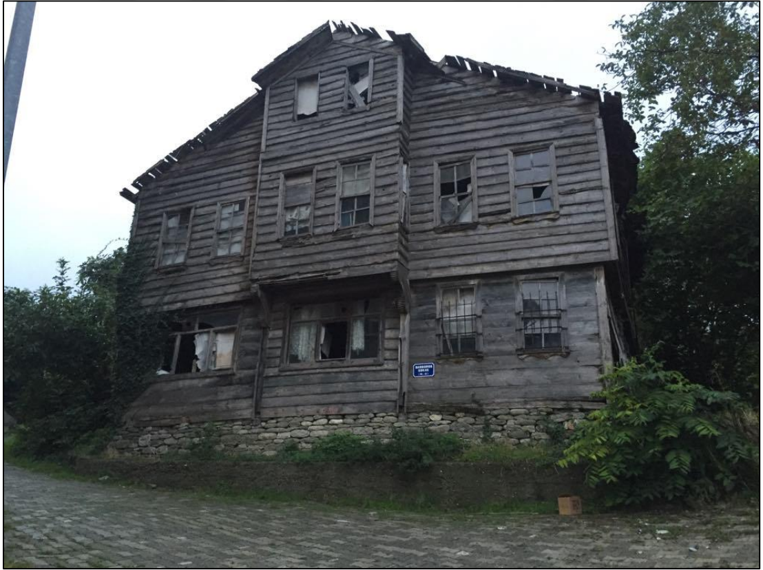
Şekil 3.42 : Geleneksel Yapı Örneği
