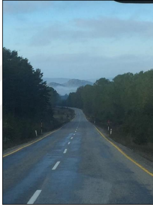
Şekil 3.38 : Dağ Ulaşım Yolu
