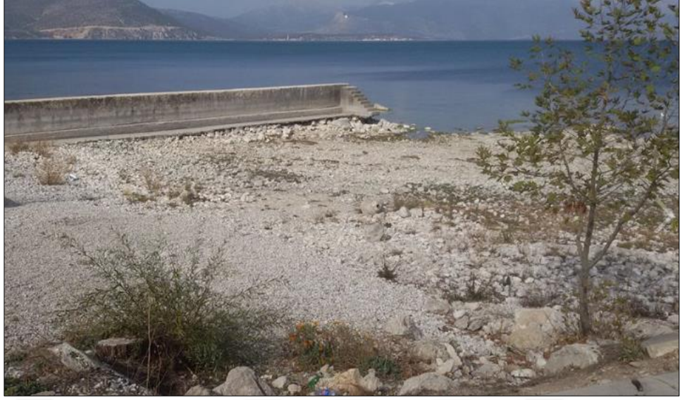
Foto 30. Eğirdir İlçe Merkezi Can Ada Restoranları Çevresi
