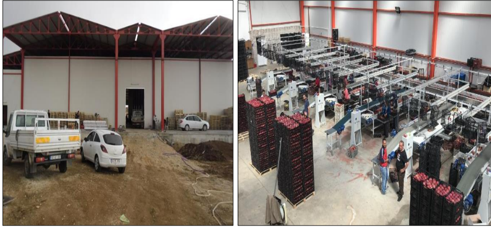
Foto 3. Eğirdir İlçesinde 30 tane soğuk hava depolama tesisi bulunmaktadır.
