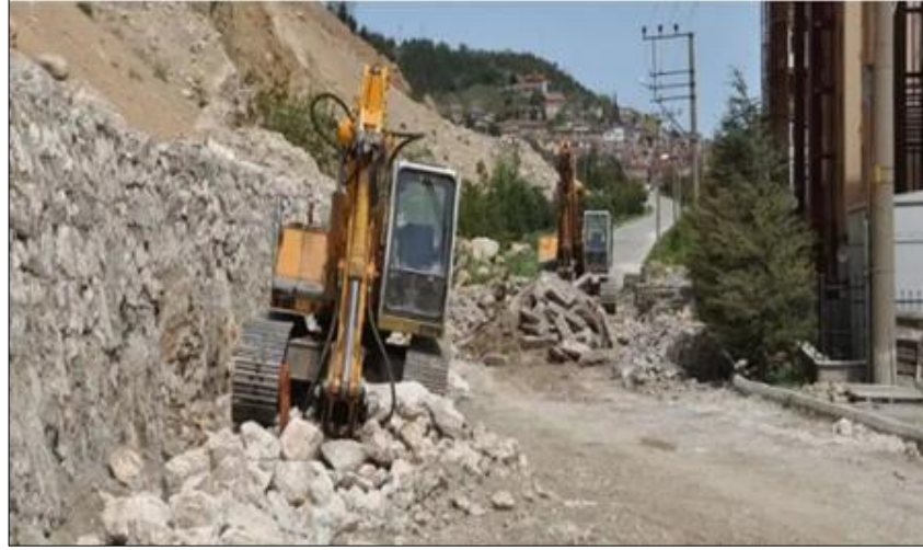
Foto 18. Eğirdir Belediyesi Fen İşleri ekiplerince İmaret Mahallesinde bulunan Sağlık Ocağı Evlerinin Arka Bölümünde Heyelan Nedeni İle Tehlike Yaşayan Halkın Sorunlarını Çözmek Amacıyla İstinat Duvarı Örülme İşlemi.
