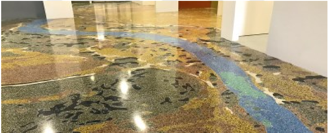
Şekil 4. 23 Weber Valley Gençlik Merkezi, zeminde terrazzo çalışmaları [120]
