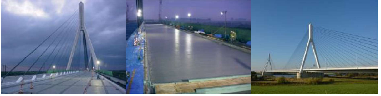
Şekil 2.7 Mihara Köprüsü'nün ECC döşemesi (Li, 2019).
