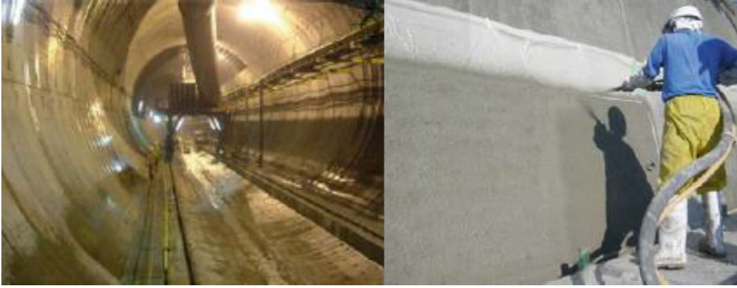
Şekil 2.9 ECC'nin Hida Tüneli'nde sprej uygulaması (Li, 2019).
