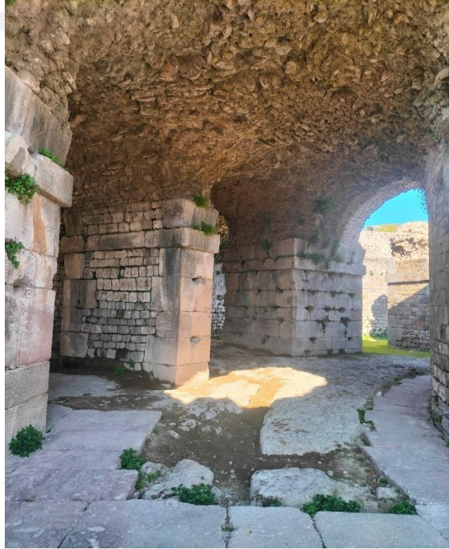
Fotoğraf. 9. Birinci tedavi binası odalarından bir görünüm
