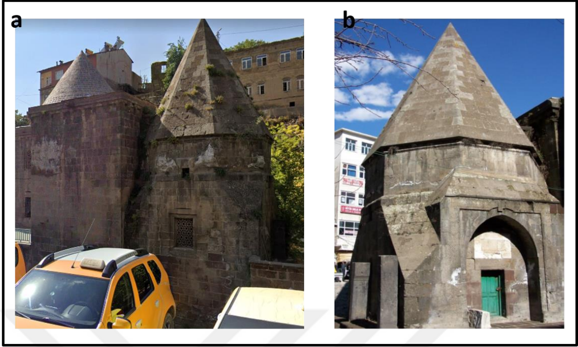
Şekil 4.29. Şerefiye Külliyesi Türbesi ( a- Çarşı görünüşü b) Güney cephesi kemerli giriş kapısı)
