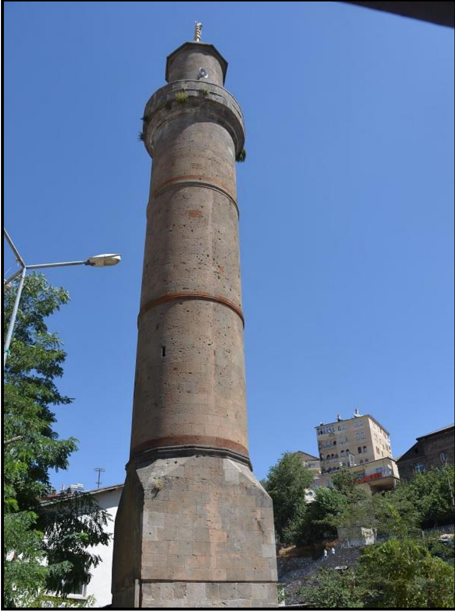
Şekil 4.24. Bitlis Ulu Camii minaresi
