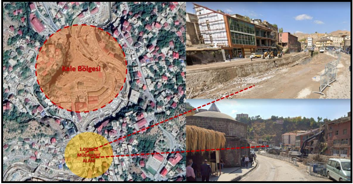
Şekil 4.11. Dere Islah Projesi 1.Dere bölgesi müdahale alanı( solda uydu görüntüsü Google Earth Pro)
