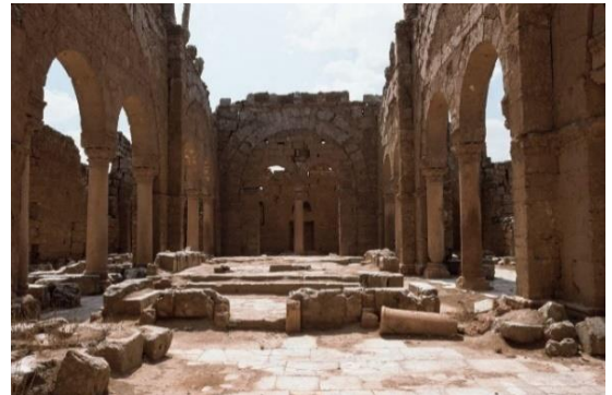
f. Rusafe Bazilikası (İ.S. 475-495)
