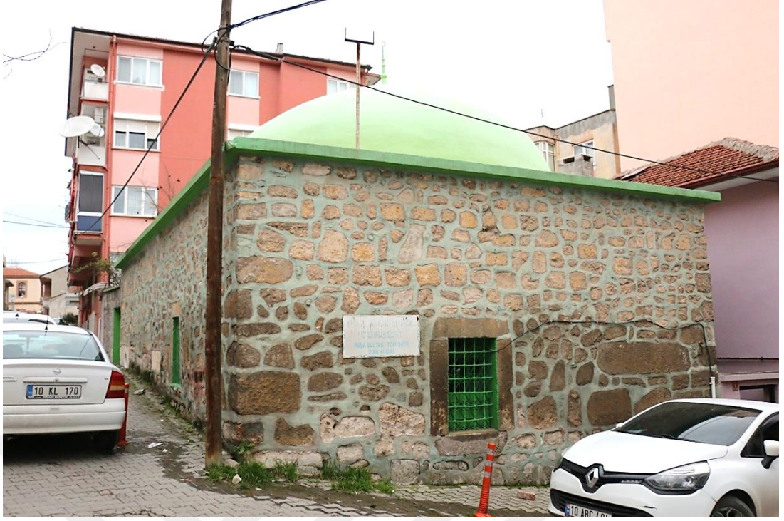
Şekil 6. Paşa Sultan (Töm Dede) Türbesinin Dış Görümü
