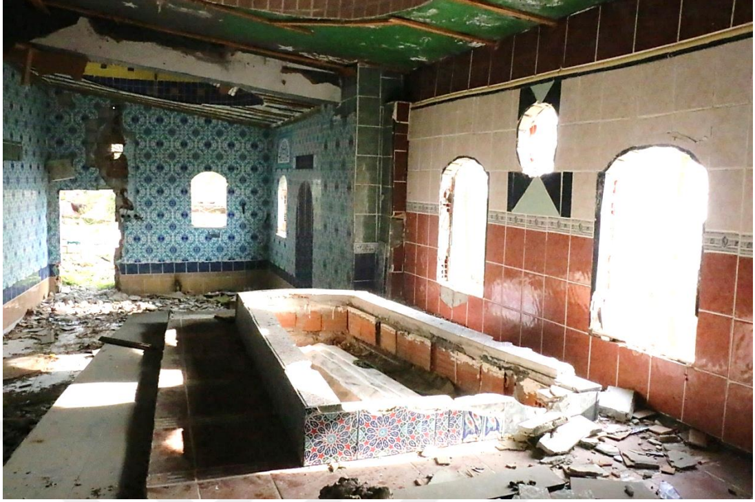
Şekil 72. Gökköy Türbesi İç Görünümü
