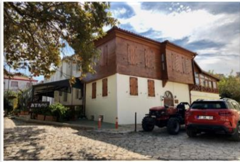
Şekil 13. Bozcaada alt kat kagir, üst kat ahşap yapı örneği
