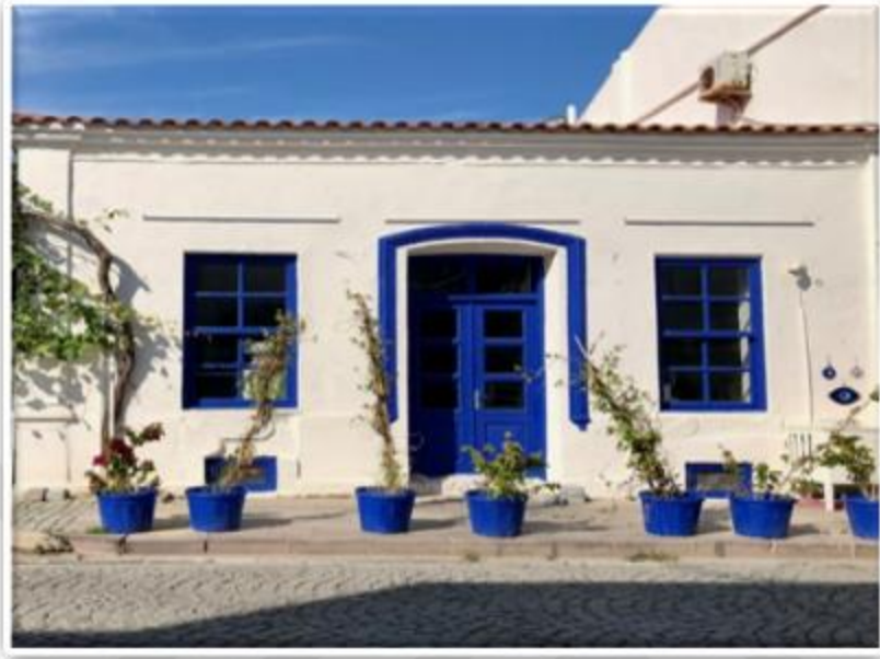
Şekil 12. Bozcaada kagir yapı örneği
