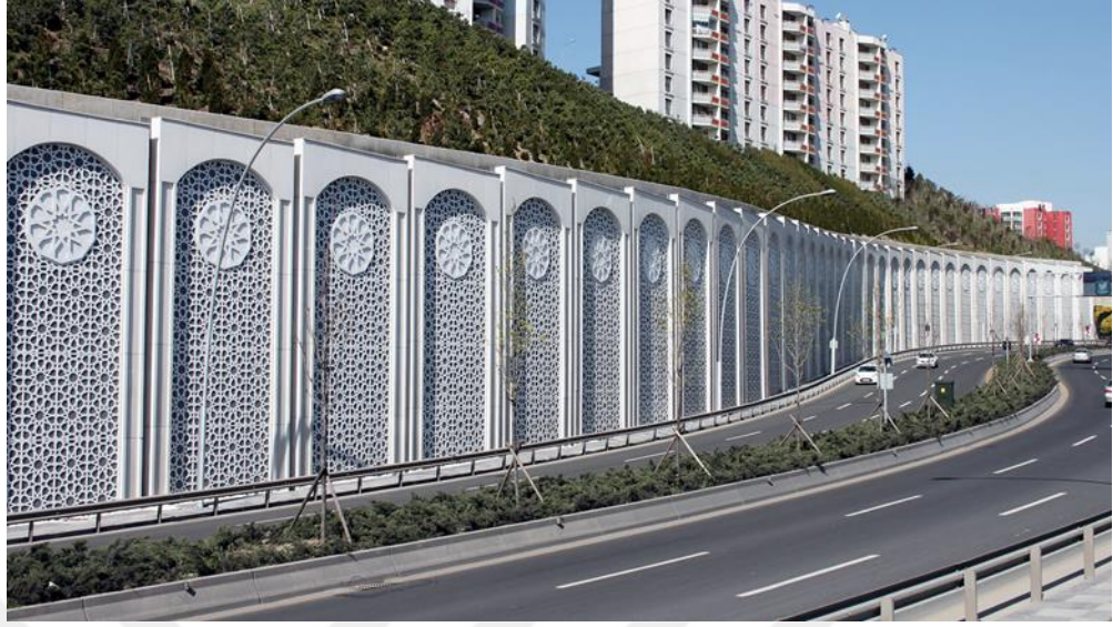
Resim 22. Otoyol Duvar Kaplaması
