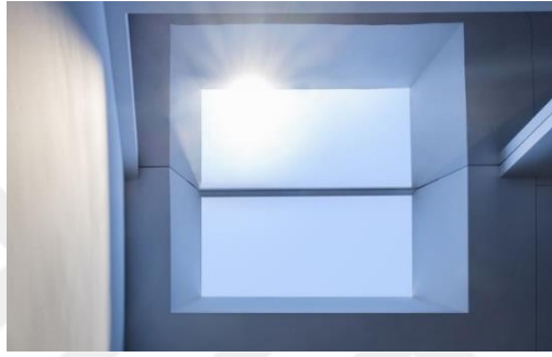
Şekil 3.4. Güneşin yansıtıcı yüzeyleri, reflektör kullanılarak tasarlanan pencere görseli.
