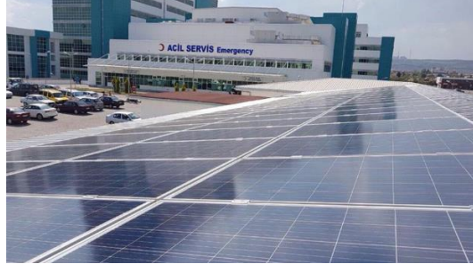
Şekil 21. Güneş panelleri uygulanmış bir hastanenin çatısı (Koyuncuoğlu, 2017)
