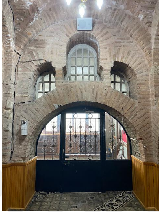
Fotoğraf 4.5.4-Hırâmi Ahmet Paşa Cami Giriş Cephesi
