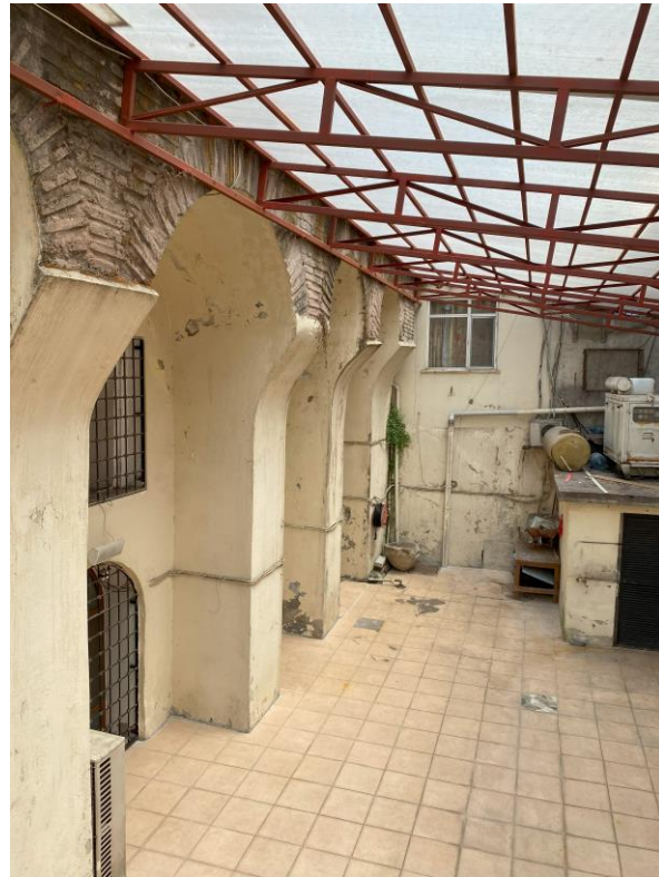
Fotoğraf 4.4.6-Myrelaion Kilisesi Podyum Güney Cephesi
