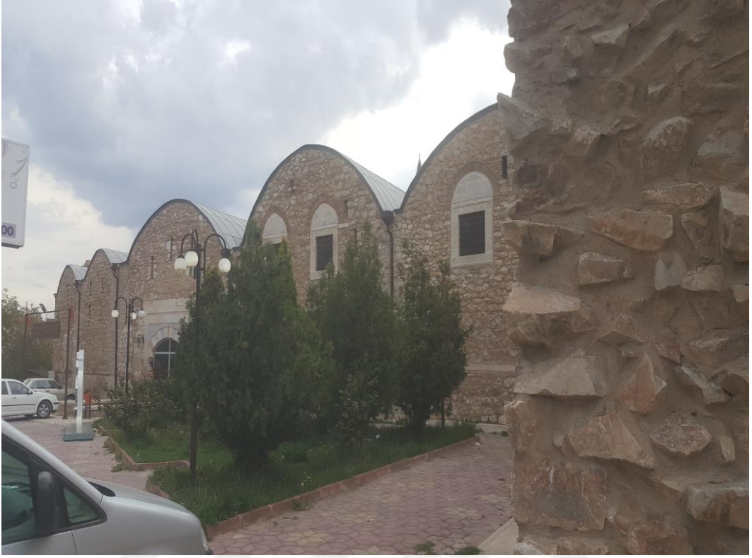
Fotoğraf 120: Lala Mustafa Paşa Kervansarayı'nın Doğu Cephesi
