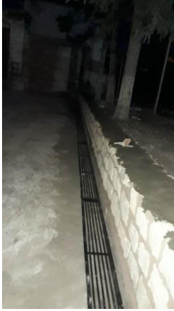
Fotoğraf 176 – 177 – 178: Rüstem Paşa Kervansarayı'nın Avlu Yağmur Gideri Izgara Sistemi, Avlu Giriş Kapısı Üstü Tonoz İçin Kalıp Yapımı Ve Avlu Kapısı Üstü Betondan Temizlendikten Sonraki Durumu
