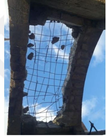
Fotoğraf 176 – 177 – 178: Rüstem Paşa Kervansarayı'nın Avlu Yağmur Gideri Izgara Sistemi, Avlu Giriş Kapısı Üstü Tonoz İçin Kalıp Yapımı Ve Avlu Kapısı Üstü Betondan Temizlendikten Sonraki Durumu
