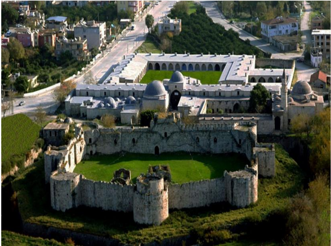
Fotoğraf 187: Sokullu Mehmet Paşa Kervansarayının Restorasyon Sonrası Genel Görünüşü (Taş, 2020)
