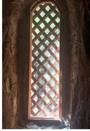
Fotoğraf 161 – 162 – 163: Rüstem Paşa Kervansarayının Pencereleindeki Ahşap Izgara (Seperatör) ve Pleksiglas Uygulama Detayları
