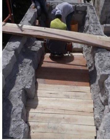
Fotoğraf 176 – 177 – 178: Rüstem Paşa Kervansarayı'nın Avlu Yağmur Gideri Izgara Sistemi, Avlu Giriş Kapısı Üstü Tonoz İçin Kalıp Yapımı Ve Avlu Kapısı Üstü Betondan Temizlendikten Sonraki Durumu
