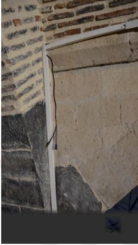
Fotoğraf 81 – 82: Çoban Mustafa Paşa Kervansarayının İç Mekan Elektrik Kablosu Detayları (Süvari, 2015: 58)
