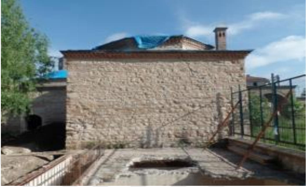
Fotoğraf 34: Sinan Paşa Külliyesindeki Beton İle Tarihi Yapı Birleşimi (Ünay, 2019:1197)
