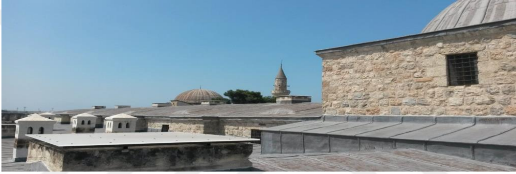
Fotoğraf 198: Sokullu Mehmet Paşa Kervansarayının Restorasyon Sonrası Çatısının Görünüşü (Wordpress, 2021)
