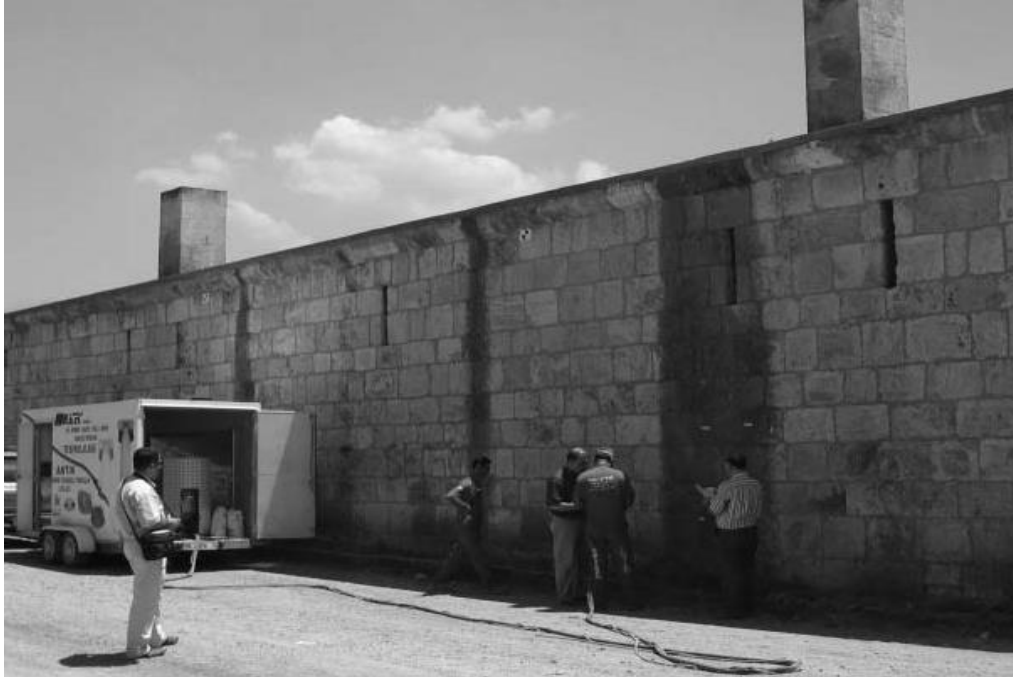
Fotoğraf 191: Sokullu Mehmet Paşa Kervansarayı'nın Kuzey Duvarı, Mikro Kumlama İle Temizlik Denemeleri (Eskici, 2008: 89)
