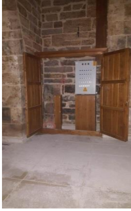
Fotoğraf 173 – 174 – 175: Rüstem Paşa Kervansarayı Elektrik Panolarının Ahşap Kaplanması, Ana Giriş Harpuşa Detayı Ve Eskiz 10 Giriş Spider Detayları
