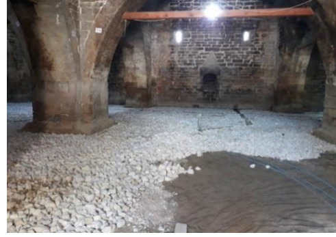
Fotoğraf 146 – 147: Rüstem Paşa Kervansarayının İç Mekan Zemin Uygulamaları
