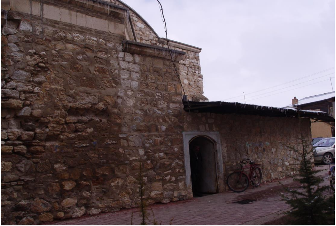
Fotoğraf 99: Lala Mustafa Paşa Kervansarayı'nın Güney-Batı cephesi ve Abdesthane (KVBM Arşivi)
