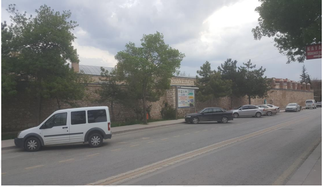
Fotoğraf 122: Lala Mustafa Paşa Külliyesinin Kuzey-Doğu Cephesinden Genel Görünüşü
