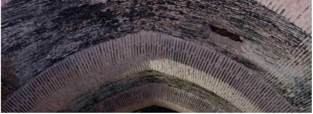
Fotoğraf 75: Çoban Mustafa Paşa Kervansarayı'nın İslî ve Mantarlı Görüntüsü (2005) (Süvari, 2015: 64)
