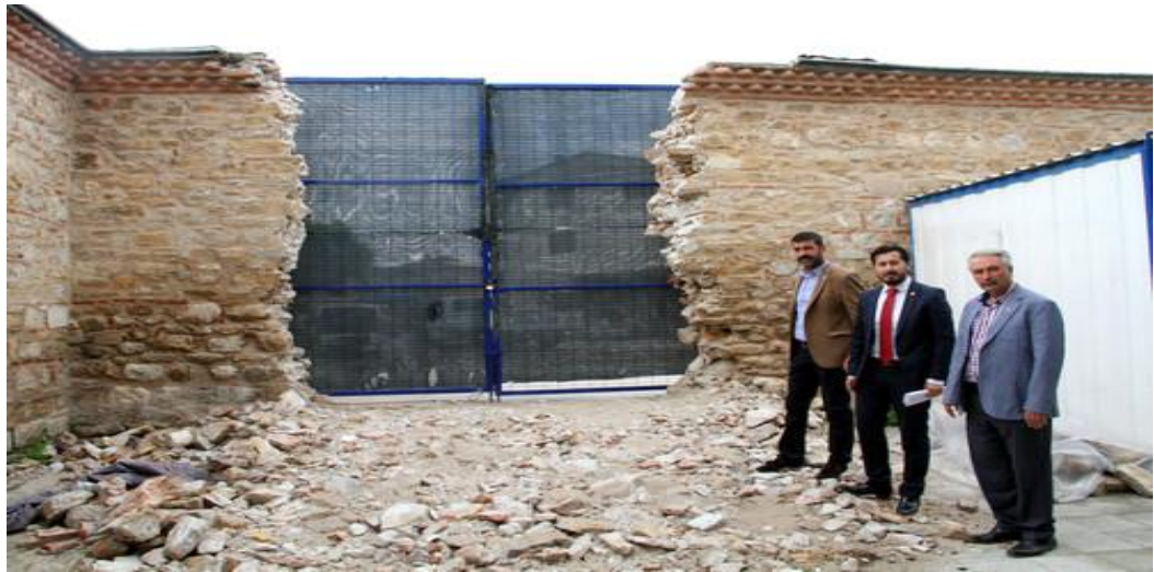
Fotoğraf 40: Sinan Paşa Külliyesindeki Duvarın Yıkılışının Tutanak Altına Alınması (Bıçak, 2015)
