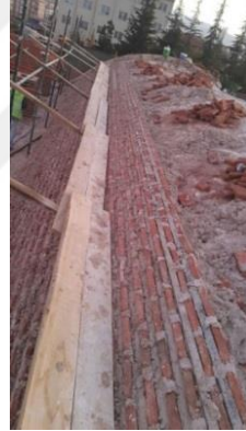
Fotoğraf 140 – 141 – 142: Rüstem Paşa Kervansarayı Çatısında Tonozların Üstündeki Uygulamalar 1
