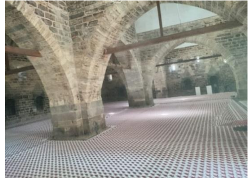
Fotoğraf 167 – 168: Rüstem Paşa Kervansarayının İç Mekan Döşeme Ve Isıtma Uygulama Detayları
