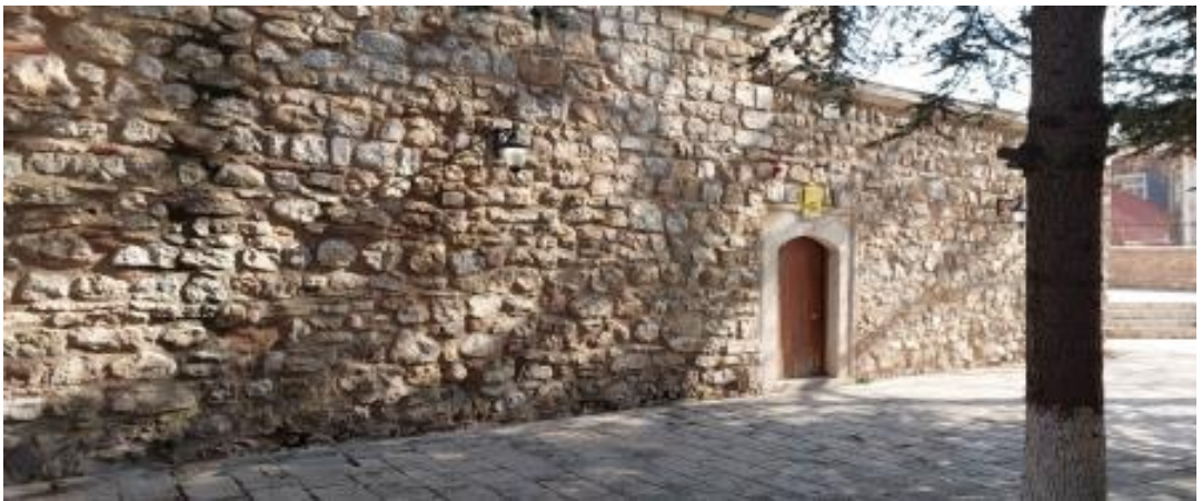
Fotoğraf 109: Lala Mustafa Paşa Kervansarayının Batı Cephesi KBB'nin Kullandığı Bölüm
