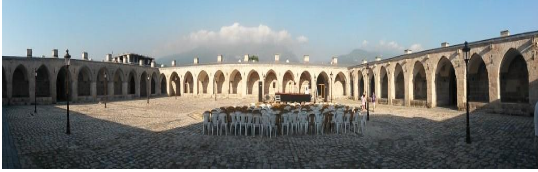
Fotoğraf 197: Sokullu Mehmet Paşa Kervansarayı ve Çevresi Restorasyon Sonrası Genel Görünüşü (Wordpress, 2021)
