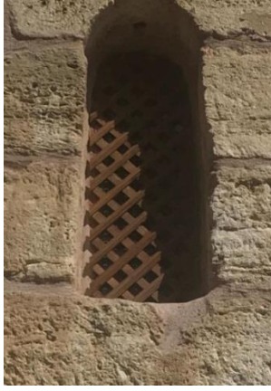
Fotoğraf 161 – 162 – 163: Rüstem Paşa Kervansarayının Pencereleindeki Ahşap Izgara (Seperatör) ve Pleksiglas Uygulama Detayları
