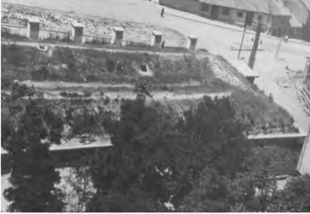
Fotoğraf 50: Çoban Mustafa Paşa Kervansarayı'nın Çatı Örtüsü (1960 – 1969) (Süvari, 2015: 61)
