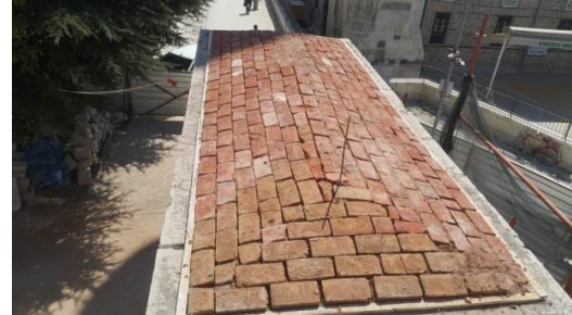
Fotoğraf 179 – 180: Rüstem Paşa Kervansarayı'nın Avlu Giriş Kapısı Güneyi Duvar Detayı Ve Avlu Giriş Kapısı Üstü Çatı Örgüsü Kurşun Öncesi Son Durumu
