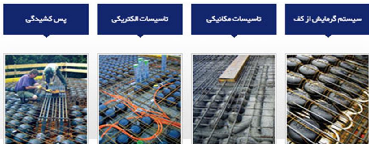
تصویر ۵۲-۵-۲ : اجرای تأسیسات الکترونیکی و مکانیکی
