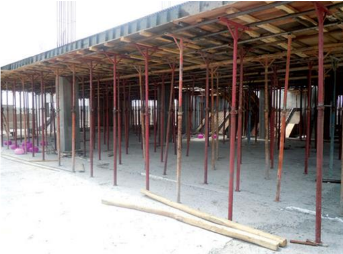
تصویر ۲-۵-۵۴ : قالب بندی سیستم سازه ای
