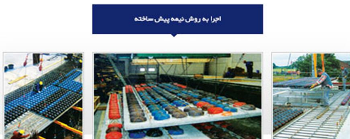
تصویر ۵۳-۵-۲ : اجرا سیستم سازه ای کوبیاکس به روش نیمه پیش ساخته
