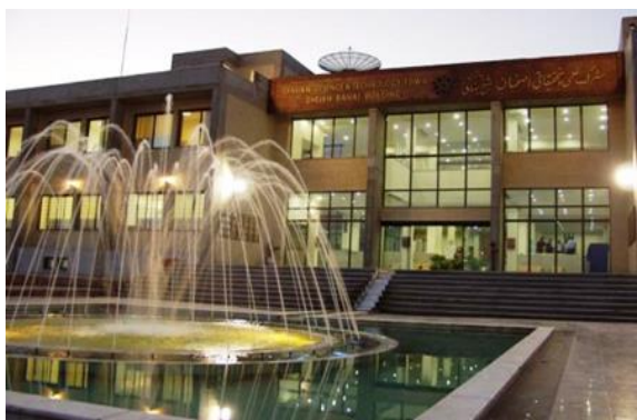
تصویر ۴۳-۴-۱ : ساختمان شیخ بهایی
