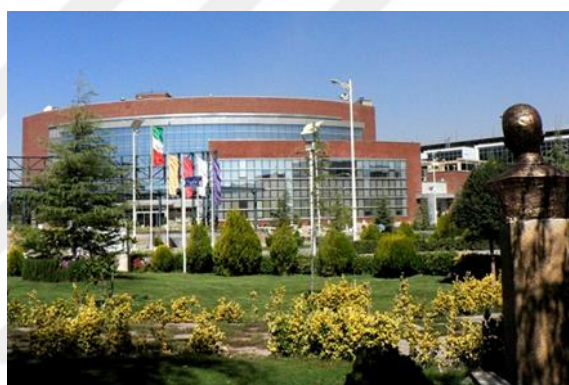
تصویر ۱-۴-۳۵ : ساختمان مرکزی پارک فناوری پردیس
