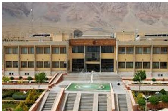
تصویر ۴۱-۴-۱ : ساختمان فناوری یک
