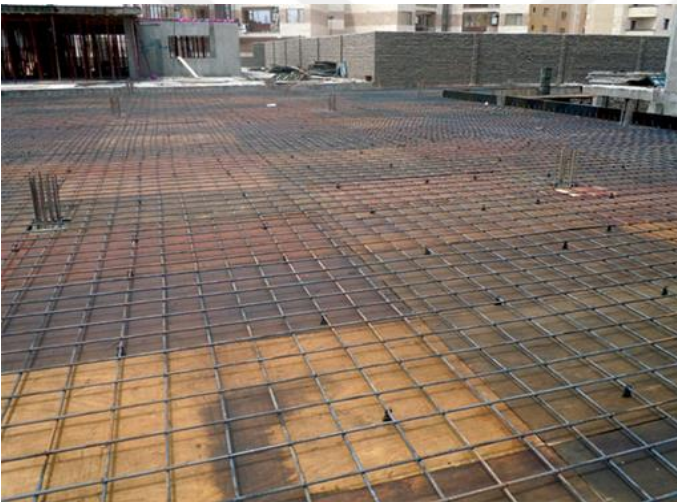
تصویر ۲-۵-۵۵ : اجرای شبکه آرماتور پائینی سیستم سازه ای
