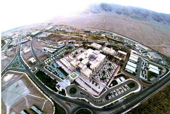
تصویر ۱-۴-۴۰: نحوه دسترسی به ساختمان ها شهرک
