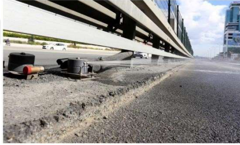
Resim 11. Gizli Buzlanmayı Algılama ve Önleme Sistemi
