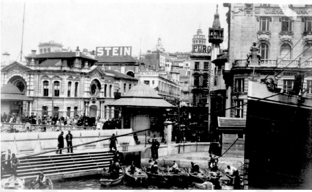
Şekil 5.8 Karaköy Meydanı Aziziye Karakolu solda. Yıkılıp yerine Seyri Sefain Acentası Binası yapılmıştır. Sağda Karaköy Camisi ve Ziraat Bankası Binası. [Fotoğrafçı bilinmiyor]. (1905-1913). Eski İstanbul Fotoğrafları Arşivi.
