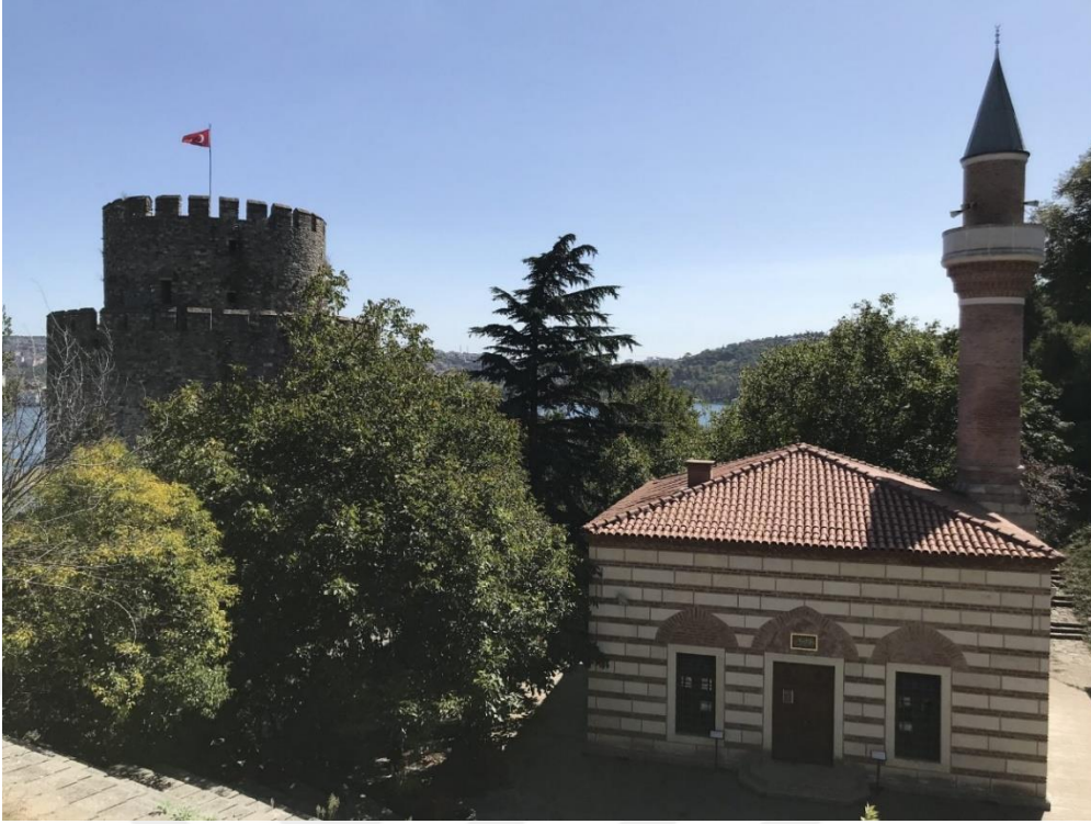
Şekil 6.21 Fetih Camisi'nin 2015 senesinde tamamlanan rekonstrüksiyon uygulaması [F.Yasin Köroğlu'nun fotoğrafı]. (2022).
