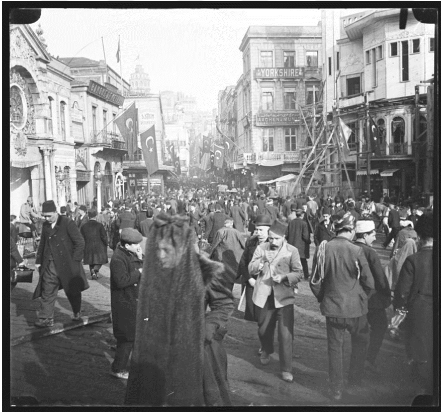
Şekil 4.37 Karaköy Camisi'nin inşaatı sürerken, [Fotoğrafçı bilinmiyor]. (t.y.). Eski İstanbul Fotoğrafları Arşivi.
