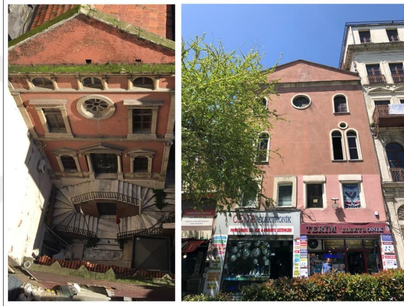
Şekil 3.22 Zülfaris Sinagogu, solda Perçemli Sokak cephesi [Oğuz Otay'ın fotoğrafı]. (2018) ve sağda Kemeraltı Caddesi'ne bakan cephesi [Lütfü Bozkurt'un fotoğrafı]. (2021).
