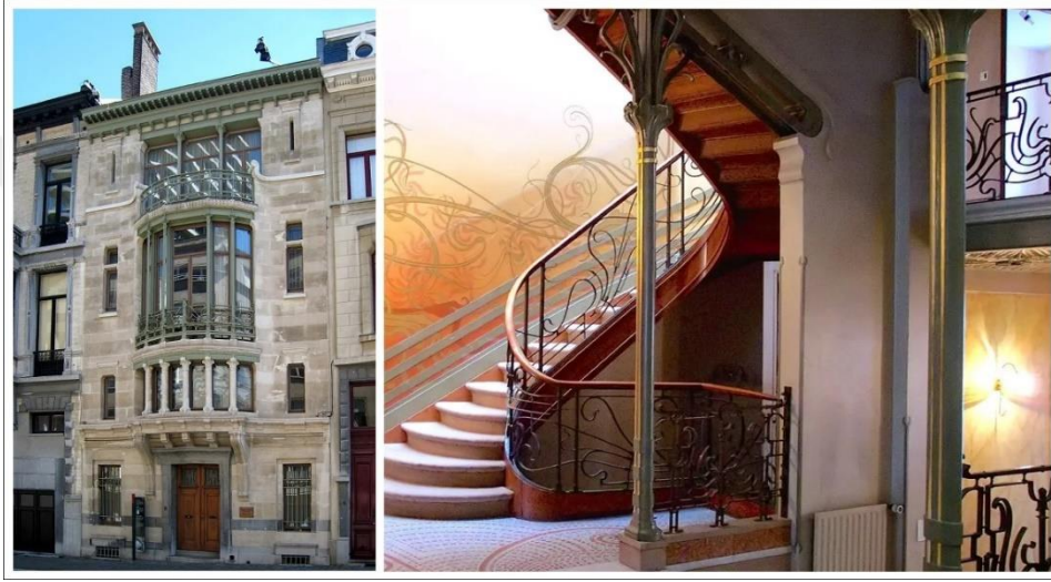
Şekil 2.12 Tassel House,Brüksel (Evgenia Sidelnikova'nın fotoğrafı]. (t.y.).
