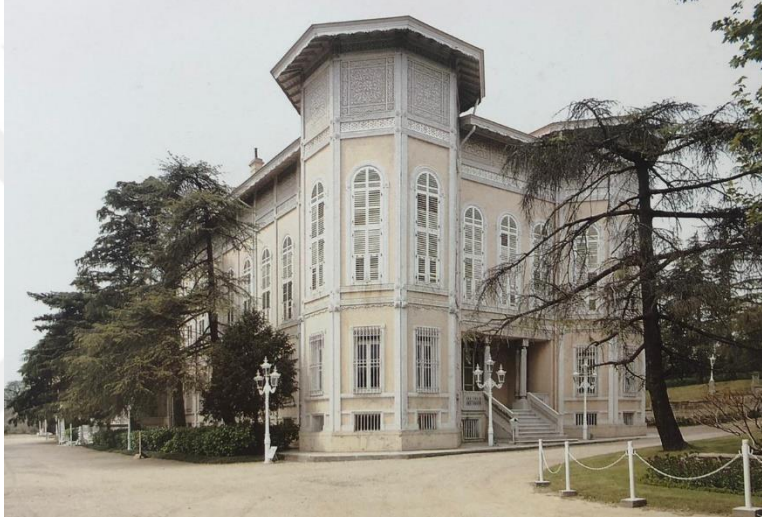
Şekil 4.22 Şale Köşkü (Barillari&Godoli, 1997:75)
