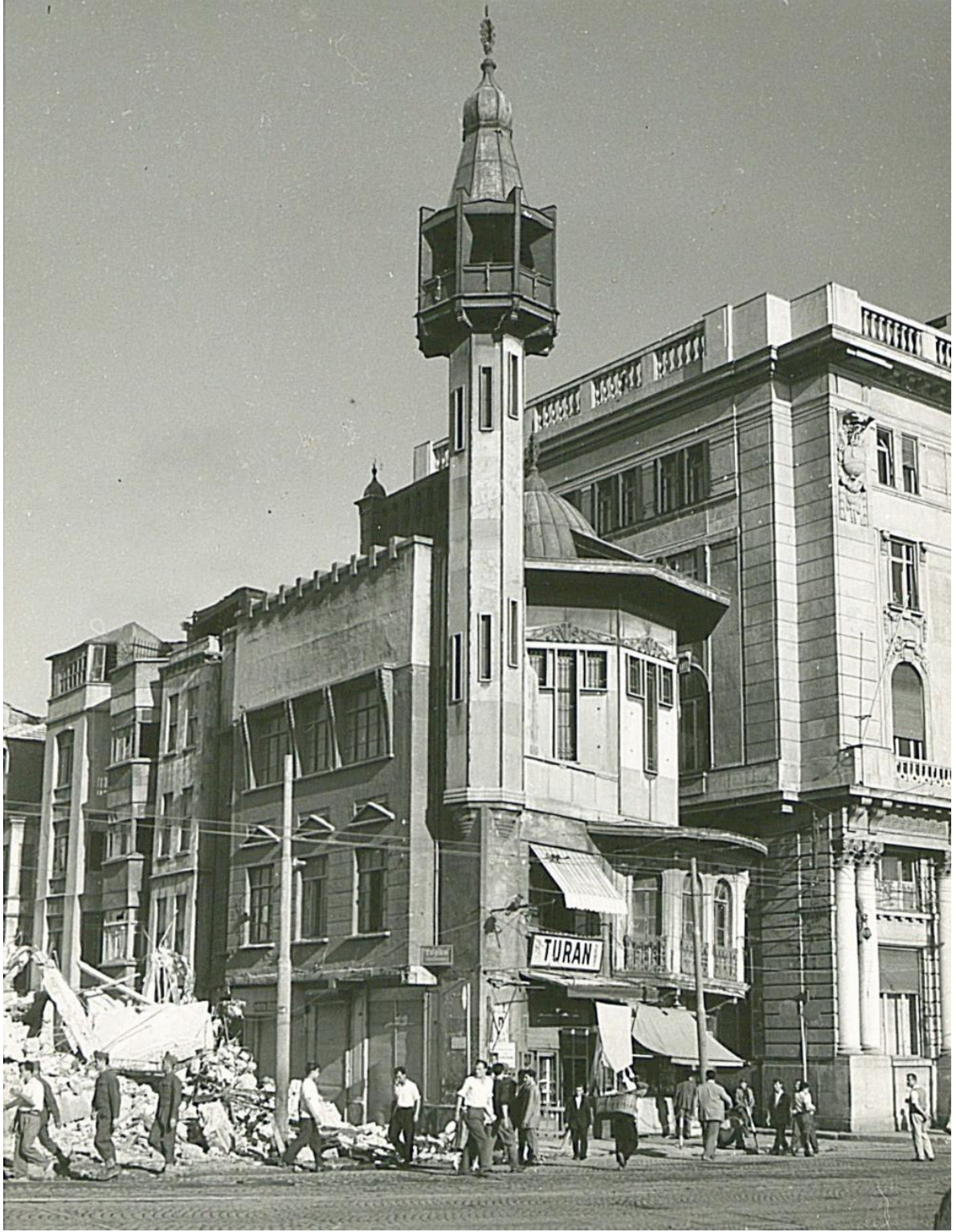
Şekil 5.26 Havvar Han yıkıldıktan sonra, caminin kuzey (giriş) cephesi tamamen görülebiliyor [Fotoğrafçı bilinmiyor]. (1958). Salt Araştırma, Ülgen Ailesi Koleksiyonu, Kod:TASUH0975.
