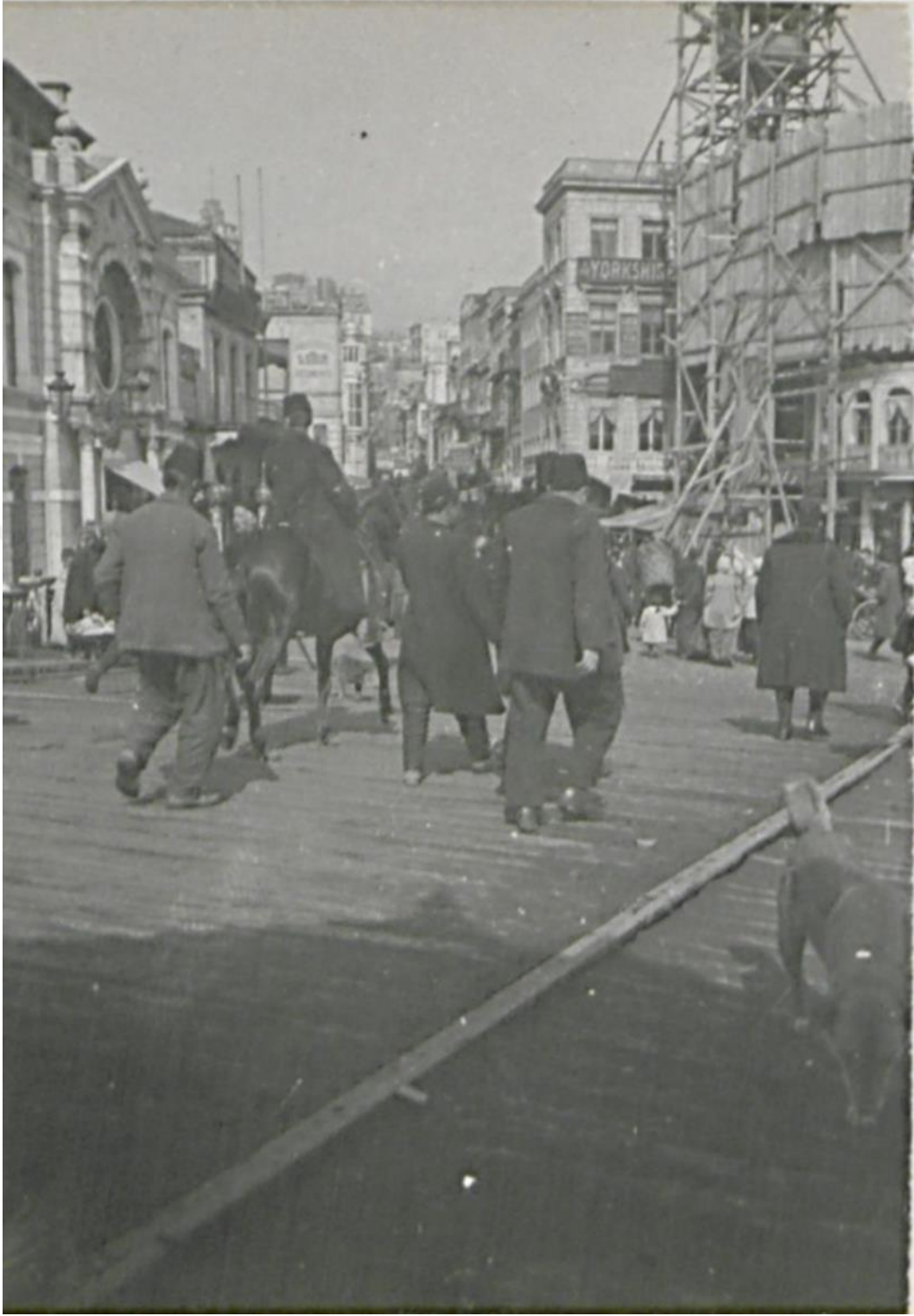
Şekil 4.35 Karaköy Camisi'nin inşaatı sürerken, caminin cephesinde ve minarenin çevresinde iskeleler kurulmuş [Fotoğrafçı bilinmiyor]. (t.y.). Koç Üniversitesi Dijital Koleksiyonu.
