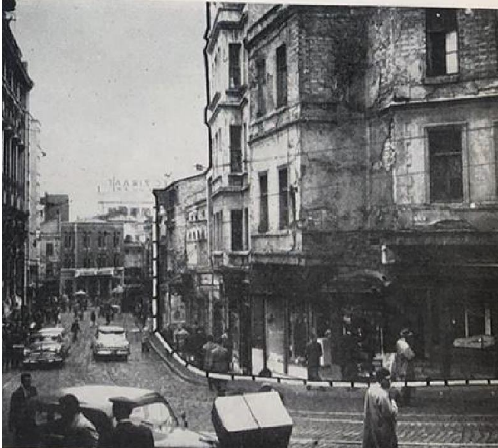
Şekil 5.17 Karaköy Caddesi ve Domuz Sokağı arasındaki yapı adası, istimlak edilecek binalar beyaz kesikli çizgilerle gösterilmiştir (İstanbul'un Kitabı,1958:85).
