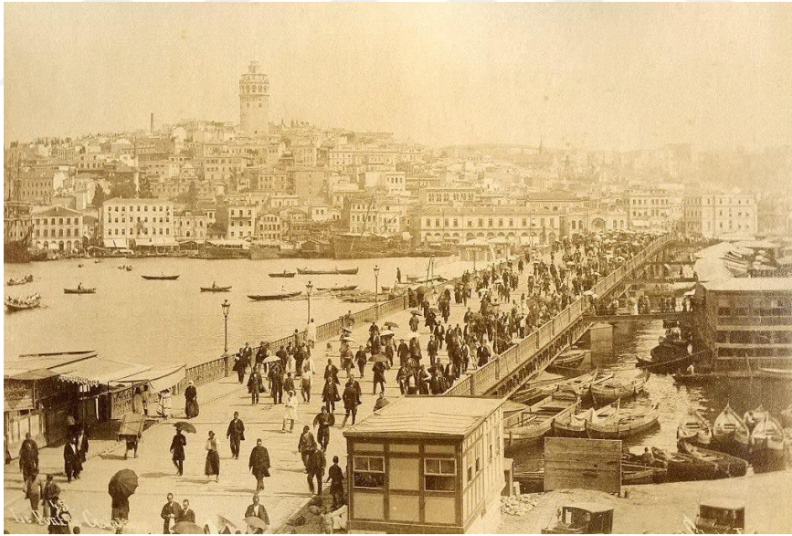
Şekil 2.16 1875-78 yılları arasında demir konstrüksiyonla yapılan Galata Köprüsü, [Sebah&Joillier'nin fotoğrafı]. (t.y.). Eski İstanbul Fotoğrafları Arşivi.
