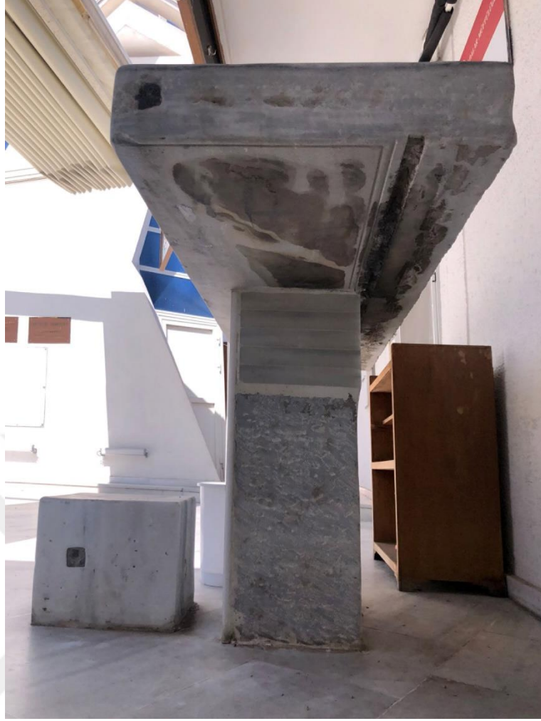
Şekil 5.37 Musalla taşından detay, mermer levhanın alt yüzeyindeki yivler görülmektedir [Yazarın fotoğrafı]. (2023).
