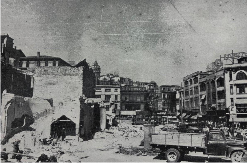
Şekil 5.11 Seyri Sefain Acentası (Vagon Li) Binası'nın yıkılışı, 1956. (İstanbul'un Kitabı, 1958:84).
