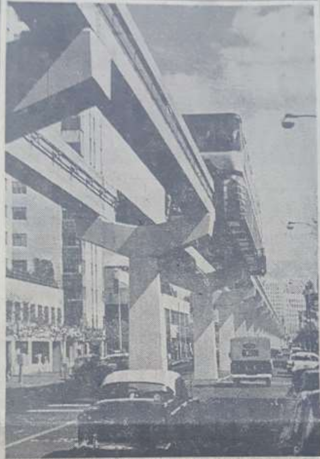
KURULMASI düşünölen havai hat, resimde göröldüğü gibi, caddelerin ortasına dikilen beton direklerin üzerinden kaydırılan elektrikli vagonlardan ibarettir. (Foto: HA)
