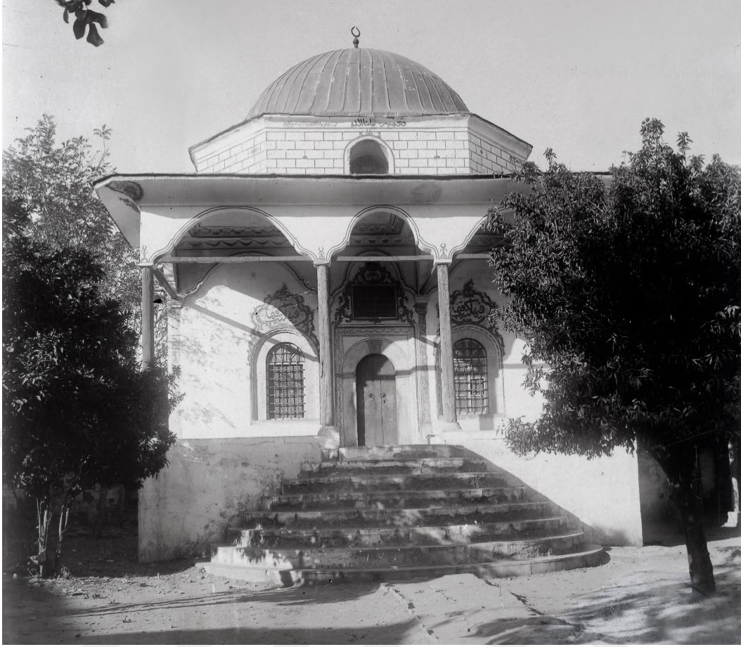
Foto 2.3: Necippaşa Kütüphanesinin Camekânla Kapatılmadan Önceki Hali (M. Topuz Arşivi,1929)
