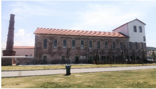
Şekil 4.49. Kırangıç Zeytinyağı Fabrikası’nın ana bina ve bacası
