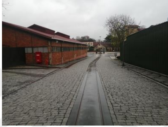
Şekil 3.3. Beykoz Kundura zemindeki ray sistemi
