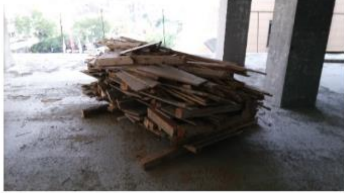
Şekil 4.8. Sahada Ortaya Çıkan Tekrar Kullanılabilecek Malzemenin İstiflenmesi
