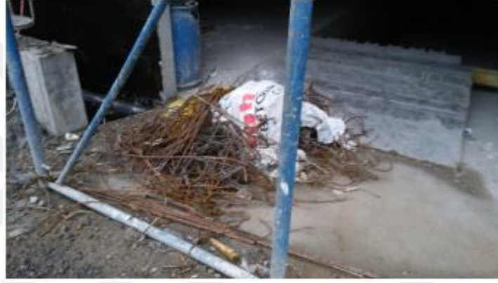
Şekil 4.9. Sahada Ortaya Çıkan Geri Dönüşümü Mümkün Malzemelerin Toplanması
