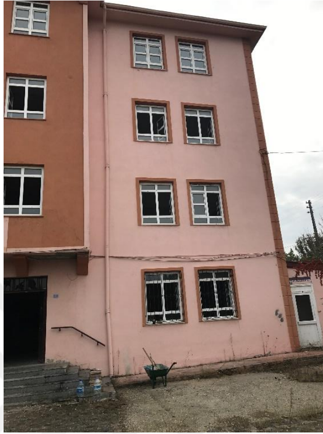
Şekil 4.2. Betonarme yapının görüntüsü
