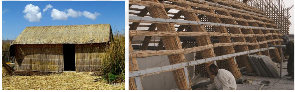
Şekil 2.46. Yapılarda kamış kullanımı (URL 45, URL 46)
