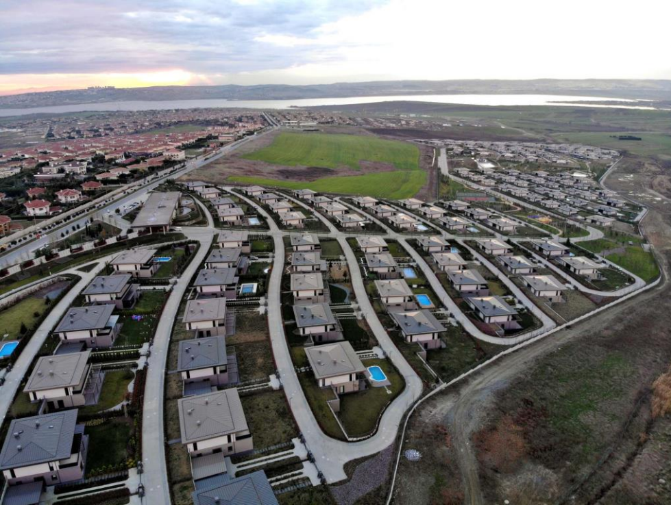
Şekil 4.39. Uygulama alanına ait drone görseli
