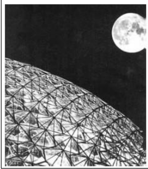
Şekil 2.22. Fuller'in jeodezik kubbesi (Ekoyapı, 2014)
