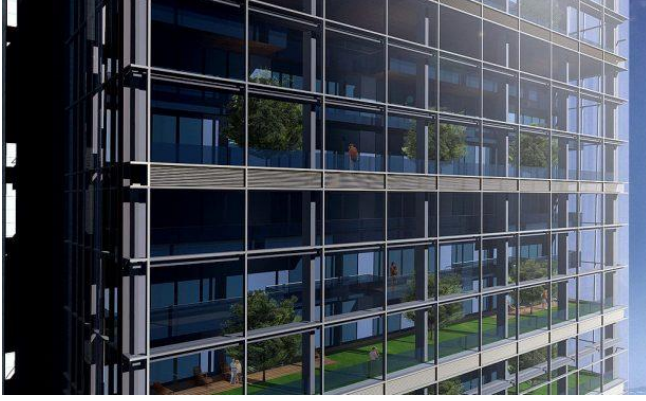
Şekil 4.44. Dikey kat bahçesi dış görünüş (Merdim, 2010)
