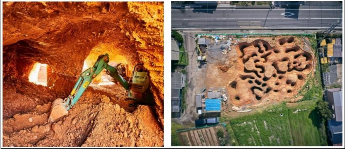
Şekil 4.16. İnşaat süreci (Ott, 2022)
