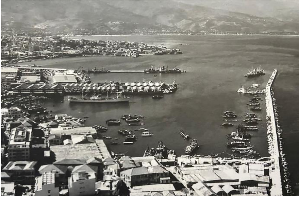
Şekil 2. 28. 1975'te dördüncü havzanın inşaatı [16]
