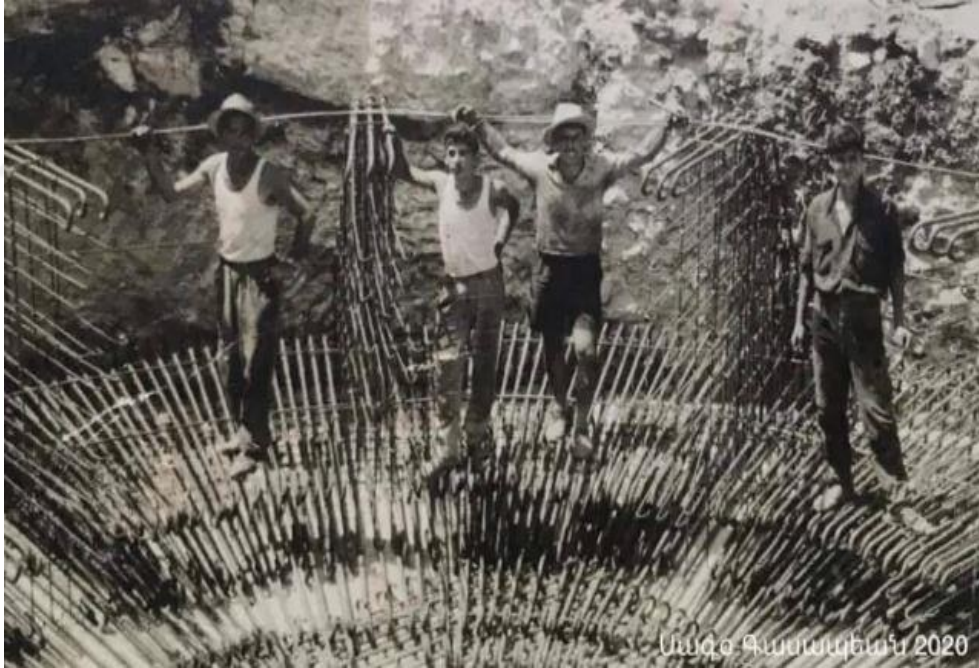
Şekil 2. 27. Yapım aşamasındaki Beyrut Siloları (1968-1970) – Sarkis Joulfayan [17]
