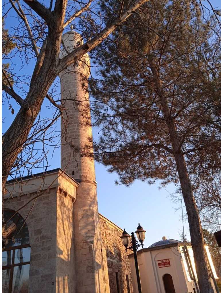
Resim 4. IV. Murat Cami Kuzeybatı Köşesindeki Minaresi
