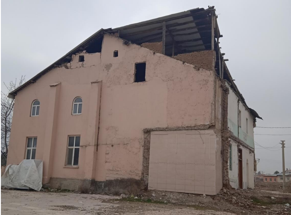
Resim 92. Aksaray (Iğiki) Cami Doğu Cephesi
