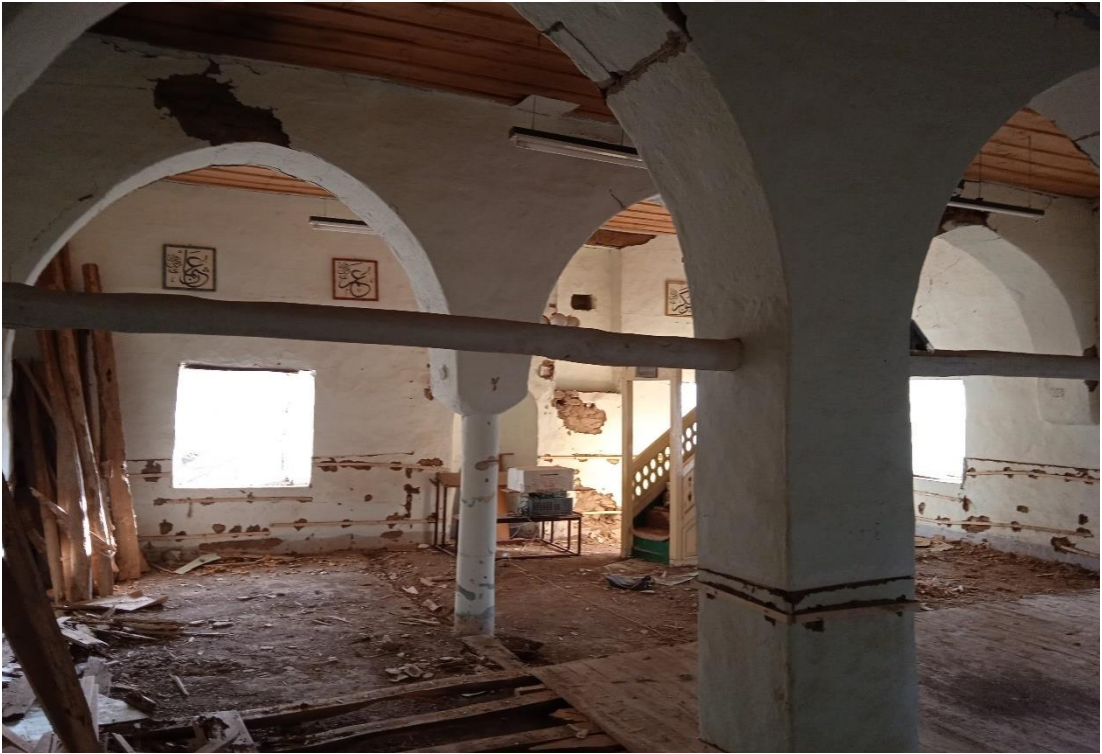
Resim 77. Cevzlidere (Kürdemlikhas) Cami Güney Yönündeki Pencere Açıkları
