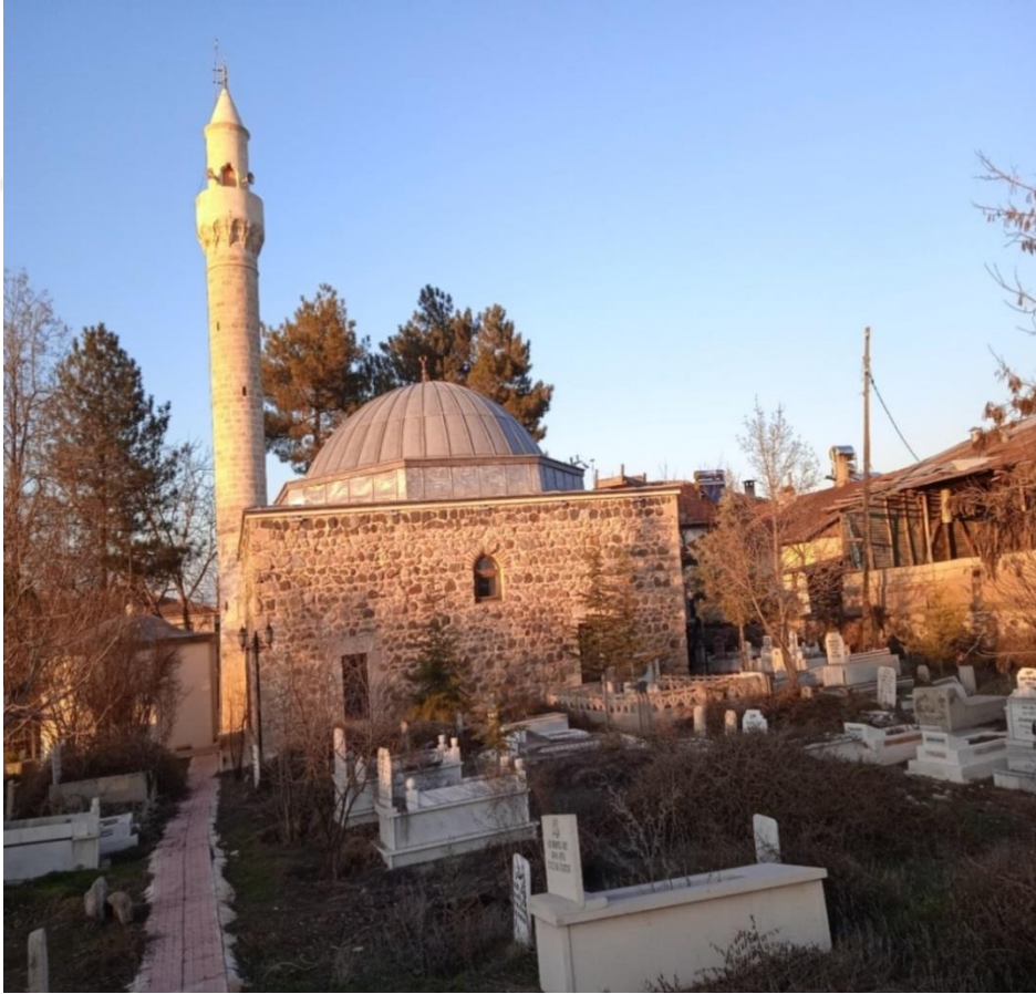
Resim 3. IV. Murat Cami Güney Cephesi
