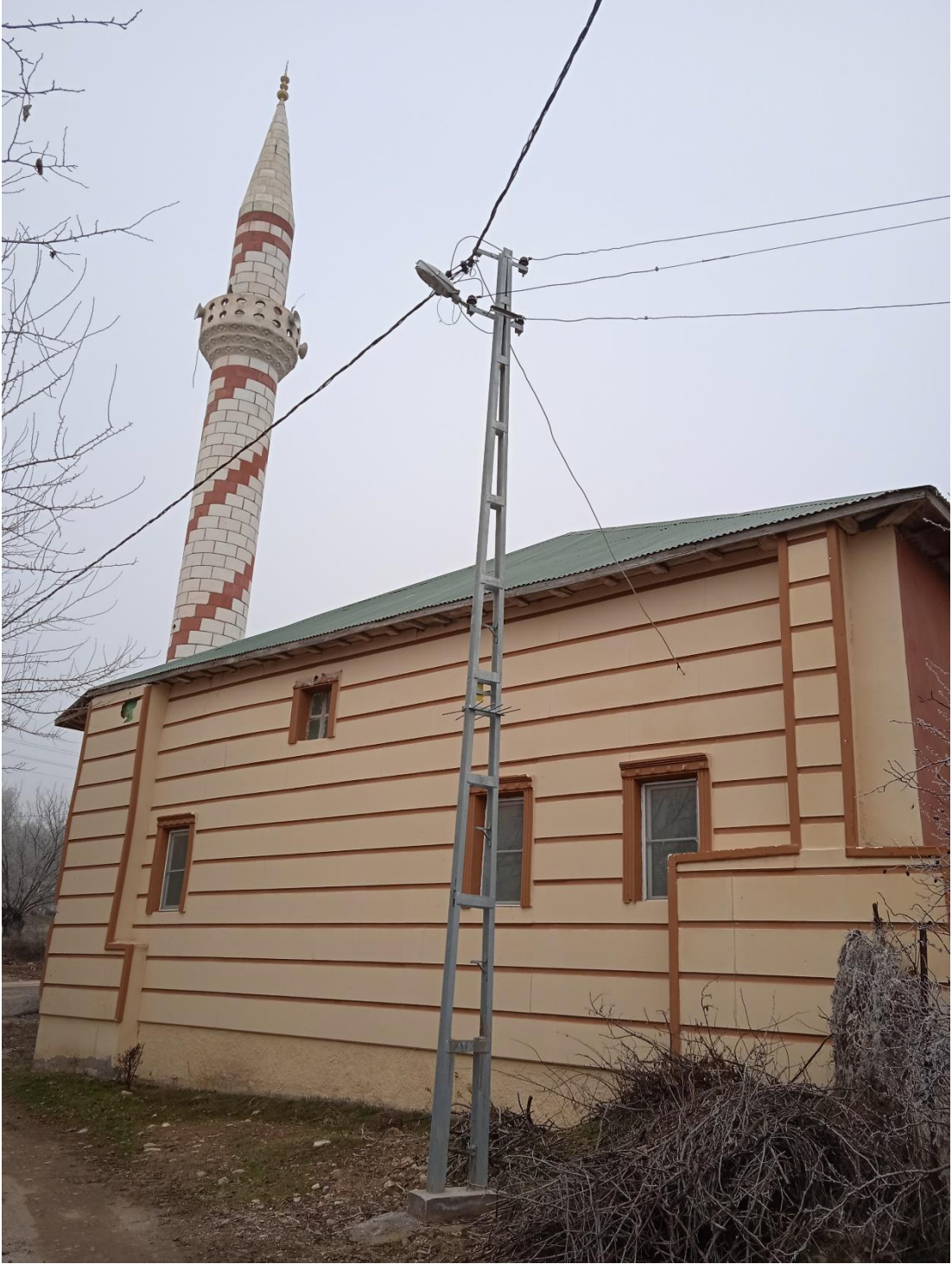
Resim 56. Yenikonak (Mesti) Cami Batı Cephesi
