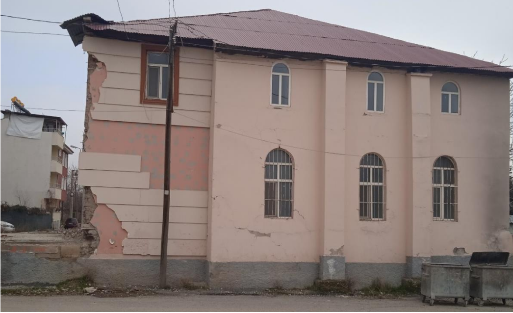
Resim 90. Aksaray (İğiki) Cami Batı Cephesi
