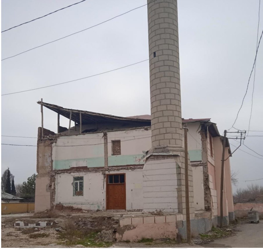
Resim 91. Aksaray (Iğiki) Cami Girişi
