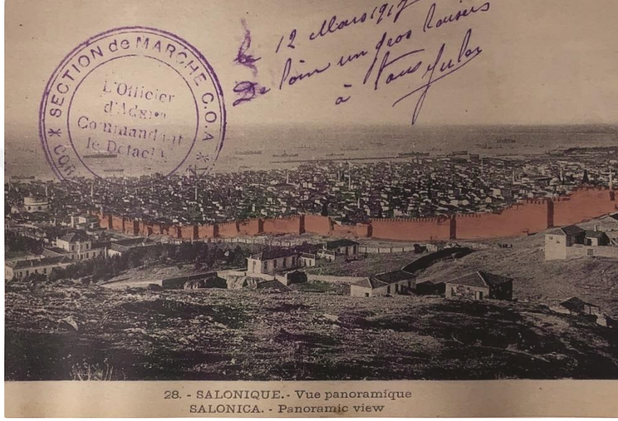
Şekil 4.59 : Şehre panoramik bakış (Ünlü, 2006, s. 2) (Kırmızı tarafından düzenlenmiştir). Kartpostalda; kentin kuzeydoğusunda bulunup, surların dışından denize doğru bakış ve kentin üst kısmından neredeyse sahile kadar uzanan doğu duvarı görülmektedir. Kent merkezi ve yerleşimi çoğunlukla surların içinde olup, sur dışında oldukça seyrek yerleşimler bulunmaktadır.
