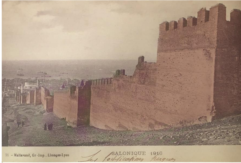
Şekil 4.51 : Surlardan deniz cihetine bakış (Ünlü, 2006, s. 39) (Kırmızı tarafından düzenlenmiştir). Kartpostalda; kentin üst kısmından denize doğru bakış, doğu duvarının kentin tepesinde kalan kısmı ve duvarın sonlarında kentin önemli yapılarından Rotunda görülmektedir.
