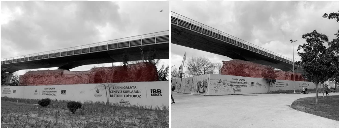
Şekil 4.95 / Şekil 4.96 : Haliç Metro Köprüsü altında Galata Ceneviz Sur Duvarı (Kırmızı, 2023) (Kırmızı tarafından düzenlenmiştir).
