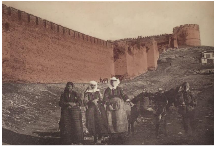
Şekil 4.47 : Şehrin yukarı kesiminde yer alan surlar (Ünlü, 2006, s. 41) (Kırmızı tarafından düzenlenmiştir). Şekil 4.46 ve Şekil 4.47'deki kartpostallarda; kentin üst bölgesinde bulunan sur duvarları ve oldukça seyrek yerleşim yerleri ile bölgede geçiş halinde ve çeşme başında olan insanlar bulunmaktadır.
