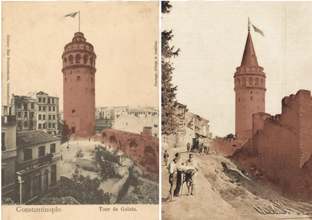
Şekil 4.69 : Solda, Galata Kulesi ve sur duvarları kalıntıları (URL-11) (Kırmız tarafından düzenlenmiştir).
