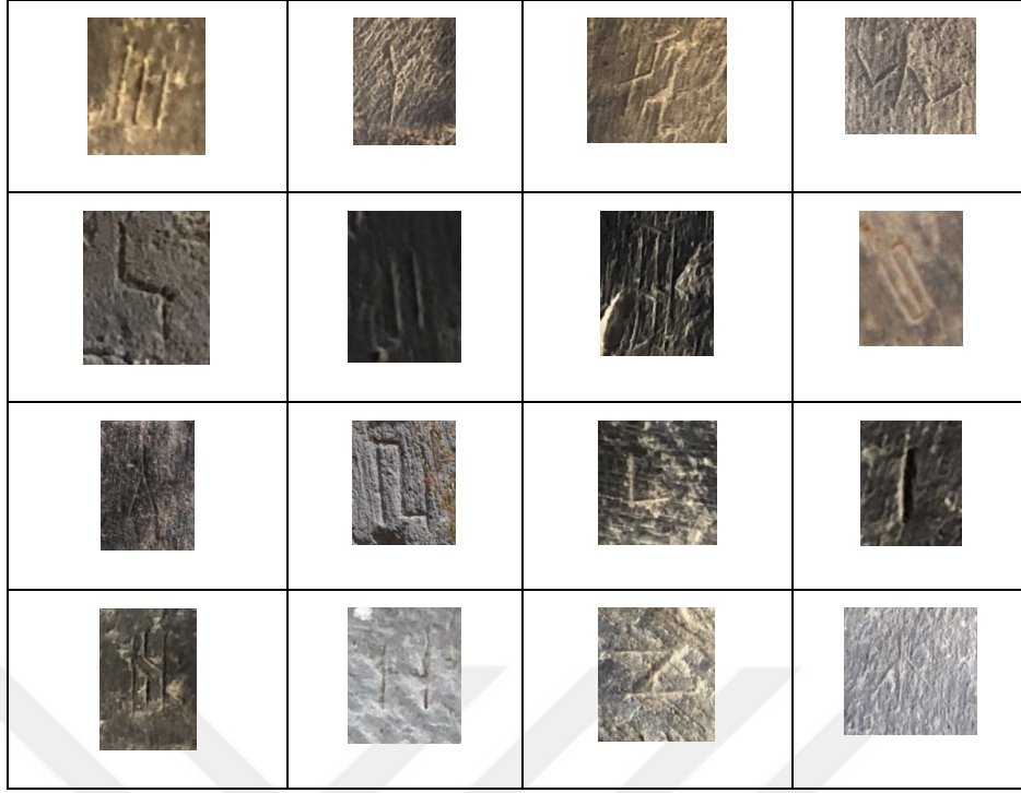
Şekil 5.8 Adilcevaz Kervansarayı üzerinde tespit edilen taşçı işaretleri
