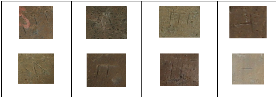
Şekil 5.10 Şeyh Garip Hanı üzerinde tespit edilen taşçı işaretleri
