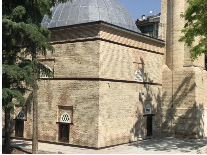
Şekil 17. Hoca Hasan Camii’de kullanılan taş malzemesi, 2023
