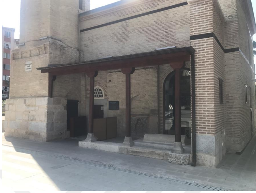
Şekil 5. Hoca Hasan Camii’de kullanılan ahşap malzeme, 2023
