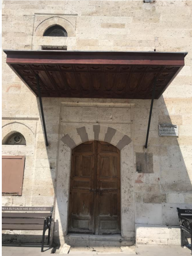
Şekil 6. Şerafeddin Camii’de kullanılan ahşap malzeme, 2023
