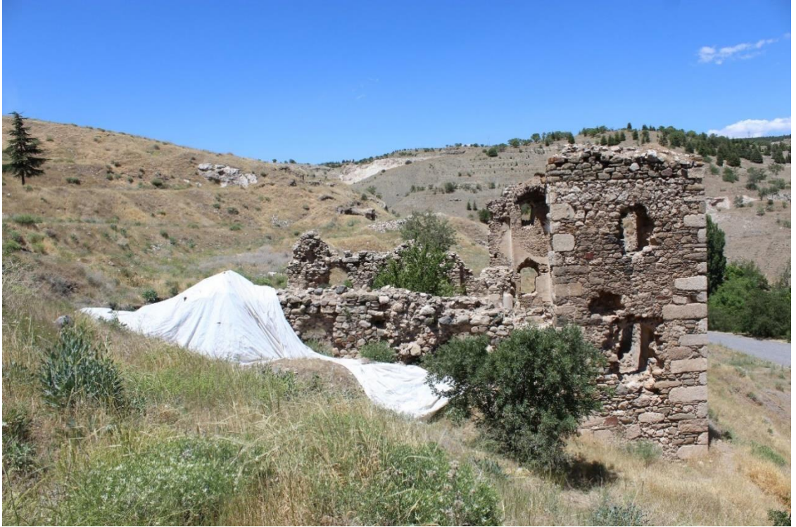
Foto. 42: Merkez ilçesi Gürcü Bey Mahallesi Surp Garabed (Kızıl) Manastır Kilisesi güney cephesi
