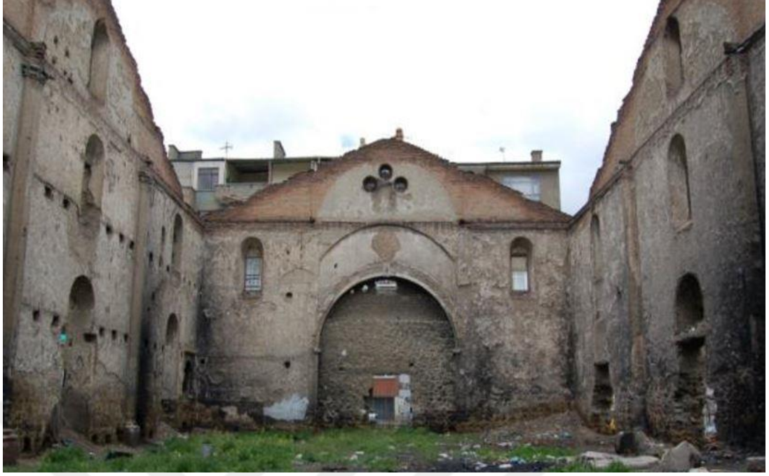
Foto. 153: Merkez ilçesi İzzetpaşa Mahallesi Protestan Kilisesi doğu duvarı (Ş. Öztürk Arşivi)
