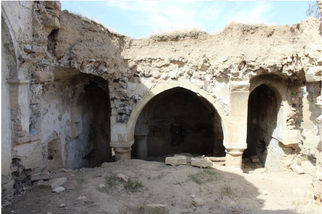
Foto. 22: Merkez ilçesi Şahinkaya Mahallesi Saint Georges (Hulevank) Manastır Kilisesi batı duvarı (jamatuna giriş)
