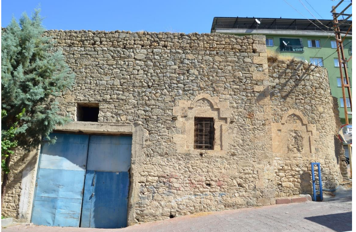
Foto. 96: Keban ilçesi Kallar Mahallesi Kilisesi güney cephesi
