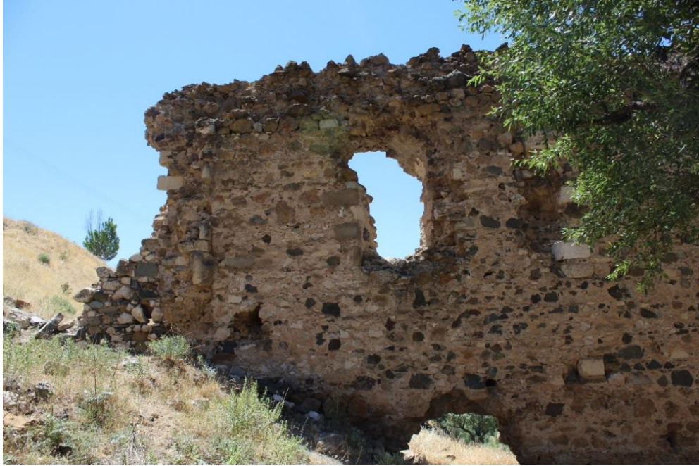
Foto. 160: Merkez ilçesi Kuyumcular Mahallesi Surp Hagop Kilisesi güney duvarı detayı
