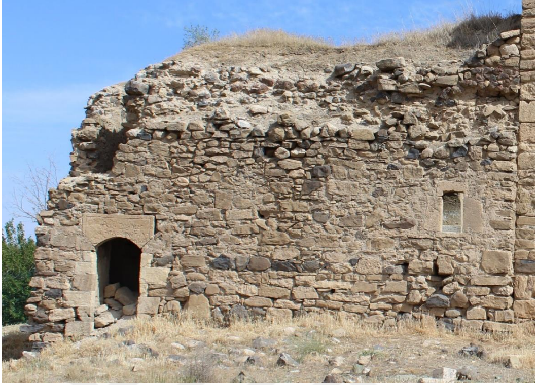
Foto. 31: Merkez ilçesi Şahinkaya Mahallesi Saint Georges (Hulevank) Manastır Jamatunu güney cephesi
