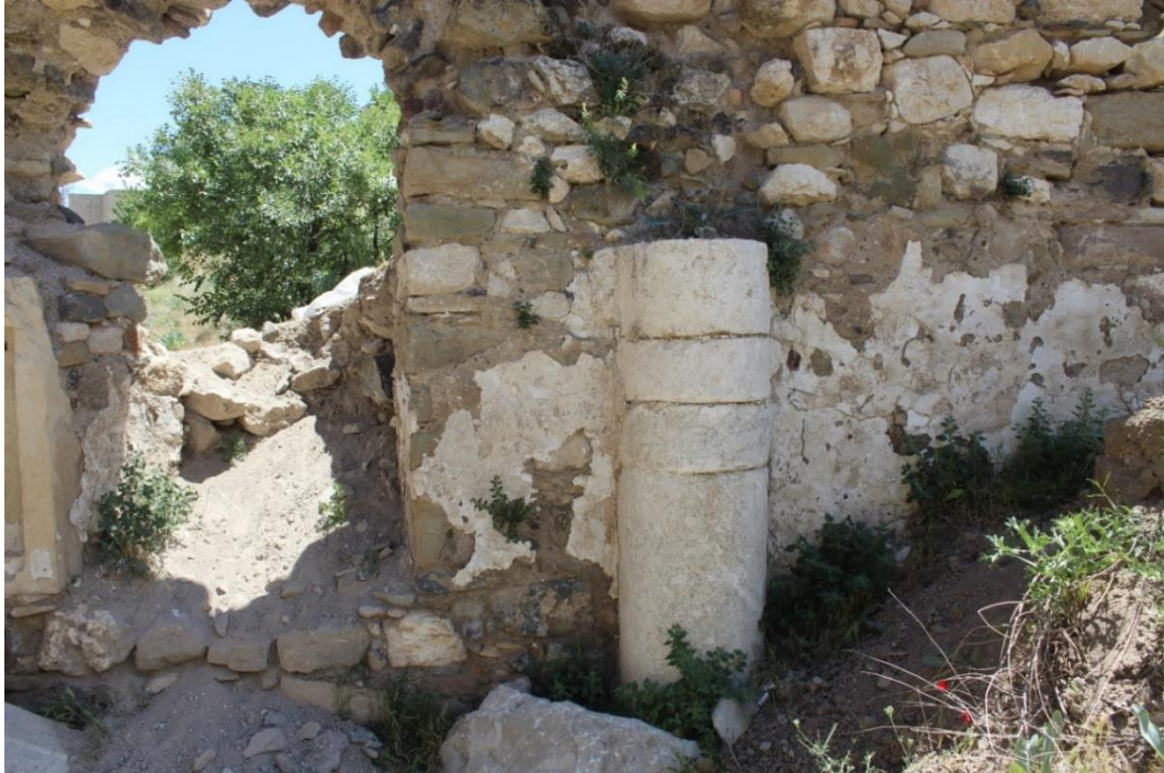
Foto. 46: Merkez ilçesi Gürcü Bey Mahallesi Surp Garabed (Kızıl) Manastır Kilisesi güney duvarındaki üst örtü taşıyıcı detayı
