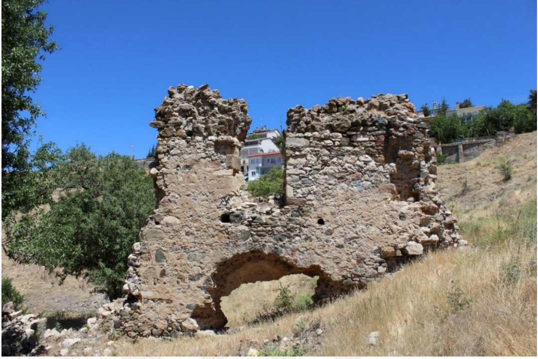
Foto. 157: Merkez ilçesi Kuyumcular Mahallesi Surp Hagop Kilisesi kuzey duvarı
