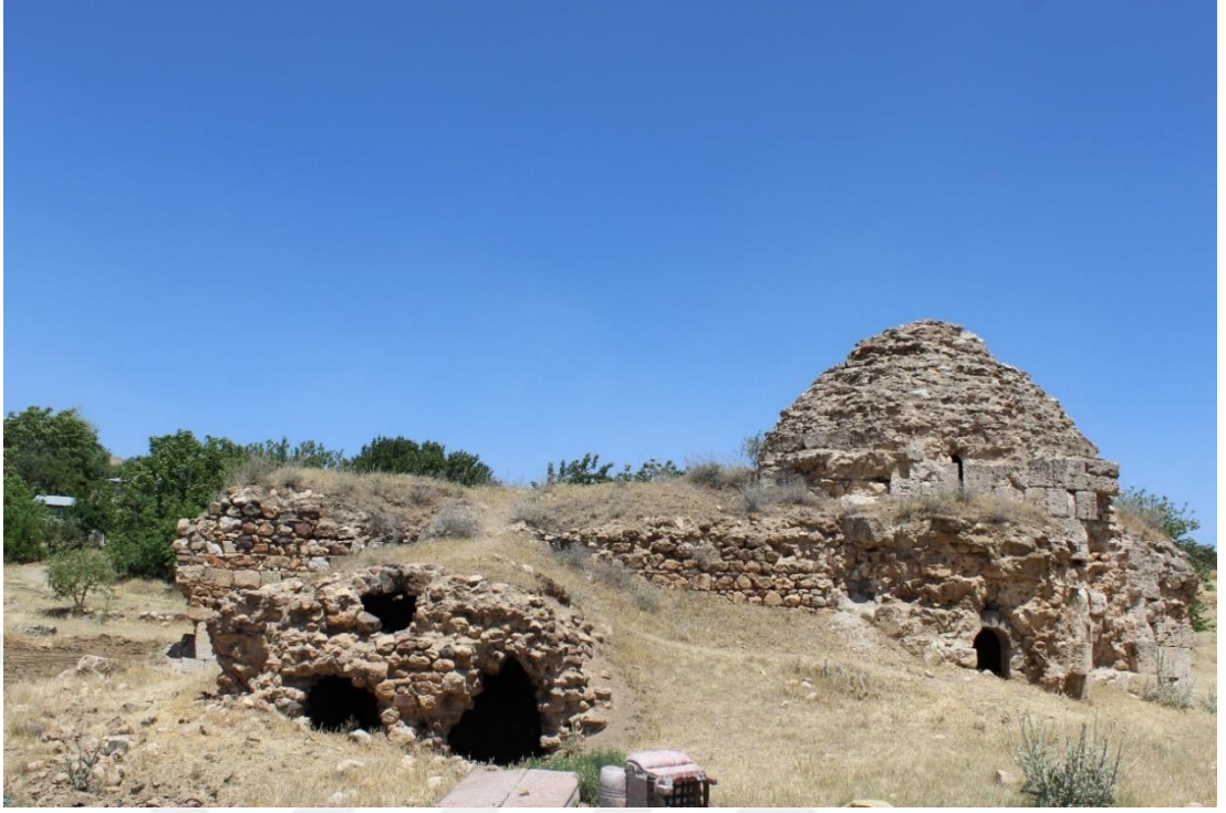
Foto. 59: Merkez ilçesi Yalnız köyü Surp Simon (Tadım / Asdvadzadzin) Manastır Jamatunu güney duvarı
