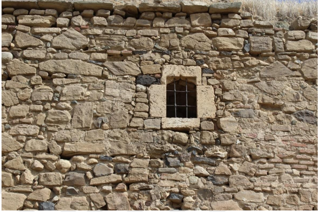
Foto. 21: Merkez ilçesi Şahinkaya Mahallesi Saint Georges (Hulevank) Manastır Kilisesi güney cephesindeki giriş kapısının sağ üzerindeki pencere
