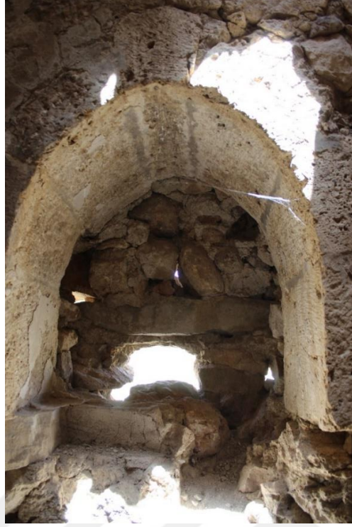
Foto. 67: Merkez ilçesi Yalnız köyü Surp Simon (Tadım / Asdvadzadzin) Manastır Jamatunu kuzeydoğu ek mekânın diğer niş detayı
