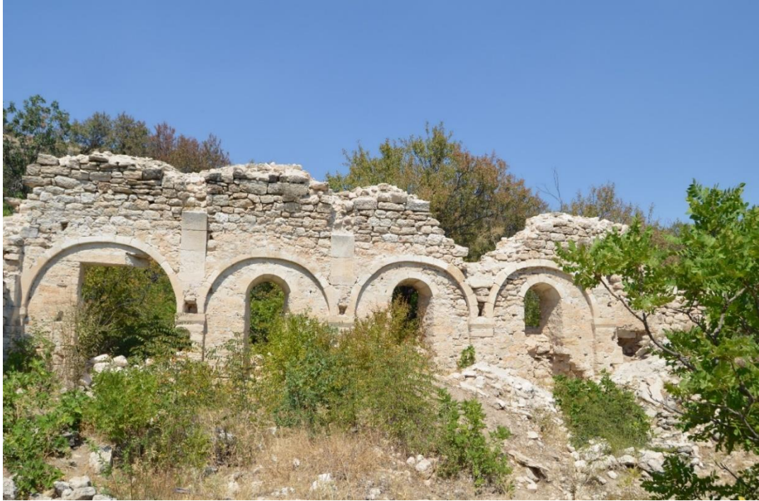
Foto. 92: Ağın ilçesi Beyelması köyü Surp Asdvadzadzin (Küşne) Kilisesi kuzey duvarı
