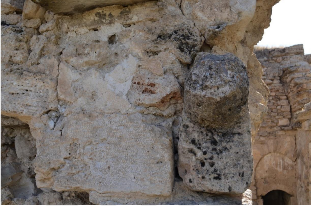
Foto. 119: Kovancılar ilçesi Ekinözü (Habab) köyü Surp Gatoğige (Meryem Ana) Kilisesi batı cephesindeki devşirme malzeme detayı
