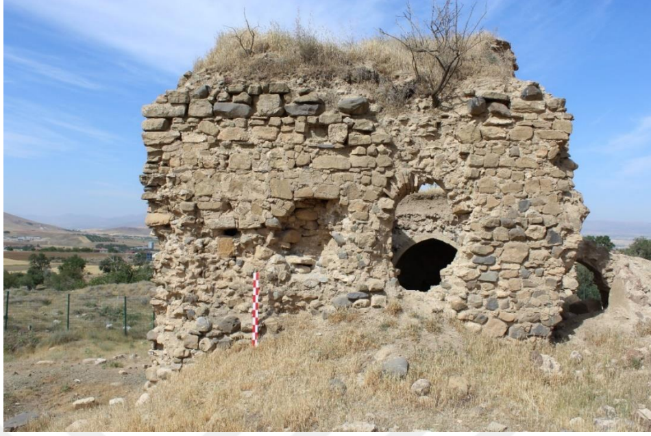
Foto. 17: Merkez ilçesi Şahinkaya Mahallesi Saint Georges (Hulevank) Manastır Kilisesi doğu cephesi
