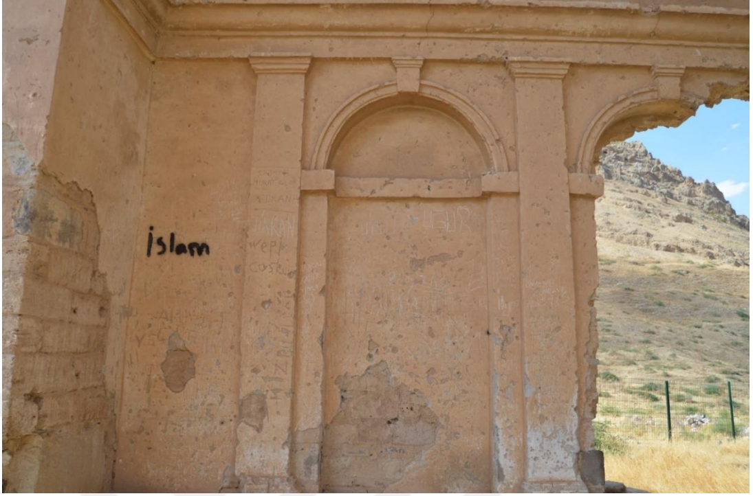
Foto. 177: Palu ilçesi Aşağı Palu Çarşıbaşı Mahallesi Surp Krikor Lusavoriç (Keklikdere) Kilisesi kuzey duvarı detayı
