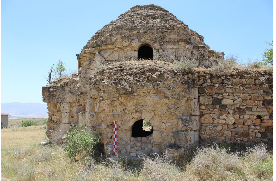
Foto. 48: Merkez ilçesi Yalnız köyü Surp Simon (Tadım / Asdvadzadzin) Manastırı Kilisesi kuzey cephesi
