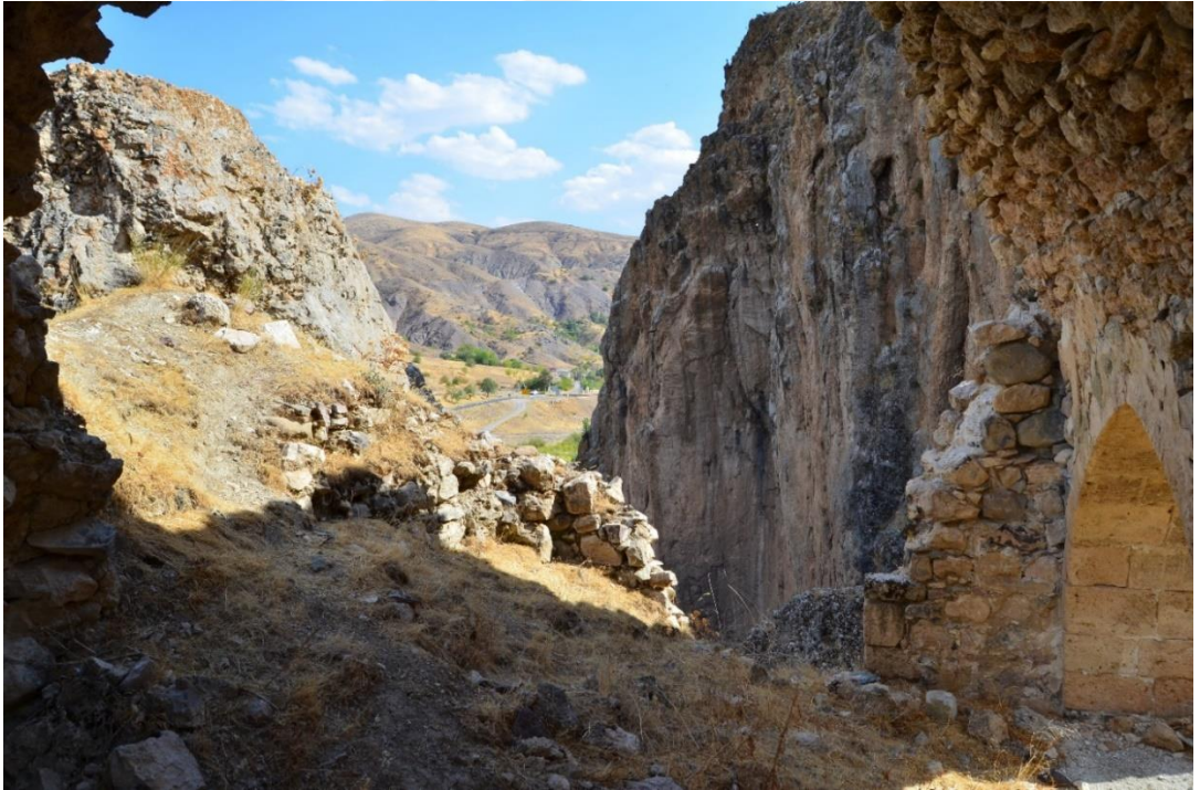
Foto. 170: Palu ilçesi Aşağı Palu Mahallesi Kindik Kilisesinin apsis bölümü güney duvarı
