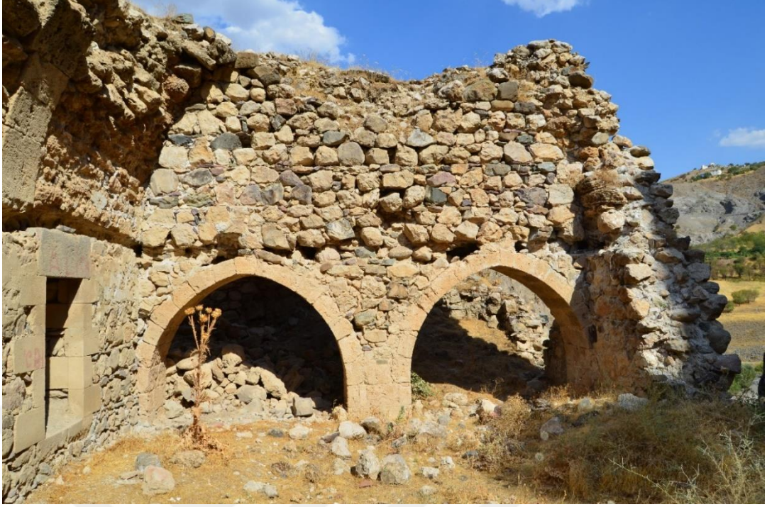
Foto. 167: Palu ilçesi Aşağı Palu Mahallesi Kindik Kilisesi doğu duvarı
