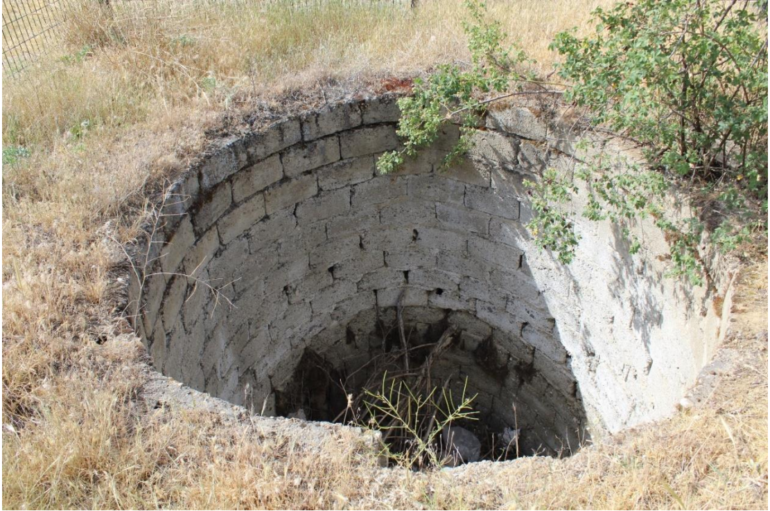
Foto. 36: Merkez ilçesi Şahinkaya Mahallesi Saint Georges (Hulevank) Manastır sarnıcı
