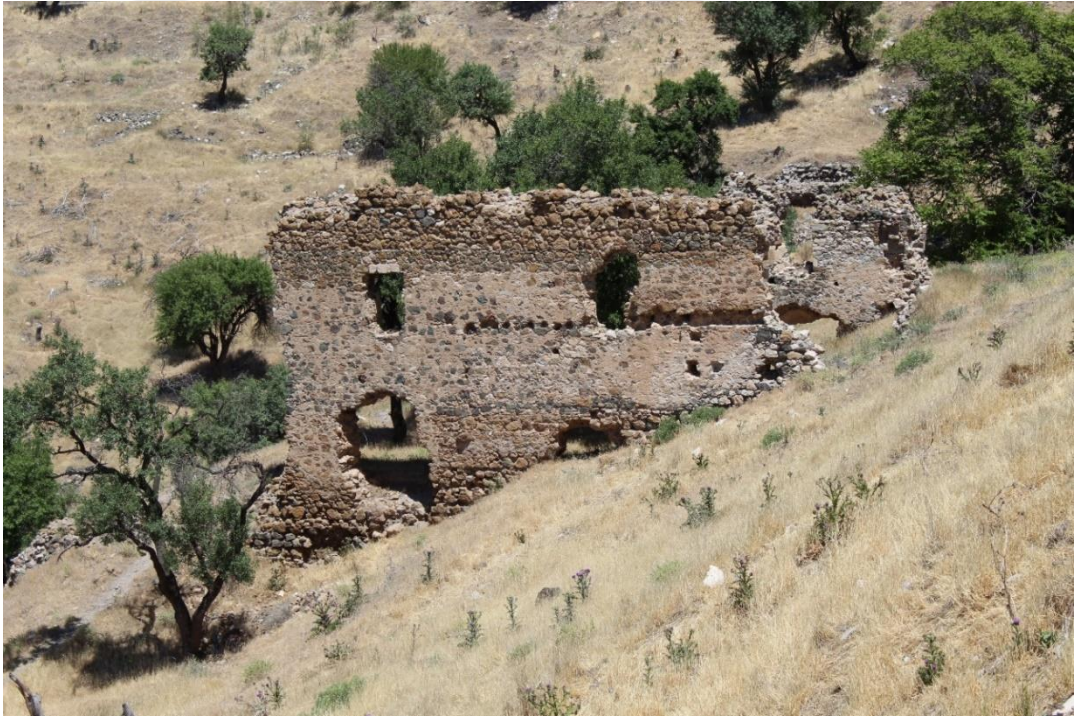
Foto. 156: Merkez ilçesi Kuyumcular Mahallesi Surp Hagop Kilisesi güney cephesi
