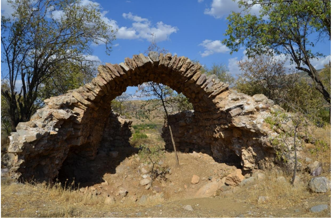
Foto. 191: Palu ilçesi Keklikdere köyü Surp Sarkis (Tirke) Kilisesi batı cephesi
