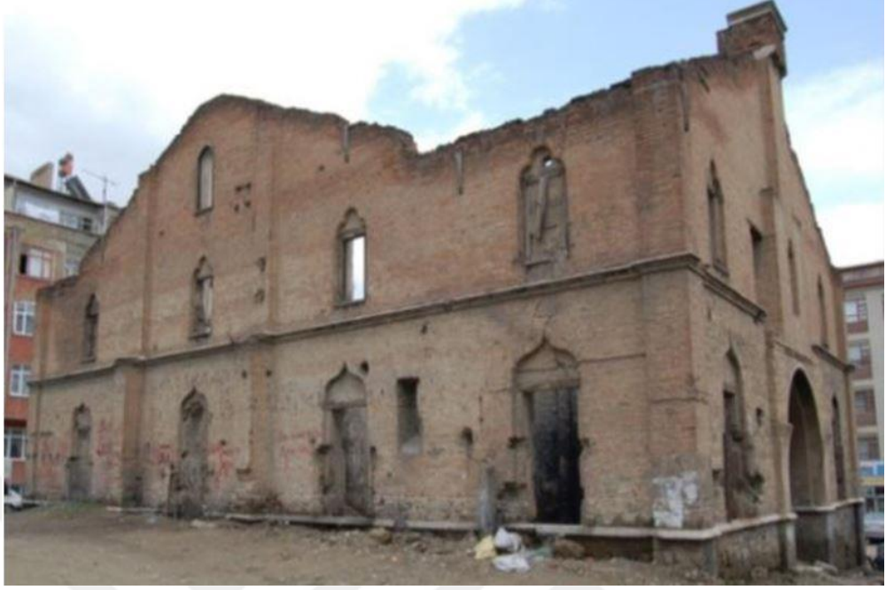
Foto. 147: Merkez ilçesi İzzetpaşa Mahallesi Protestan Kilisesi kuzey cephesi (Ş. Öztürk Arşivi)
