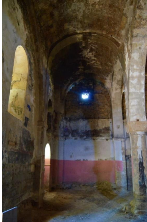
Foto. 100: Keban ilçesi Kallar Mahallesi Kilisesi batı duvarı detayı
