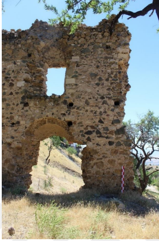
Foto. 159: Merkez ilçesi Kuyumcular Mahallesi Surp Hagop Kilisesi güney duvarı detayı
