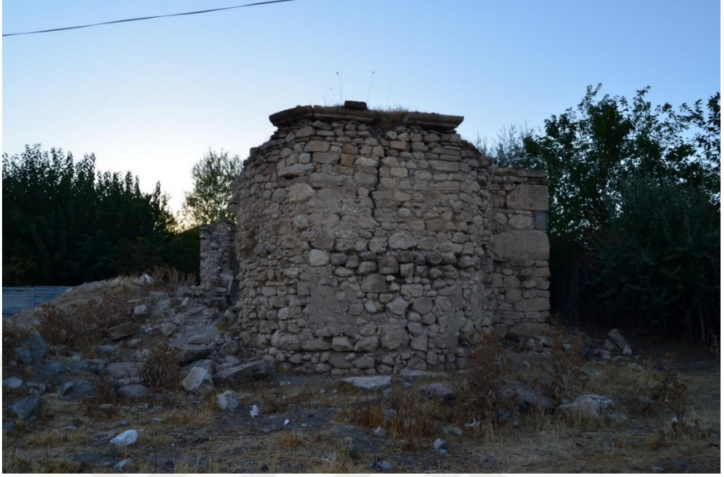
Foto. 133: Kovancılar ilçesi Karınca köyü Surp Kevork Kilisesi doğu cephesi
