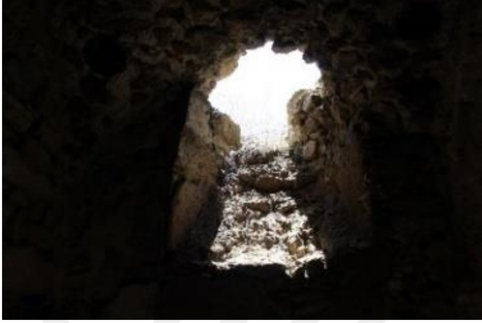
Foto. 71: Merkez ilçesi Yalnız köyü Surp Simon (Tadım / Asdvadzadzin) Manastır Jammatunu güney duvarındaki güneydoğudaki pencere detayı
