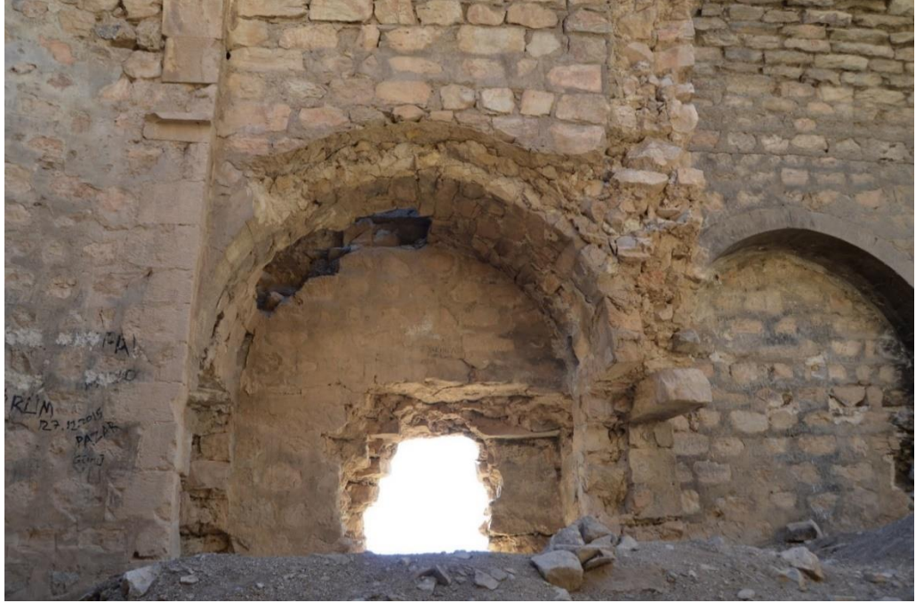
Foto. 212: Baskil ilçesi Işıklar köyü Mor Ahron (Muşar Dağı) Manastır Kilisesi bema güney duvarı
