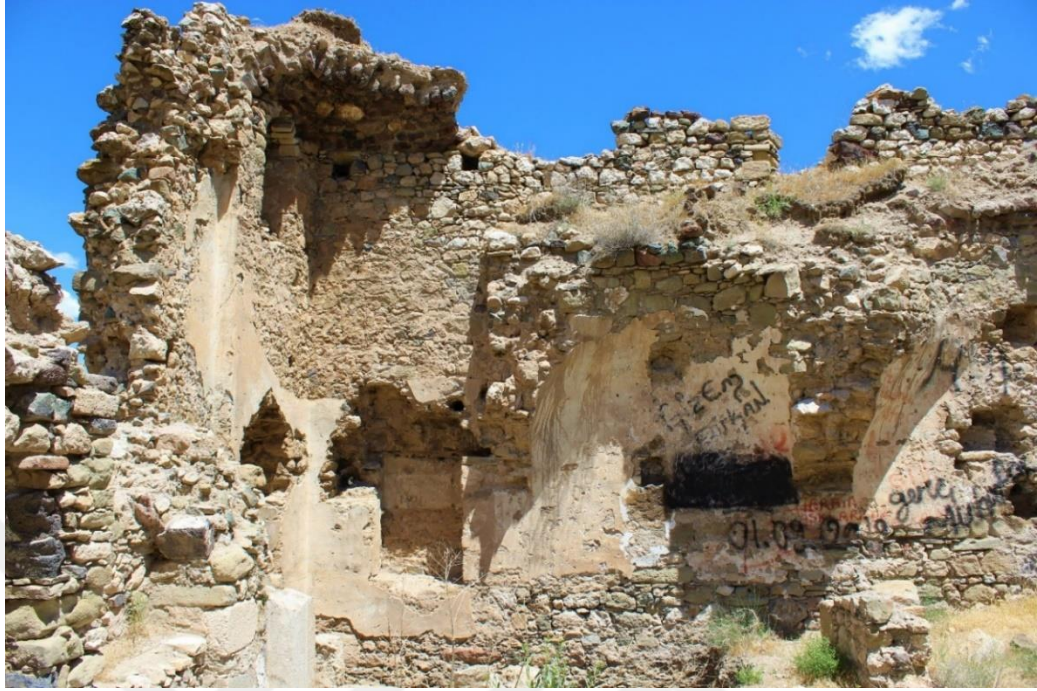
Foto. 45: Merkez ilçesi Gürcü Bey Mahallesi Surp Garabed (Kızıl) Manastır Kilisesi doğu duvarı detayı
