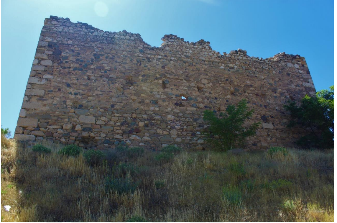
Foto. 41: Merkez ilçesi Gürcü Bey Mahallesi Surp Garabed (Kızıl) Manastır Kilisesi doğu cephesi
