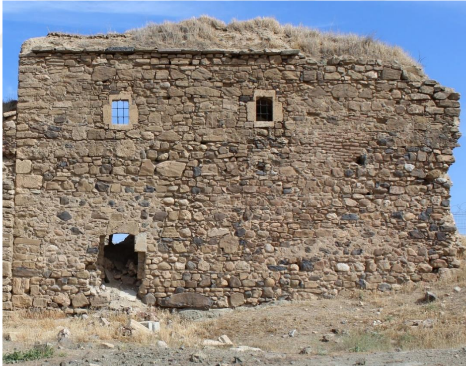
Foto. 18: Merkez ilçesi Şahinkaya Mahallesi Saint Georges (Hulevank) Manastır Kilisesi güney cephesi
