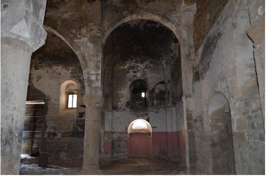
Foto. 107: Keban ilçesi Kallar Mahallesi Kilisesi güney duvarı detayı
