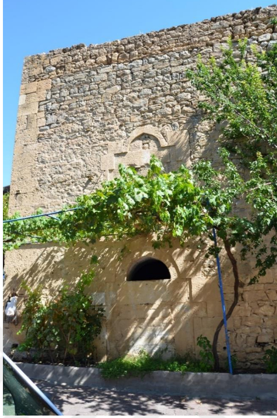
Foto. 97: Keban ilçesi Kallar Mahallesi Kilisesi güney cephesi
