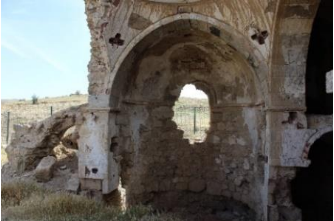
Foto. 24: Merkez ilçesi Şahinkaya Mahallesi Saint Georges (Hulevank) Manastır Kilisesi doğu duvarı
