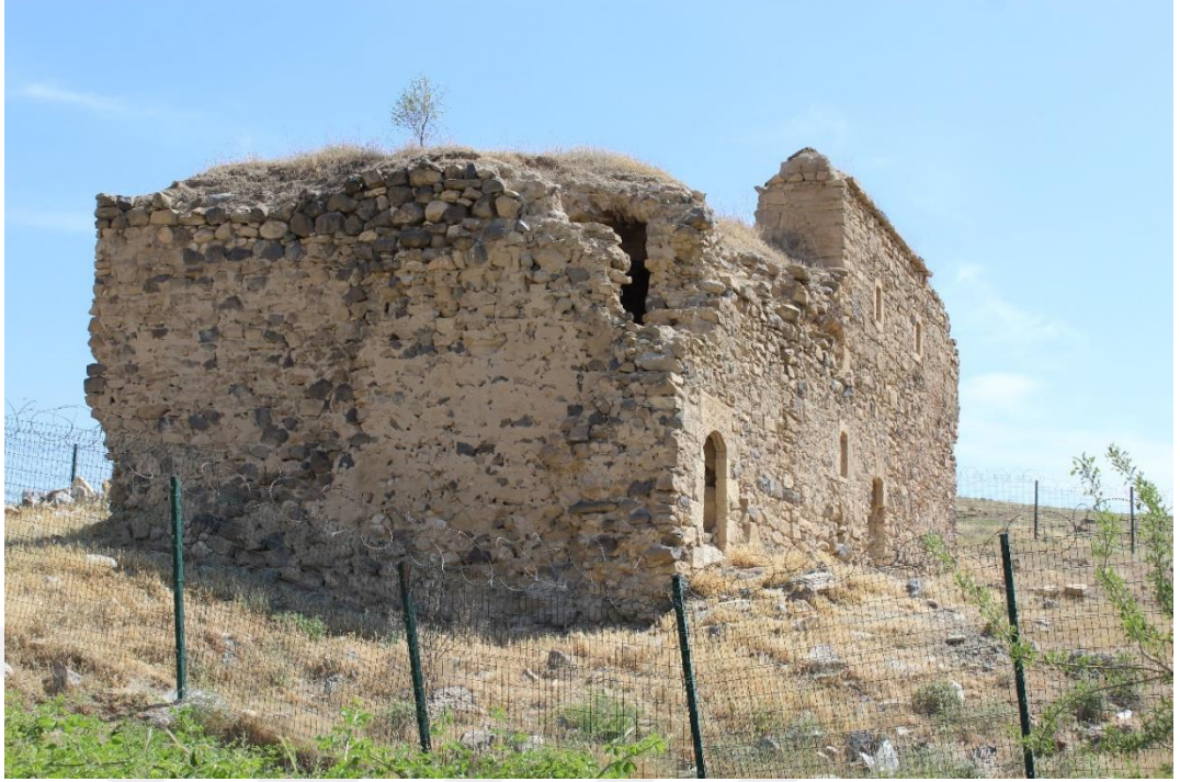
Foto. 15: Merkez ilçesi Şahinkaya Mahallesi Saint Georges (Hulevank) Manastır Kilisesi batı cephesi
