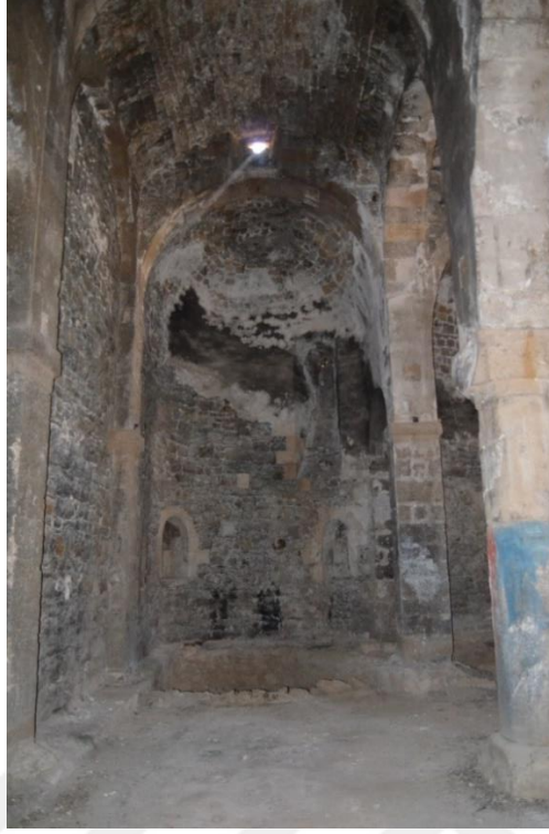
Foto. 103: Keban ilçesi Kallar Mahallesi Kilisesi doğu duvarı kuzeydoğu apsidiyolu
