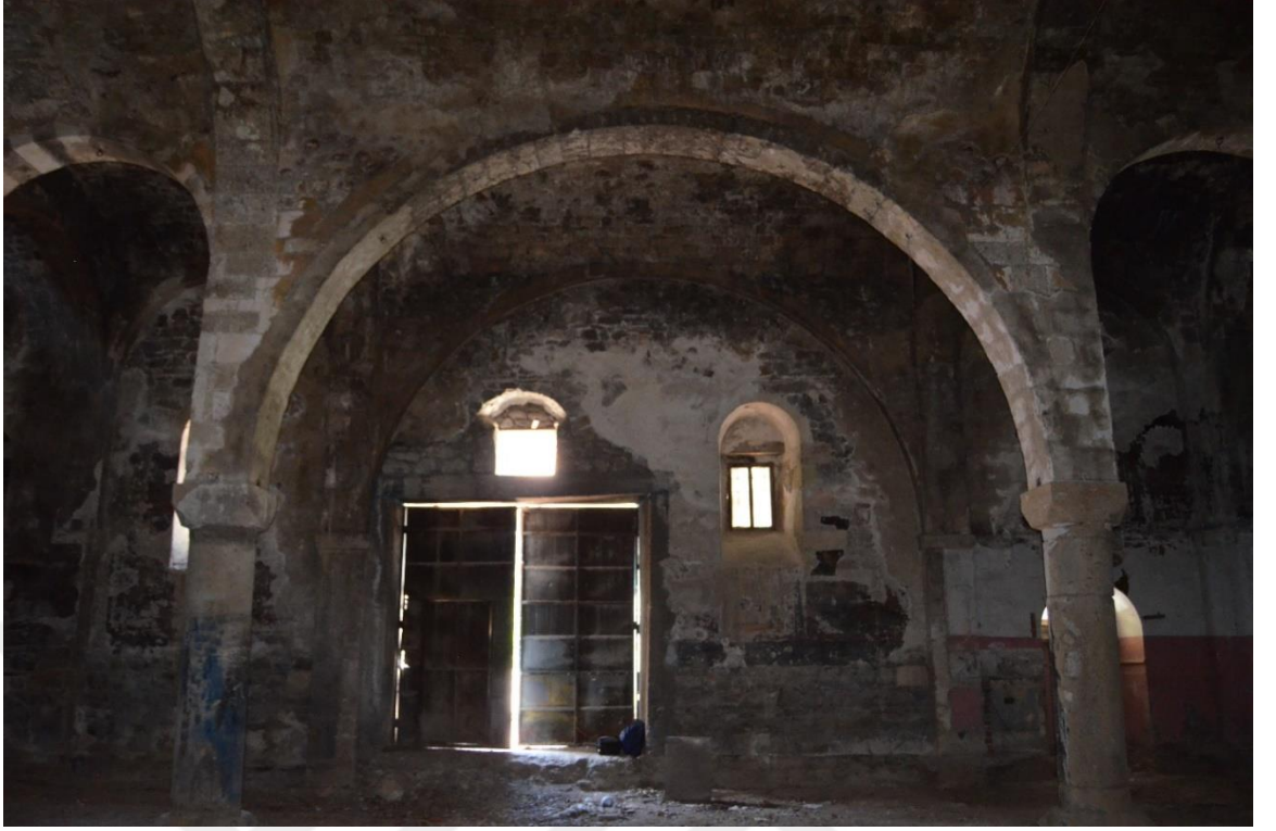
Foto. 105: Keban ilçesi Kallar Mahallesi Kilisesi güney duvarı
