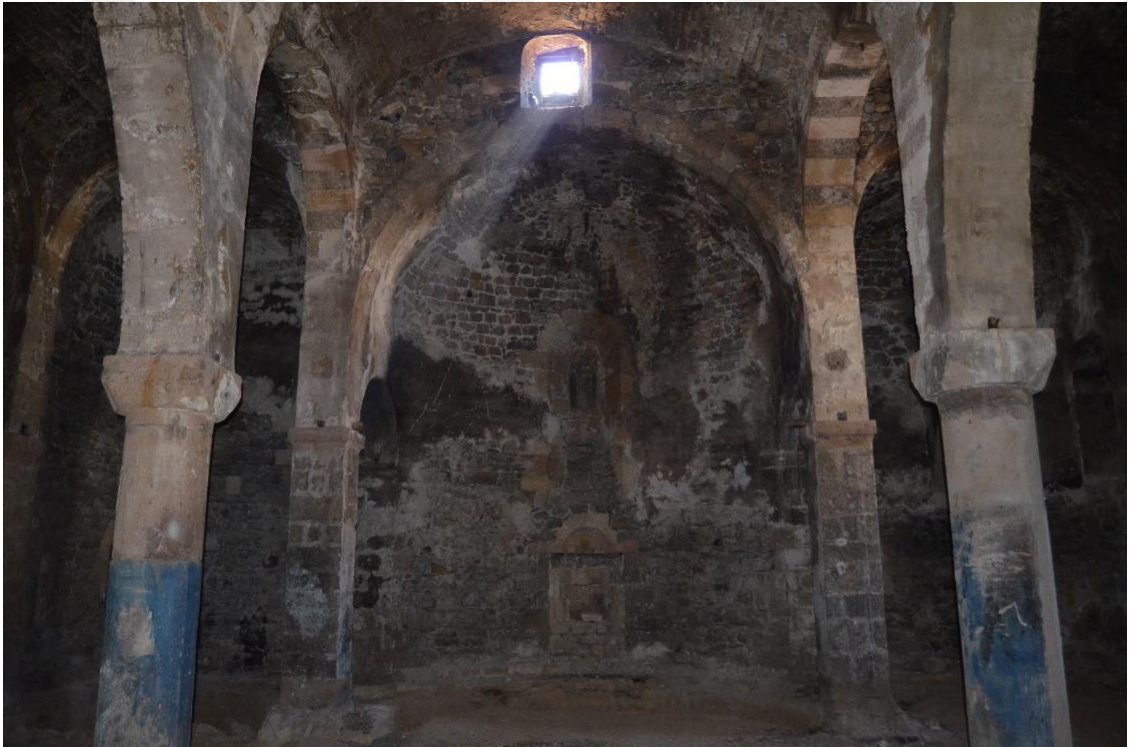
Foto. 102: Keban ilçesi Kallar Mahallesi Kilisesi doğu – apsisi – duvarı
