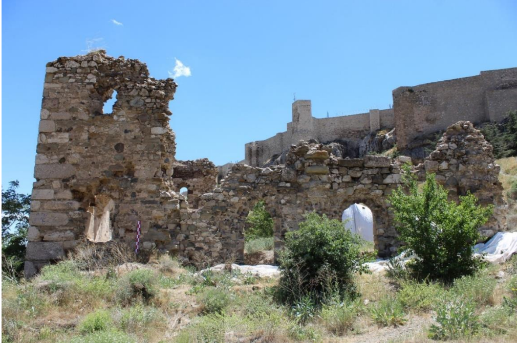
Foto. 40: Merkez ilçesi Gürcü Bey Mahallesi Surp Garabed (Kızıl) Manastır Kilisesi kuzey cephesi
