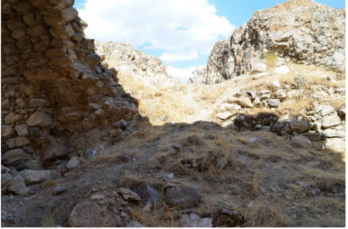
Foto. 169: Palu ilçesi Aşağı Palu Mahallesi Kindik Kilisesinin apsis bölümü doğu duvarı
