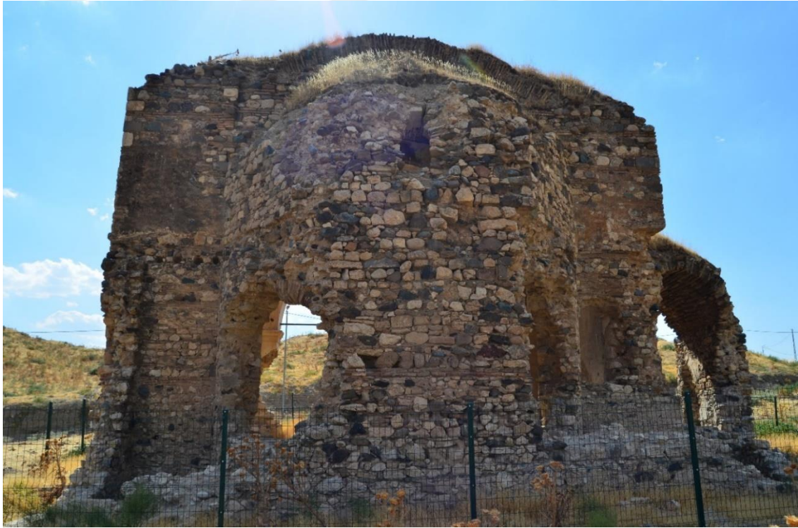
Foto. 174: Palu ilçesi Aşağı Palu Çarşıbaşı Mahallesi Surp Krikor Lusavoriç (Keklikdere) Kilisesi doğu cephesi
