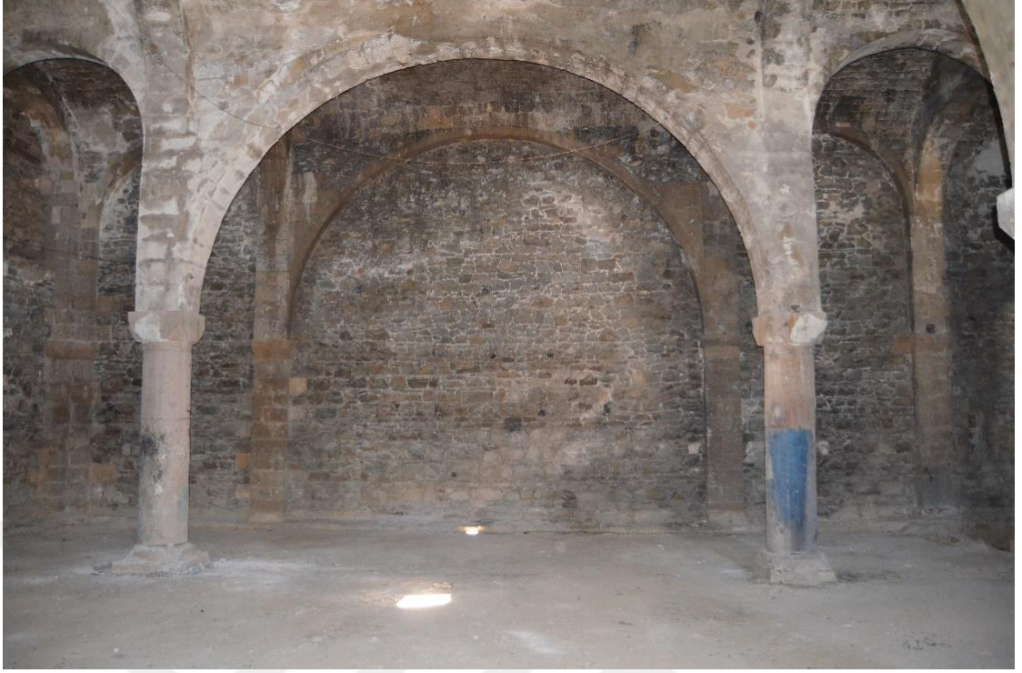
Foto. 101: Keban ilçesi Kallar Mahallesi Kilisesi kuzey duvarı
