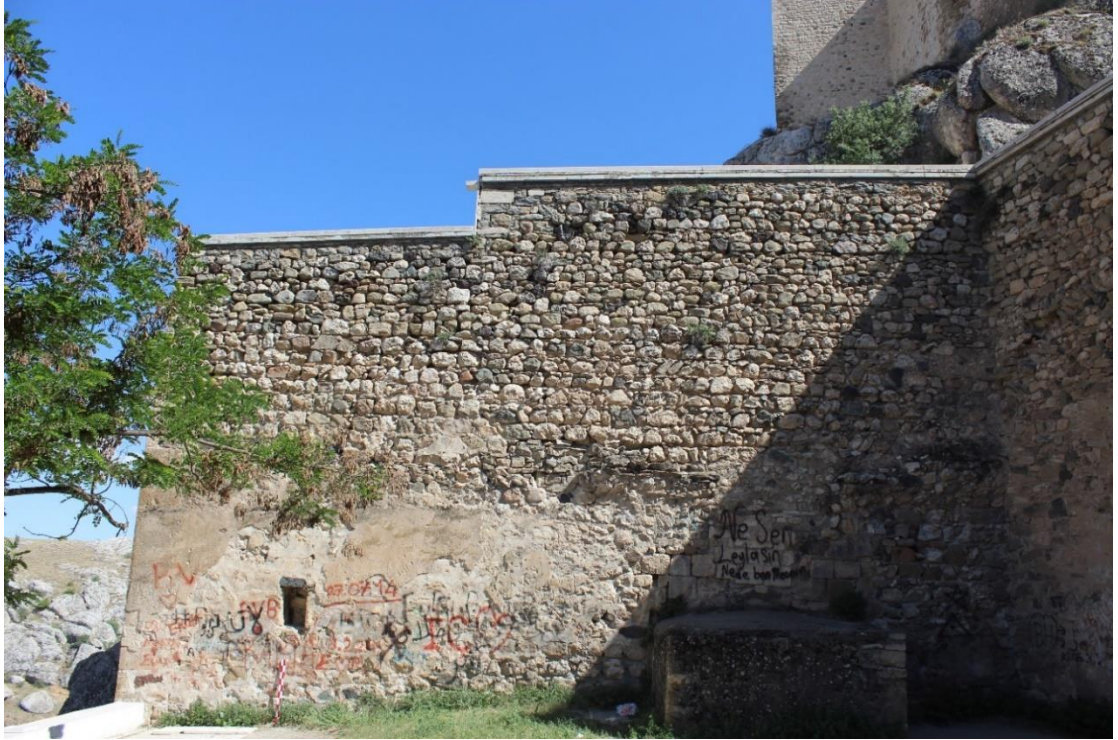
Foto. 214: Merkez ilçesi Harput Mahallesi Meryem Ana (Yakubi / Süryani / Kızıl) Kilisesi kuzey cephesi
