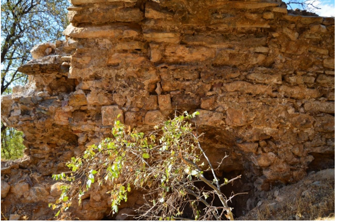
Foto. 195: Palu ilçesi Keklikdere köyü Surp Sarkis Surp Sarkis (Tirke) Kilisesi kuzey duvarı
