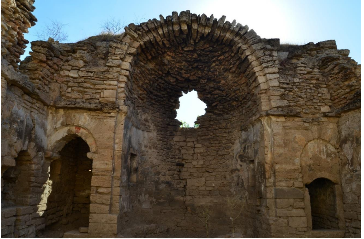
Foto. 127: Kovancılar ilçesi Ekinözü (Habab) köyü Surp Gatoğige (Meryem Ana) Kilisesi doğu duvarı
