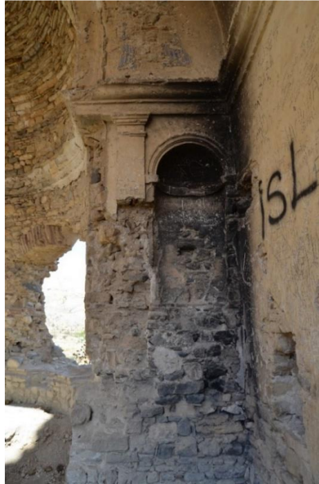
Foto. 182: Palu ilçesi Aşağı Palu Çarşıbaşı Mahallesi Surp Krikor Lusavoriç (Keklikdere) Kilisesi doğu duvarı güney nişi
