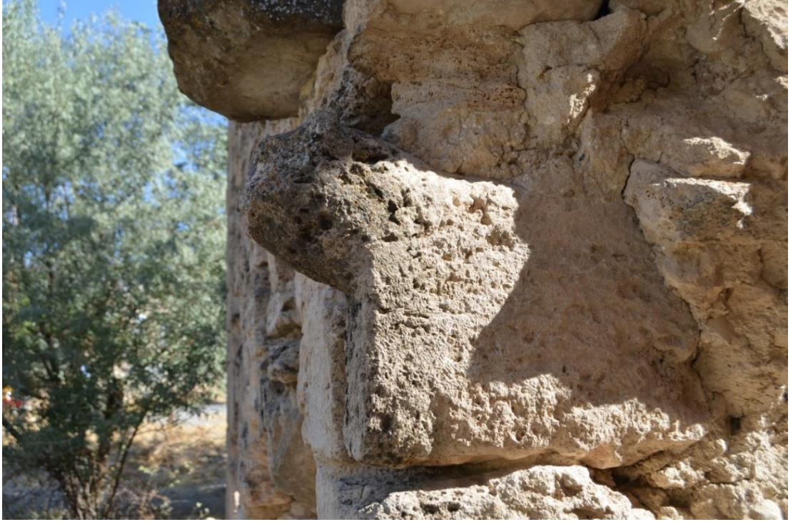
Foto. 120: Kovancılar ilçesi Ekinözü (Habab) köyü Surp Gatoğige (Meryem Ana) Kilisesi batı cephesindeki devşirme malzeme detayı
