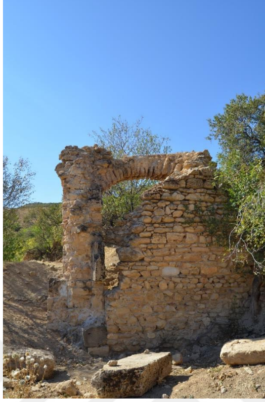
Foto. 3: Kovancılar ilçesi Ekinözü (Habab) köyü Kağtsrahayats Surp Asdvadzadzin Manastır Kilisesi kuzey cephesi detayı
