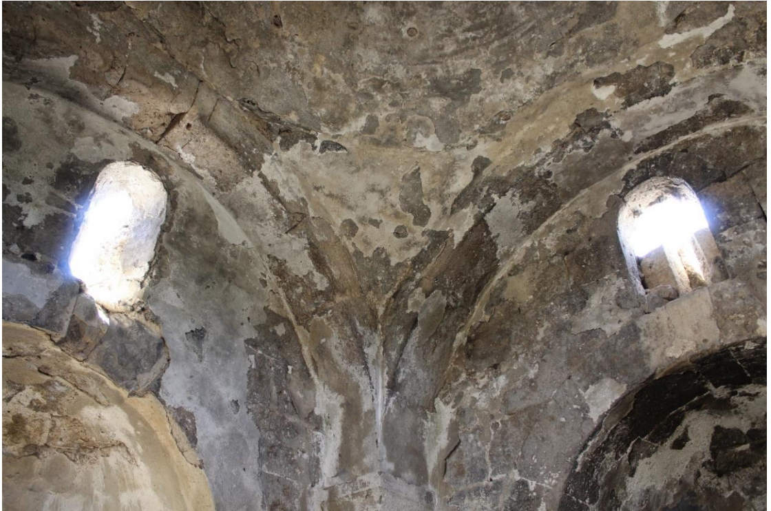
Foto. 56: Merkez ilçesi Yalnız köyü Surp Simon (Tadım / Asdvadzadzin) Manastırı Kilisesi kubbeye geçişi sağlayan pendentif detayı
