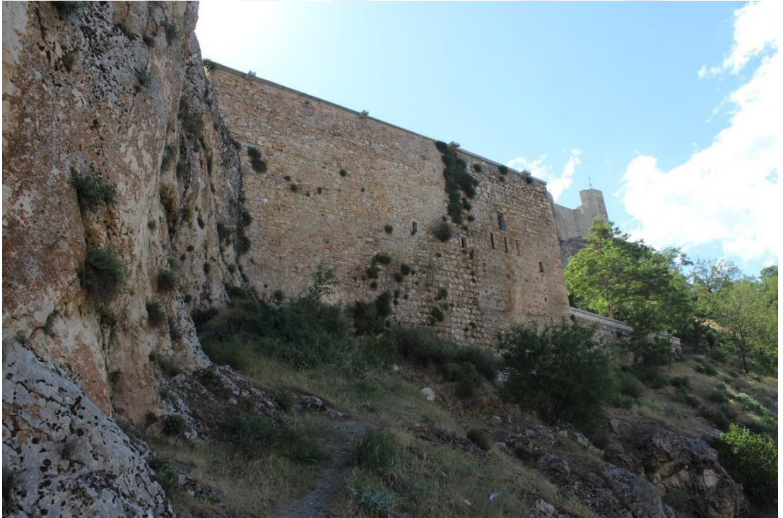
Foto. 216: Merkez ilçesi Harput Mahallesi Meryem Ana (Yakubi / Süryani / Kızıl) Kilisesi doğu cephesi
