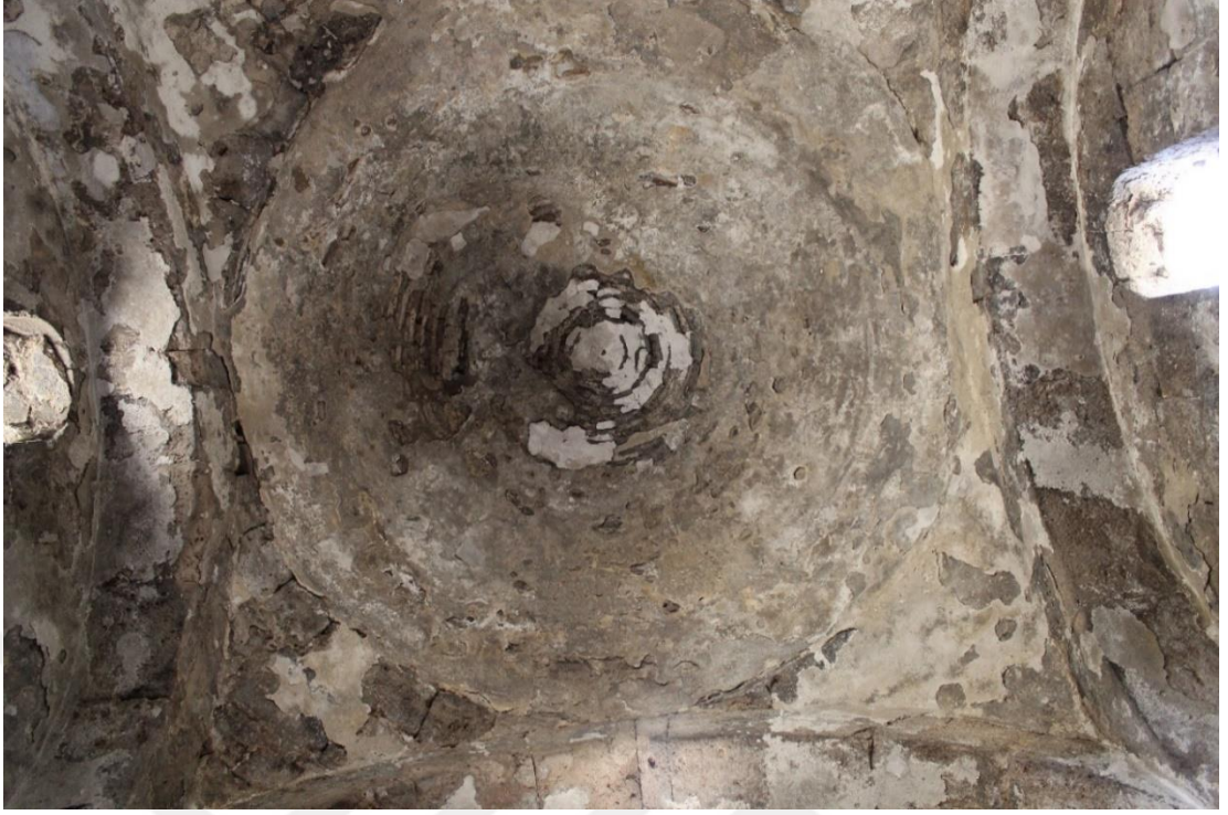
Foto. 55: Merkez ilçesi Yalnız köyü Surp Simon (Tadım / Asdvadzadzin) Manastırı Kilisesi kubbe detayı
