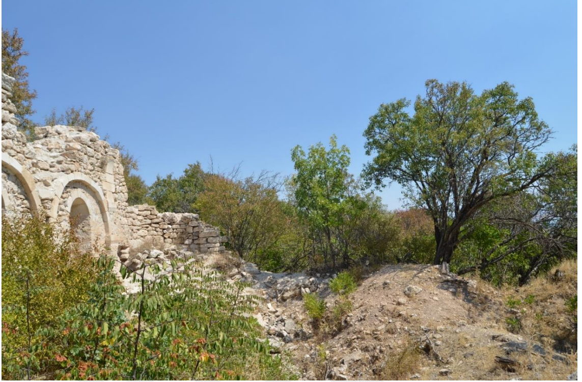
Foto. 93: Ağın ilçesi Beyelması köyü Surp Asdvadzadzin (Küşne) Kilisesi doğu ve güney duvar kalıntıları
