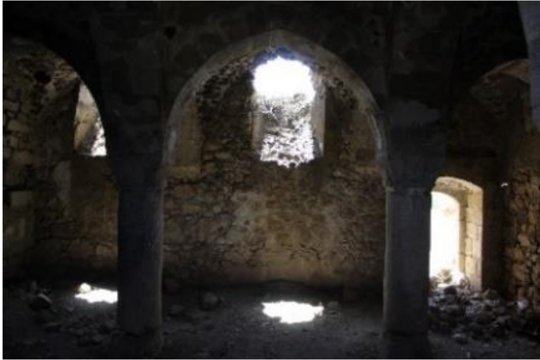
Foto. 70: Merkez ilçesi Yalnız köyü Surp Simon (Tadım / Asdvadzadzin) Manastır Jamatunu güney duvarı
