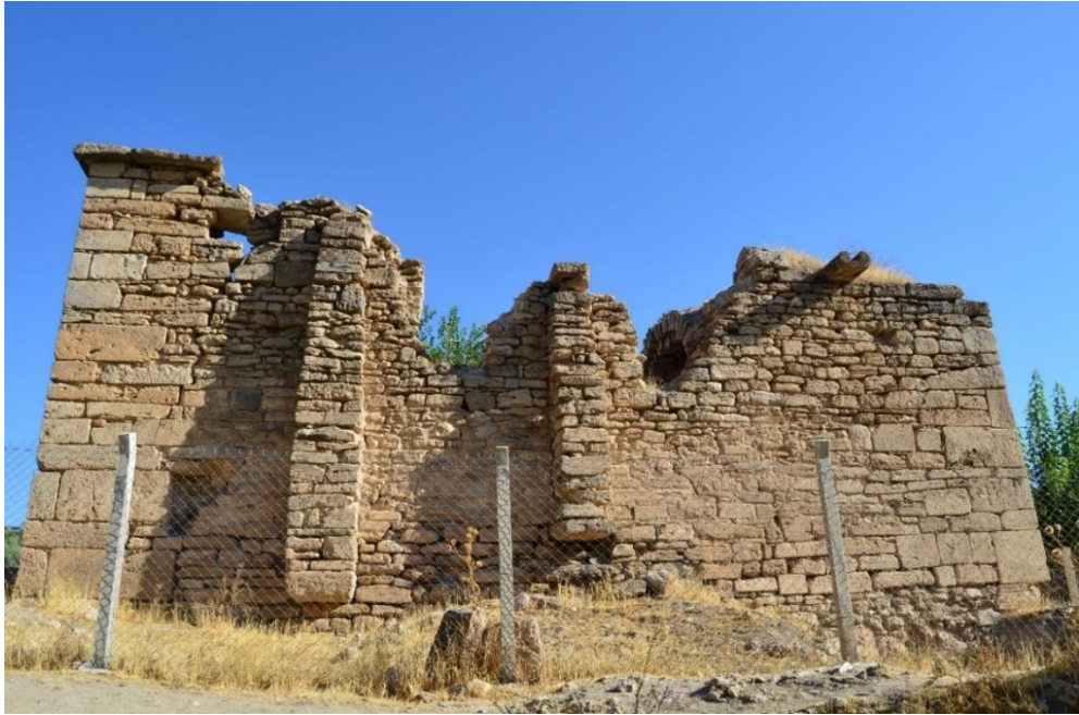
Foto. 124: Kovancılar ilçesi Ekinözü (Habab) köyü Surp Gatoğige (Meryem Ana) Kilisesi güney cephesi
