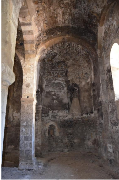
Foto. 104: Keban ilçesi Kallar Mahallesi Kilisesi doğu duvarı güneydoğu apsidiyolu
