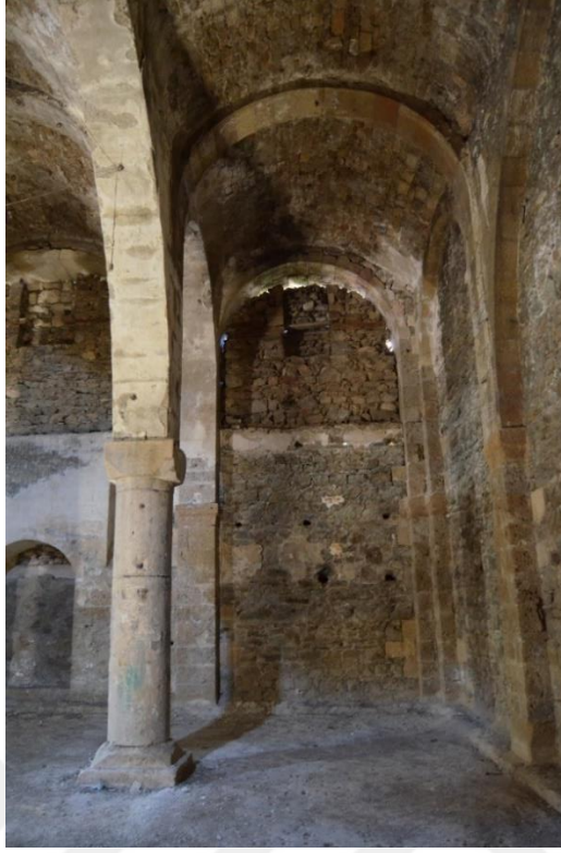
Foto. 99: Keban ilçesi Kallar Mahallesi Kilisesi batı duvarı detayı
