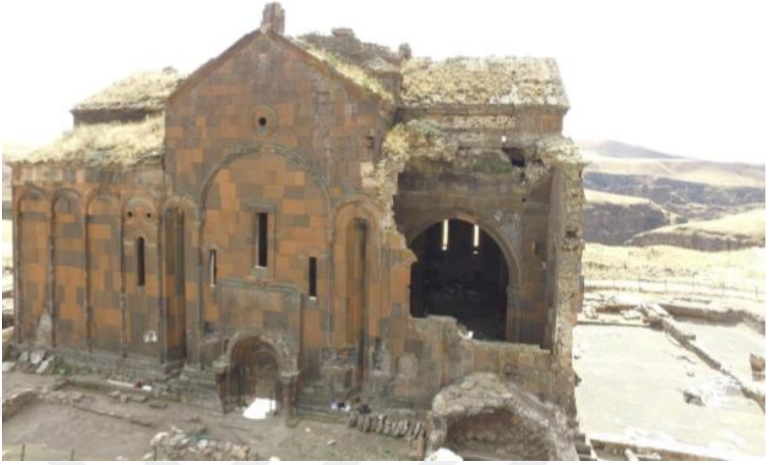
Foto. 225: Kars ili Ani Katedrali güney cephesi ( 989 – 1001), (Bozoğlu Bay. 2019)
