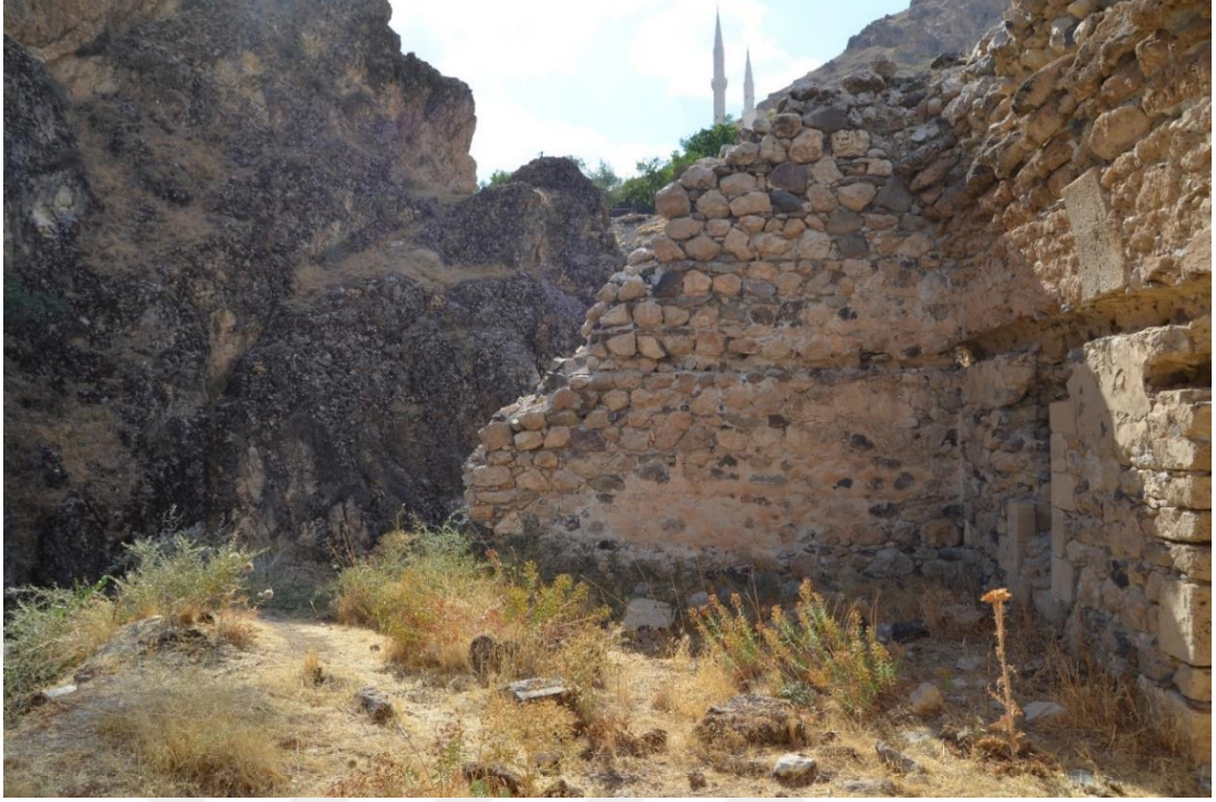
Foto. 165: Palu ilçesi Aşağı Palu Mahallesi Kindik Kilisesi güney ve batı duvarı
