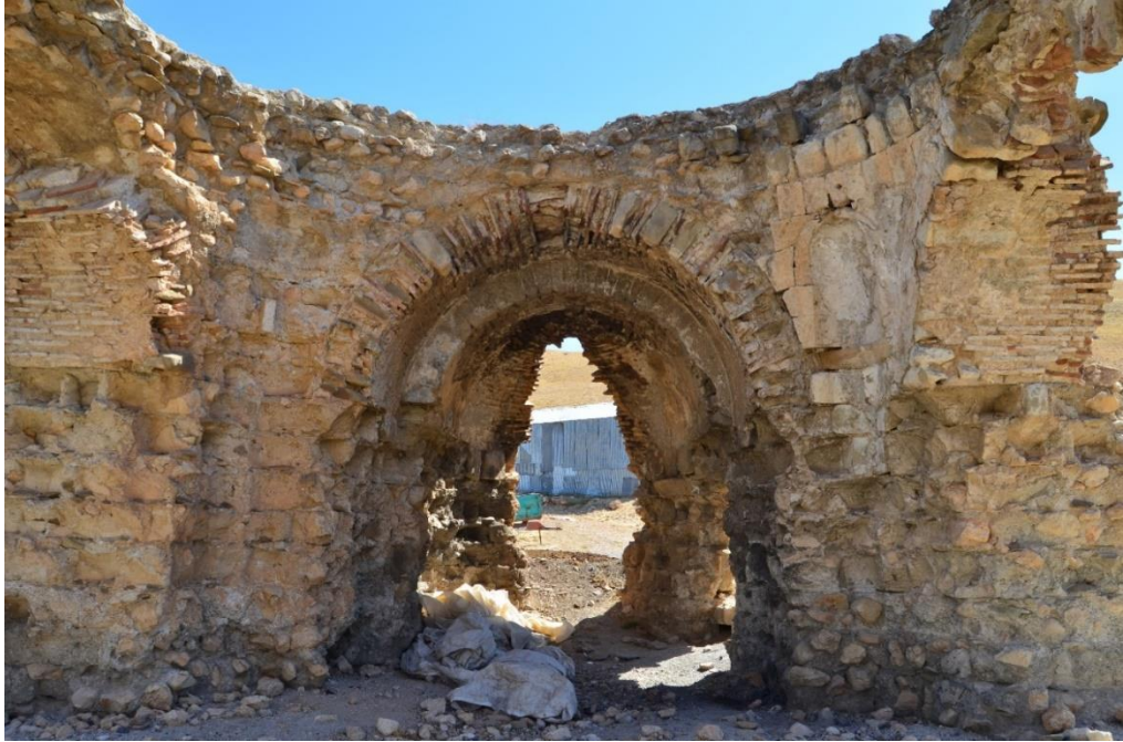
Foto. 116: Kovancılar ilçesi Çakırkaş köyü Surp Asdvadzadzin (Hoşmat) Kilisesi doğu duvarı
