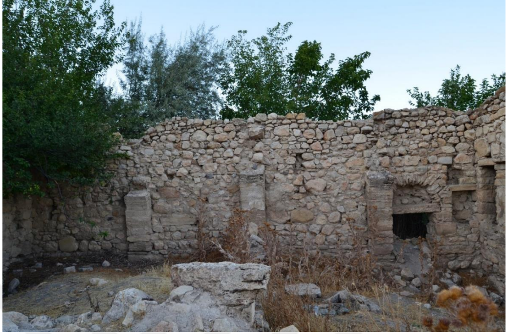
Foto. 137: Kovancılar ilçesi Karınca köyü Surp Kevork Kilisesi kuzey duvarı
