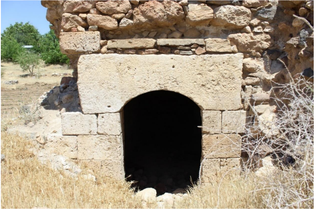
Foto. 60: Merkez ilçesi Yalnız köyü Surp Simon (Tadım / Asdvadzadzin) Manastır Jamatunu giriş kapısı
