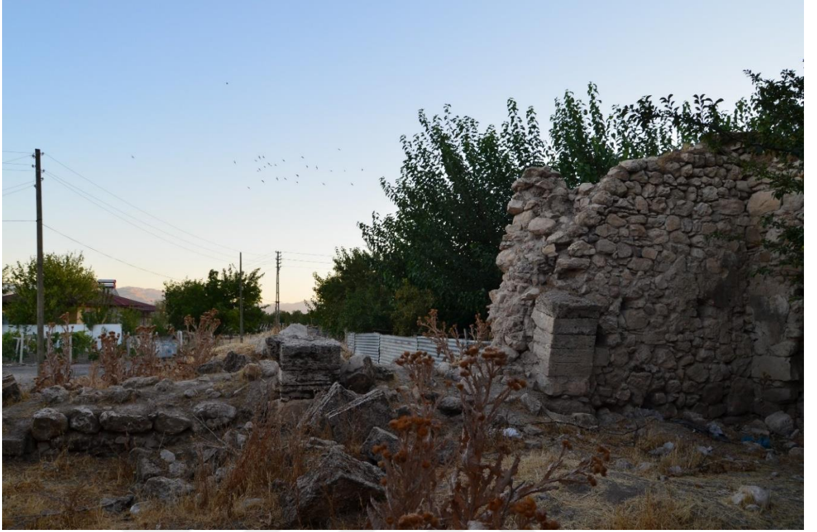
Foto. 141: Kovancılar ilçesi Karınca köyü Surp Kevork Kilisesi güney duvarı
