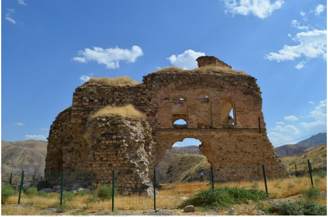
Foto. 173: Palu ilçesi Aşağı Palu Çarşıbaşı Mahallesi Surp Krikor Lusavoriç (Keklikdere) Kilisesi kuzey cephesi
