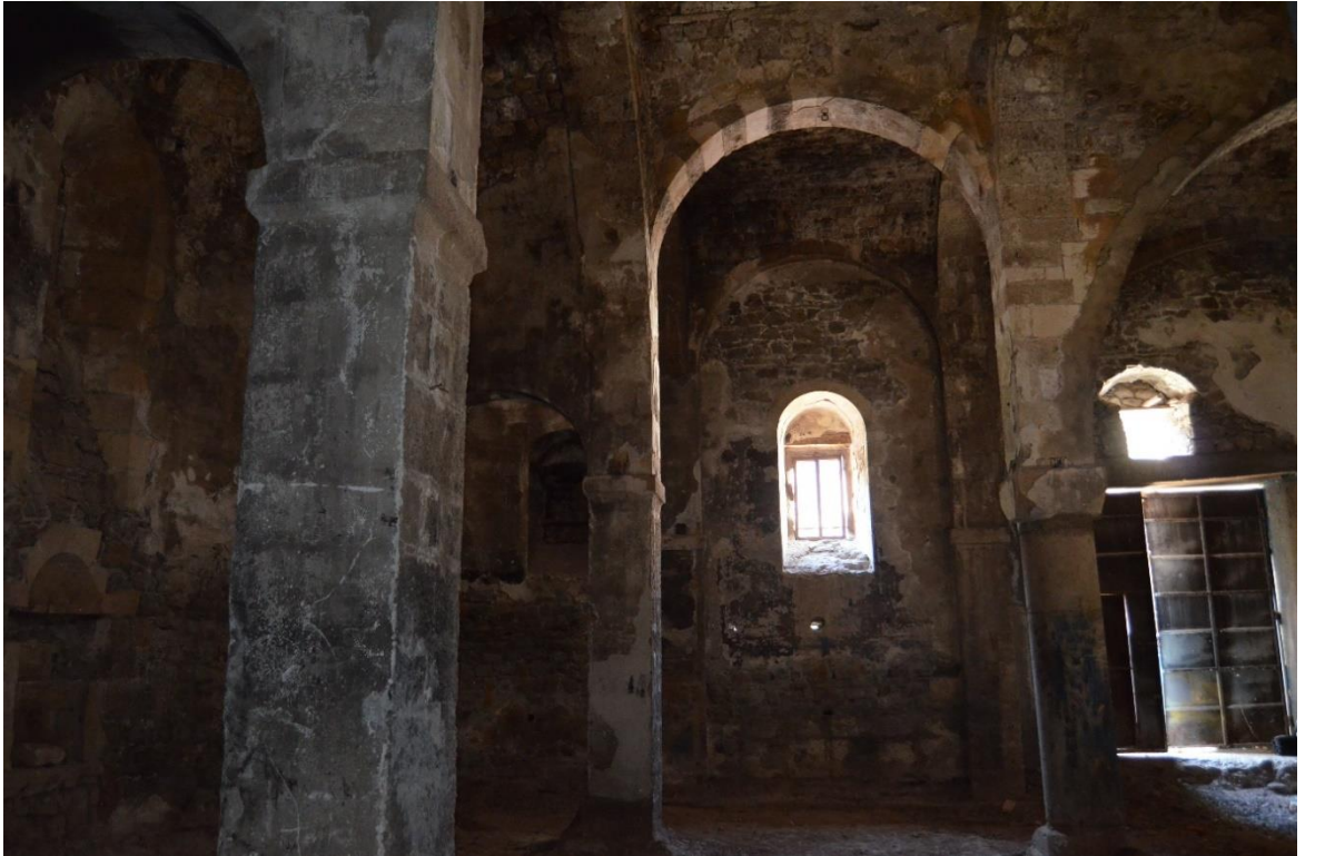
Foto. 106: Keban ilçesi Kallar Mahallesi Kilisesi güney duvarı detayı
