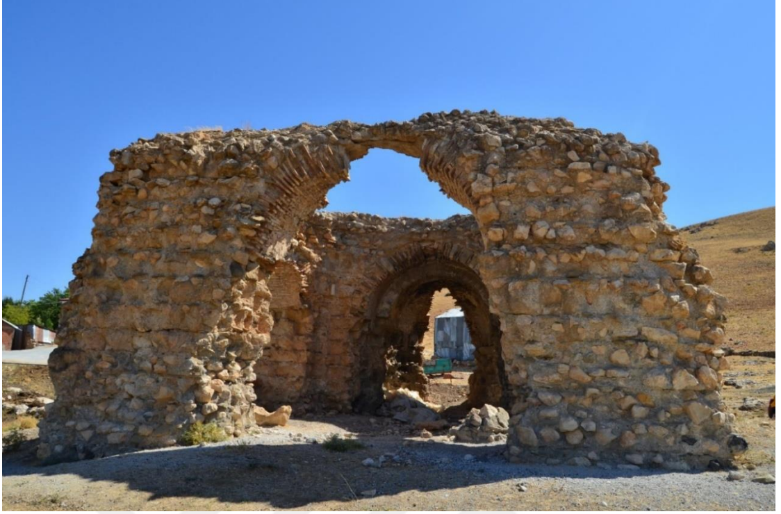
Foto. 109: Kovancılar ilçesi Çakırkaş köyü Surp Asdvadzadzin (Hoşmat) Kilisesi batı cephesi
