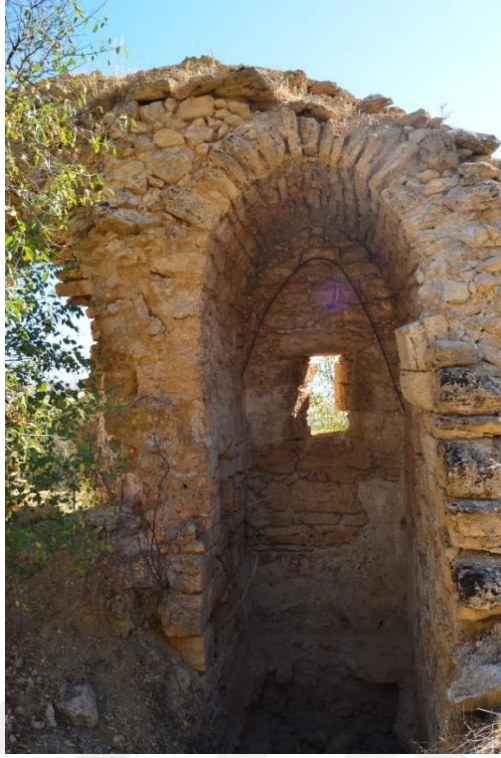
Foto. 9: Kovancılar ilçesi Ekinözü (Habab) köyü Kağtsrahayats Surp Asdvadzadzin Manastır Kilisesi güney pastoforium odası
