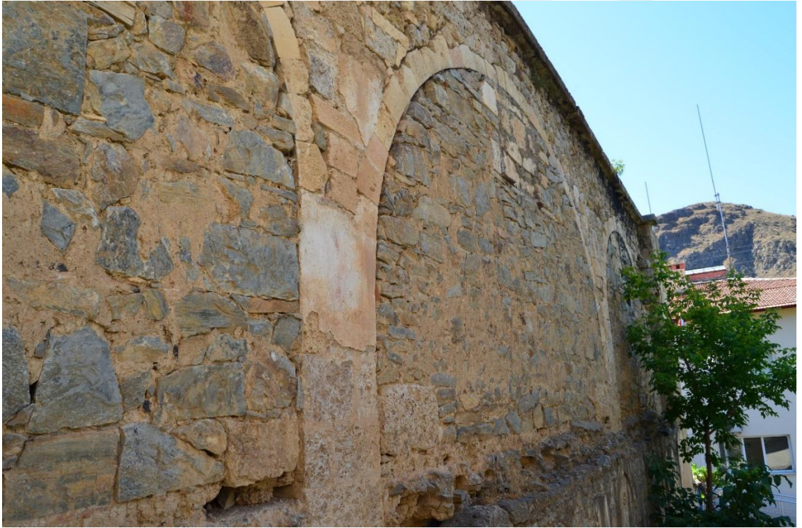
Foto. 94: Keban ilçesi Kallar Mahallesi Kilisesi batı cephesi
