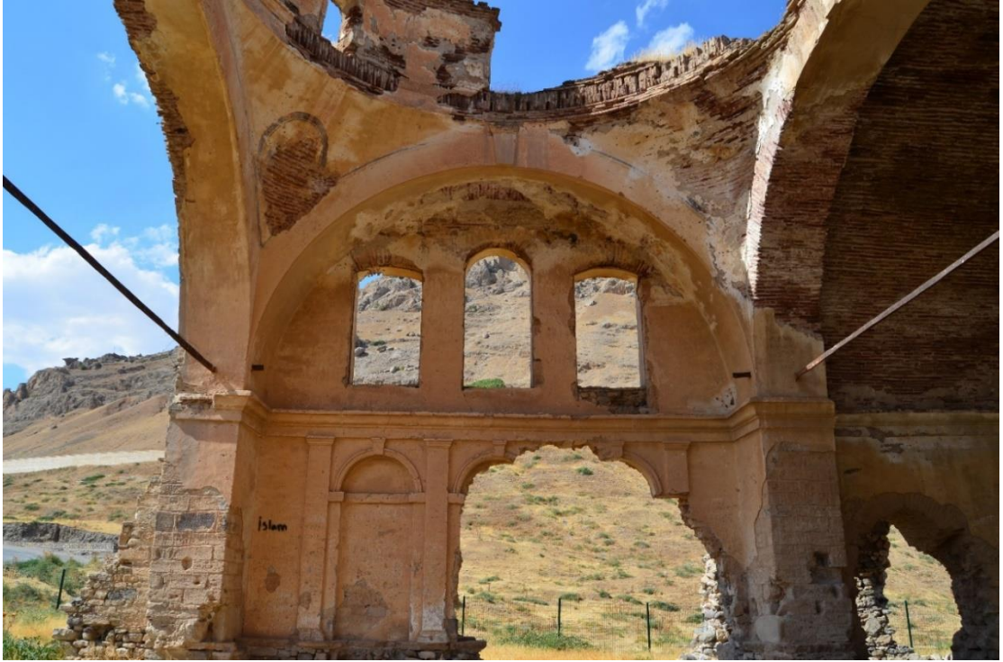
Foto. 176: Palu ilçesi Aşağı Palu Çarşıbaşı Mahallesi Surp Krikor Lusavoriç (Keklikdere) Kilisesi kuzey duvarı
