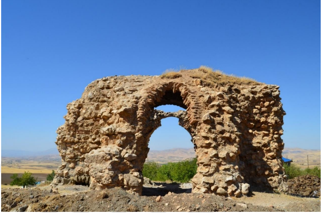
Foto. 111: Kovancılar ilçesi Çakırkaş köyü Surp Asdvadzadzin (Hoşmat) Kilisesi doğu cephesi
