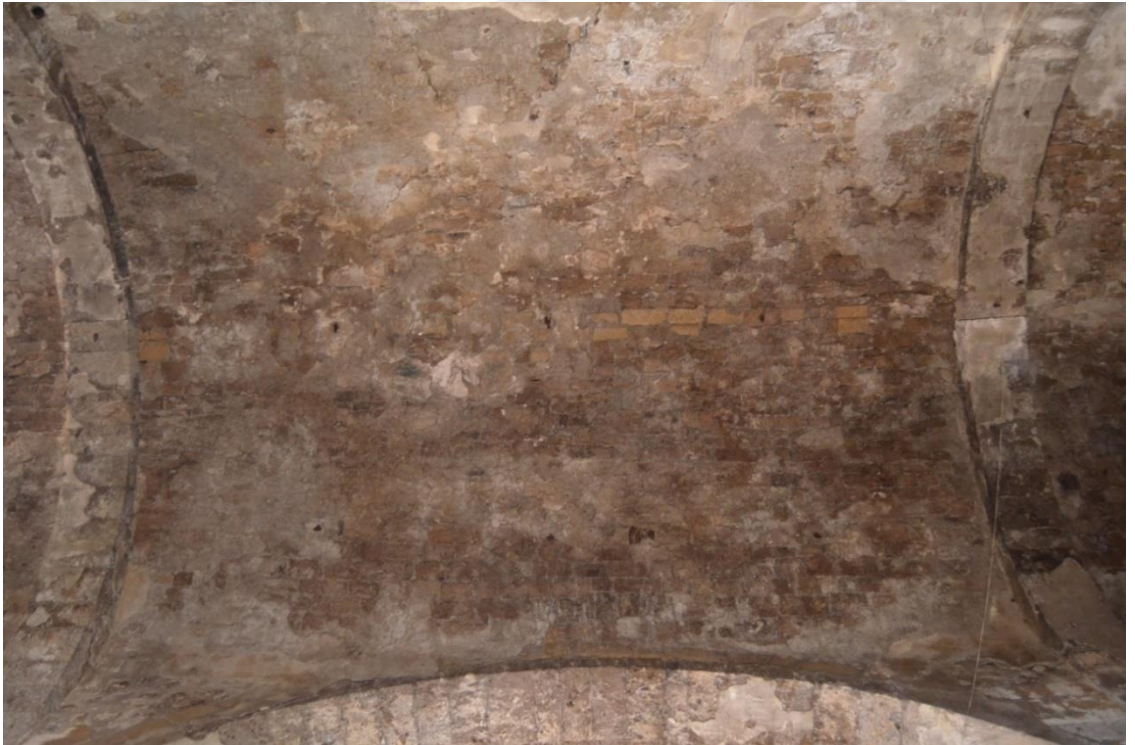
Foto. 108: Keban ilçesi Kallar Mahallesi Kilisesi beşik tonozlu üst örtüsü
