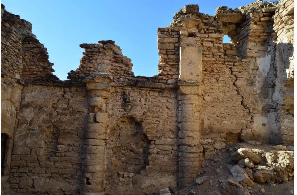
Foto. 130: Kovancılar ilçesi Ekinözü (Habab) köyü Surp Gatoğige (Meryem Ana) Kilisesi güney duvarı
