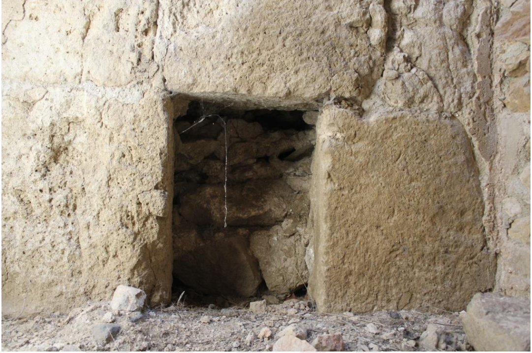
Foto. 69: Merkez ilçesi Yalnız köyü Surp Simon (Tadım / Asdvadzadzin) Manastır Jamatunu güneydoğu ek mekânın niş detayı
