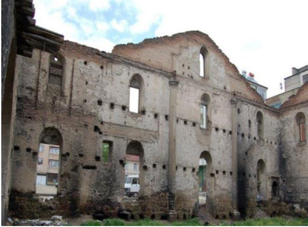
Foto. 152: Merkez ilçesi İzzetpaşa Mahallesi Protestan Kilisesi kuzey duvarı (Ş. Öztürk Arşivi)
