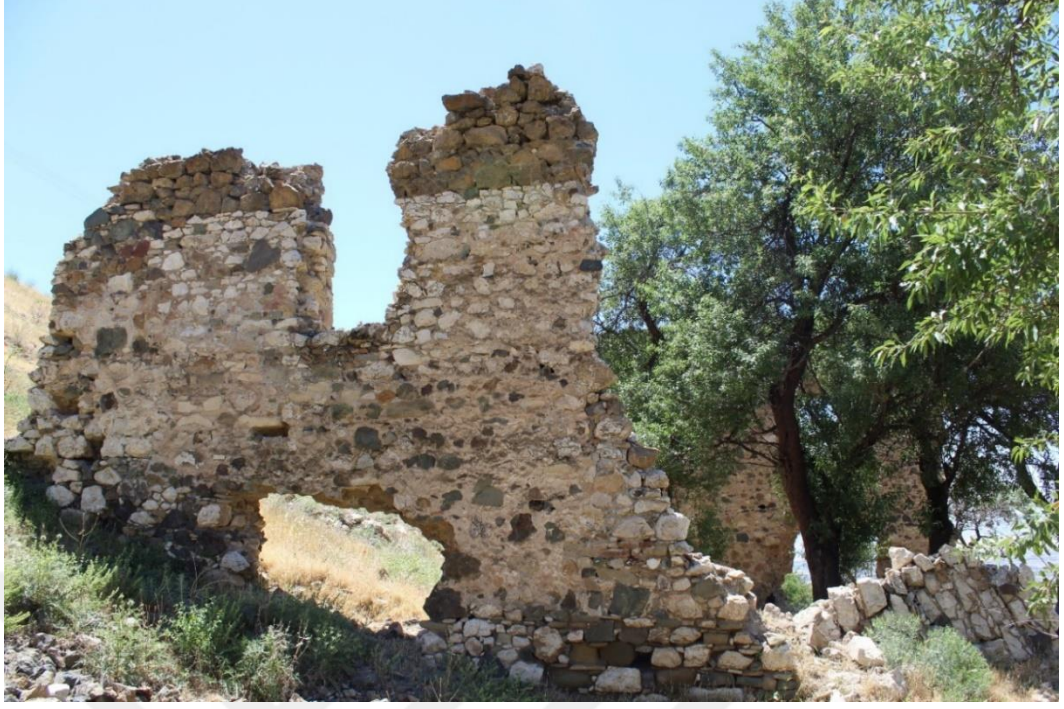
Foto. 155: Merkez ilçesi Kuyumcular Mahallesi Surp Hagop Kilisesi kuzey cephesi
