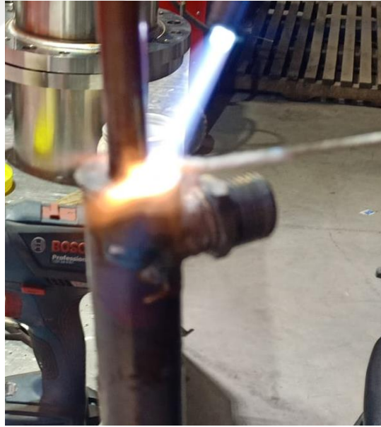
Şekil 5.5. İç ve dış borunun kaynak işlemi
