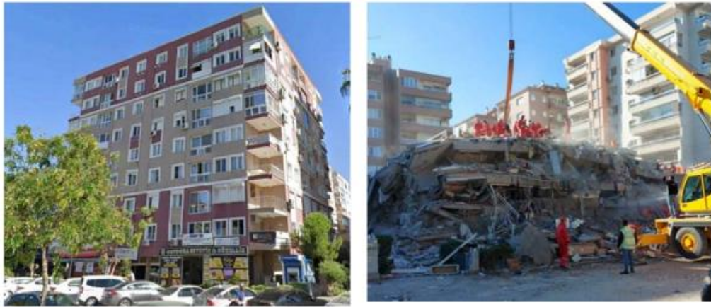
Şekil 2.1 30.10.2020 İzmir depreminde yıkılan binalardan bir tanesi (TMMOB, 2020)
