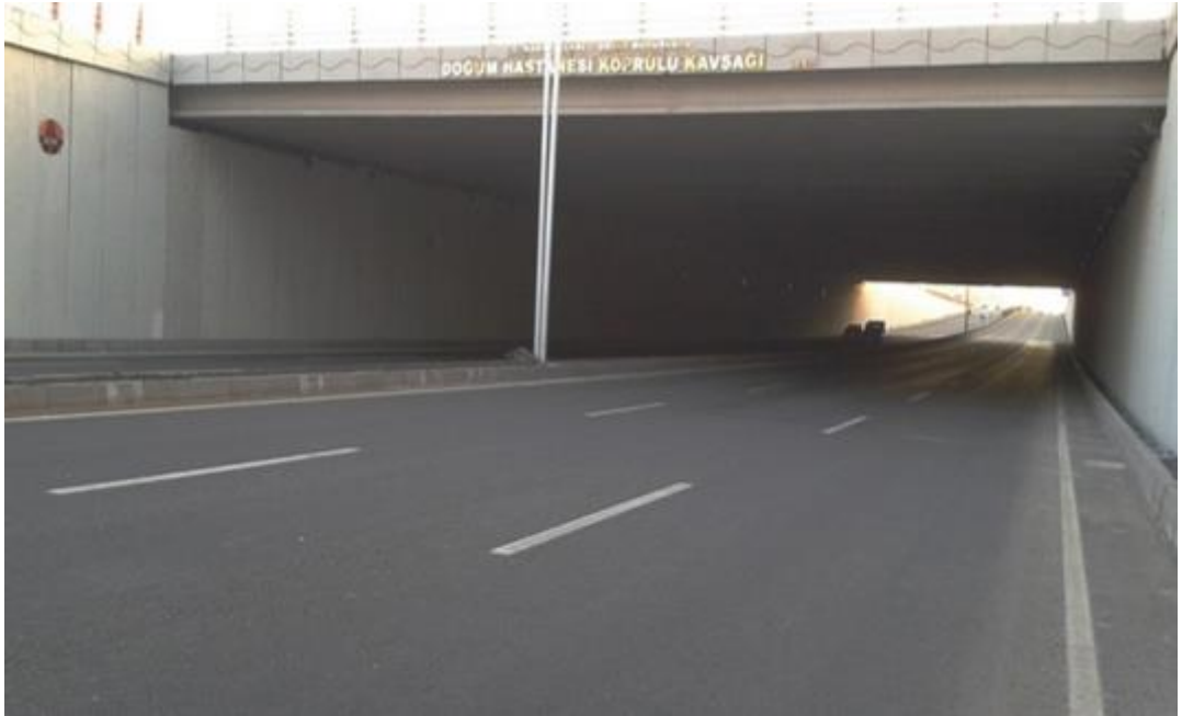
Şekil 3. 1 Doğum Hastanesi Köprüsü Kavşağı Alt Geçidi görünümü [23].
