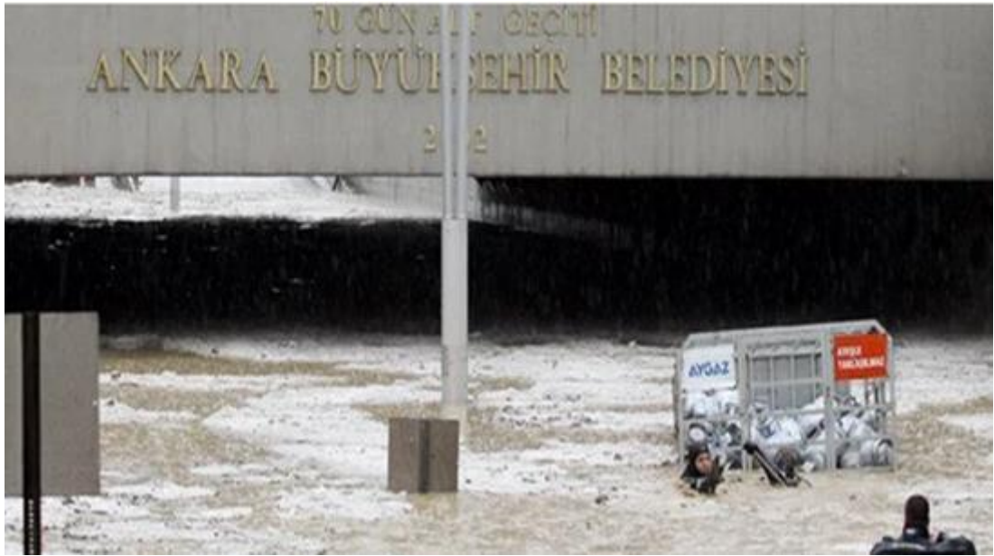
Şekil 1. 1 Yağmur suyunun Ankara 70 Gün Alt Geçidinde yol açtığı manzara [3].
