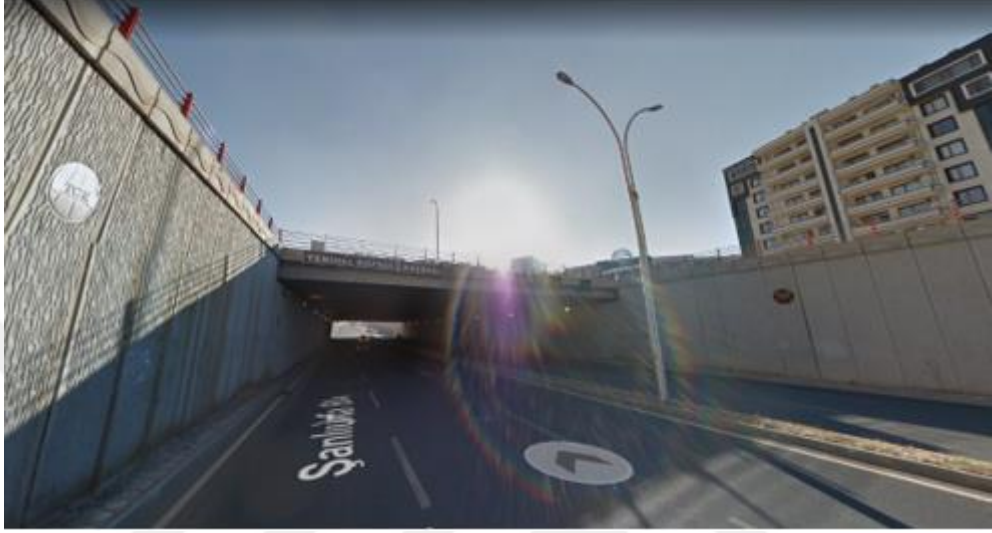
Şekil 3. 6 Yenihal Köprülü Kavşağı Alt Geçit Görünümü [26].
