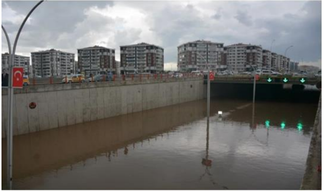
Şekil 1. 3 Yağmur suyunun Diyarbakır Doğum Hastanesi Köprülü Kavşağı Alt Geçidinde yol açtığı manzara [5].
