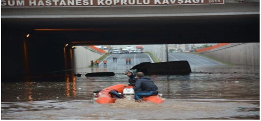
Şekil 1. 4 Yağmur suyunun Diyarbakır Doğum Hastanesi Köprülü Kavşağı Alt Geçidinde yol açtığı manzara [5].
