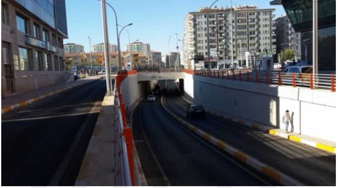
Şekil 3. 4 Parkorman Alt Geçit Köprüsü Görünümü [25].
