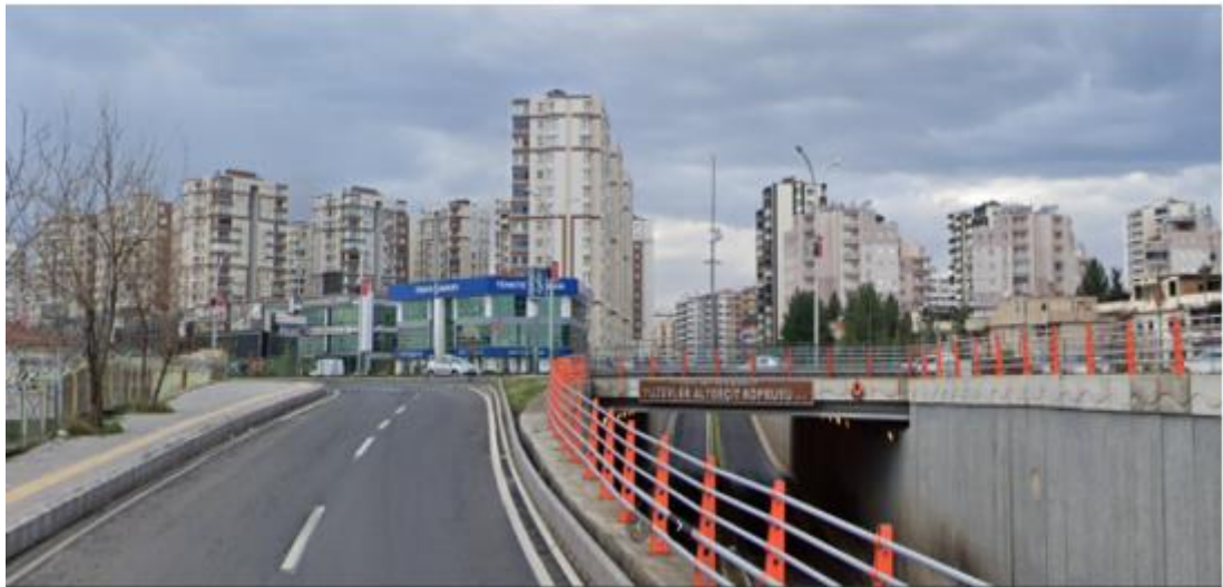
Şekil 3. 7 Yüzevler Alt Geçit Köprüsü Görünümü [26].
