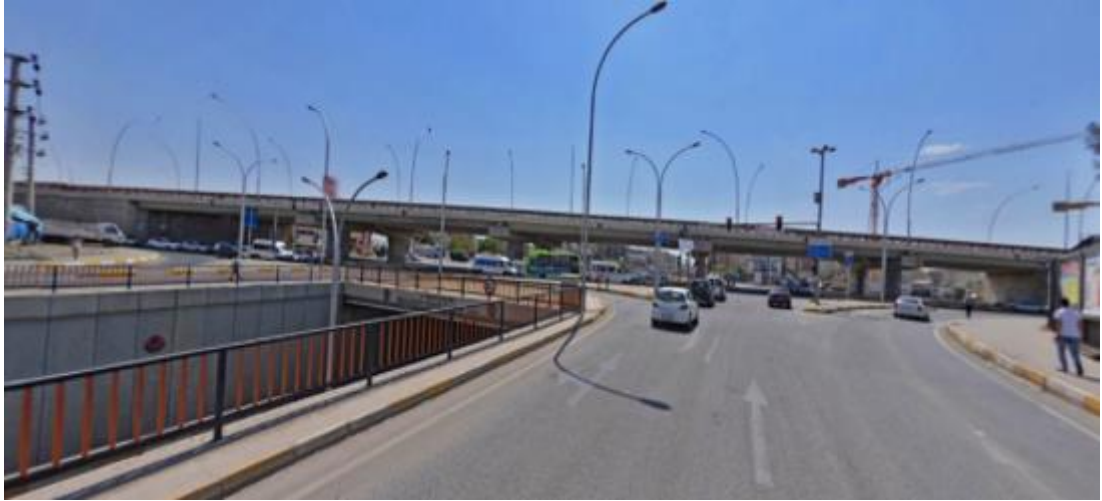
Şekil 3. 2 Seyrantepe Köprülü Kavşağı Görünümü [24].
