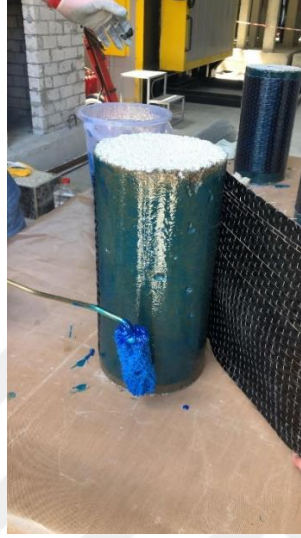
Şekil 2.7. Beton yüzeylere epoksi esaslı yapıştırıcı (reçine) uygulanması
