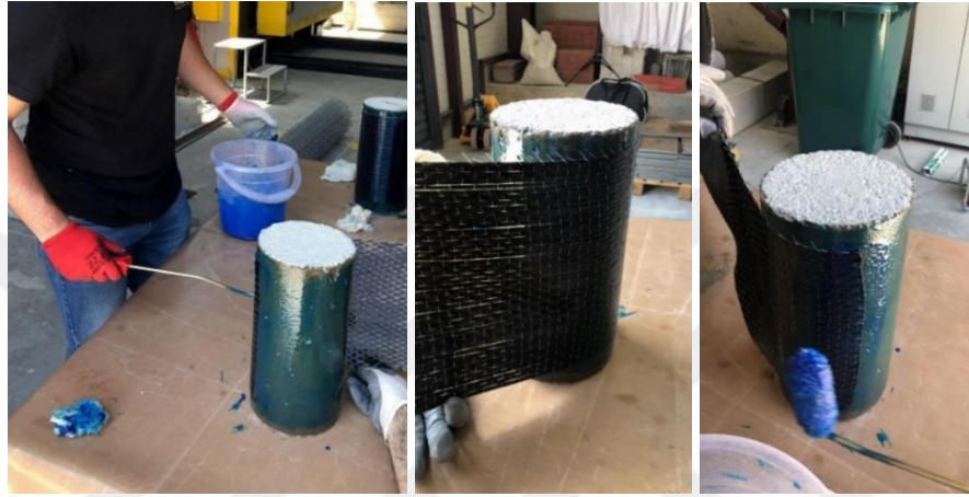
Şekil 2.8. Reçine sürülmüş beton yüzeyine ilk kat FRP kumaş uygulaması
