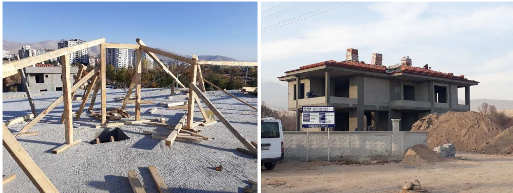
Şekil 5.33. Çatının tamamlanması (Yazar, 2021)
