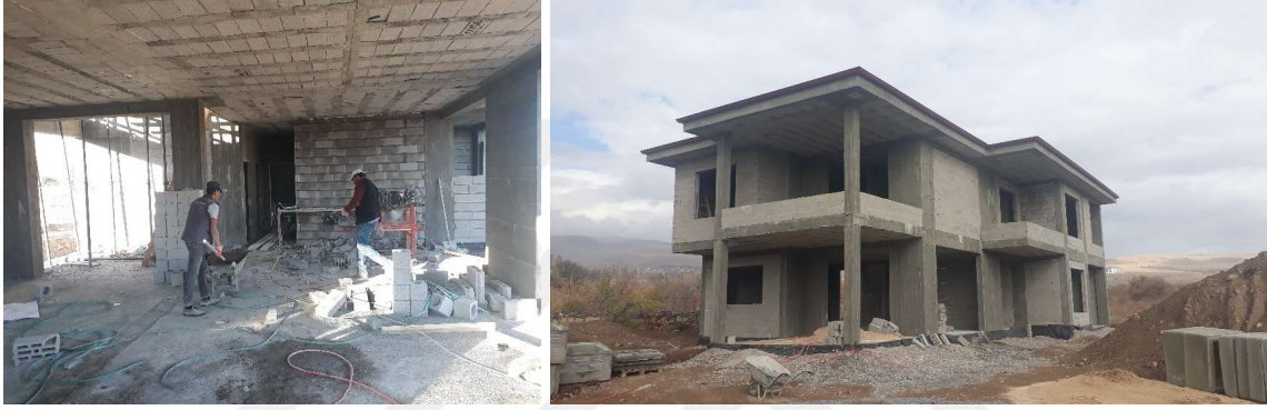
Şekil 5.32. Duvarların örülmesi (Yazar, 2021)
