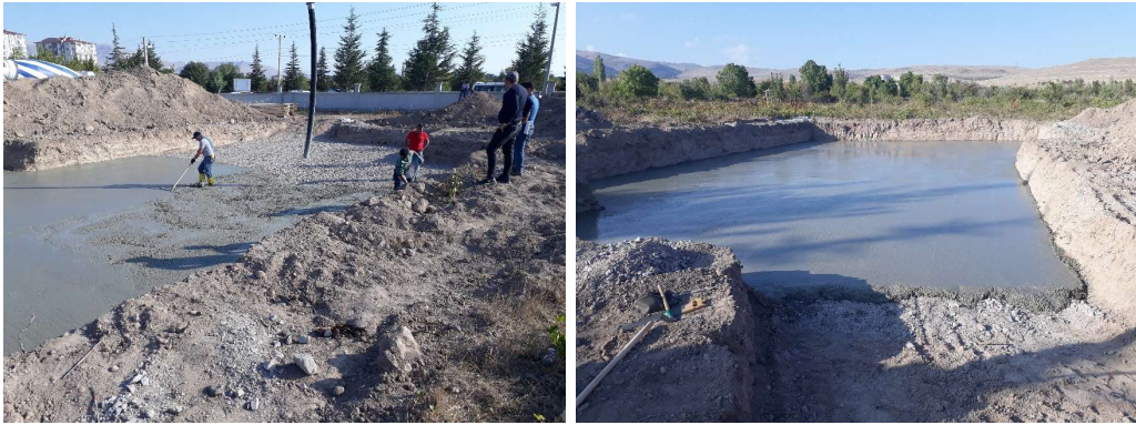
Şekil 5.26. Grobeton dökümü (Yazar, 2021)
