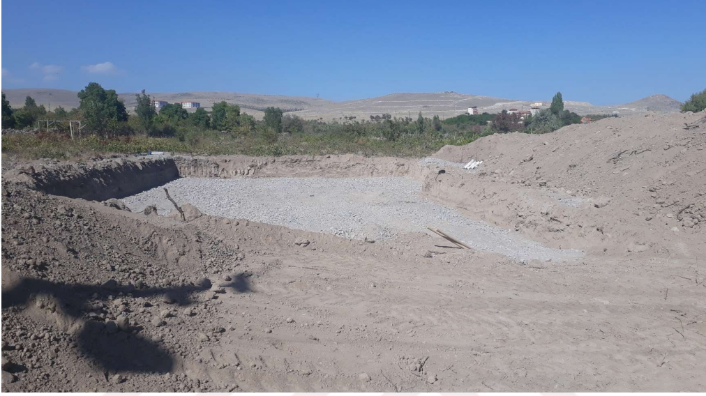
Şekil 5.25. Blokaj çalışması (Yazar, 2021)
