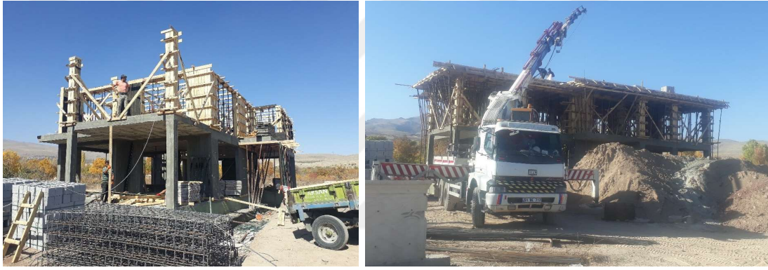
Şekil 5.31. Zemin ve birinci kat taşıyıcı sistemlerinin oluşturulması (Yazar, 2021)
