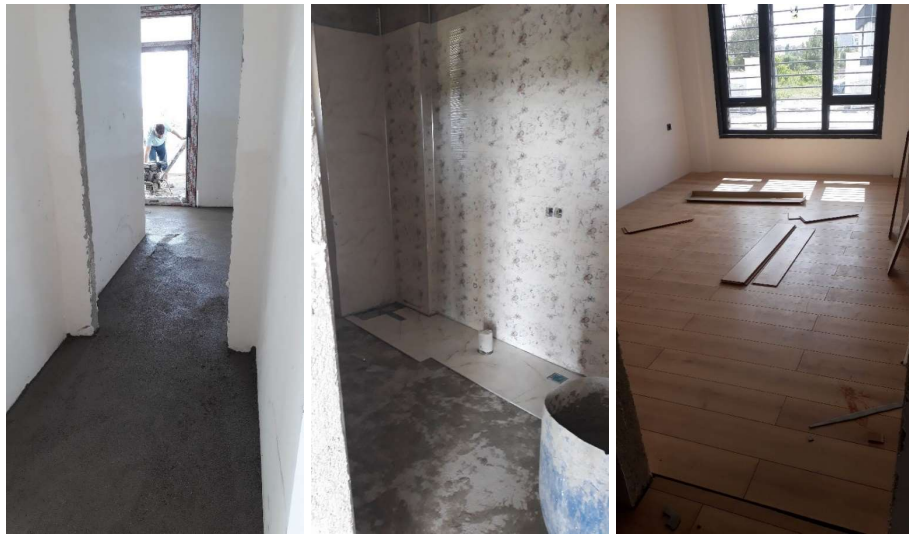
Şekil 5.39. Şap atılması ve zemin kaplamalarının yerleştirilmesi (Yazar, 2022)
