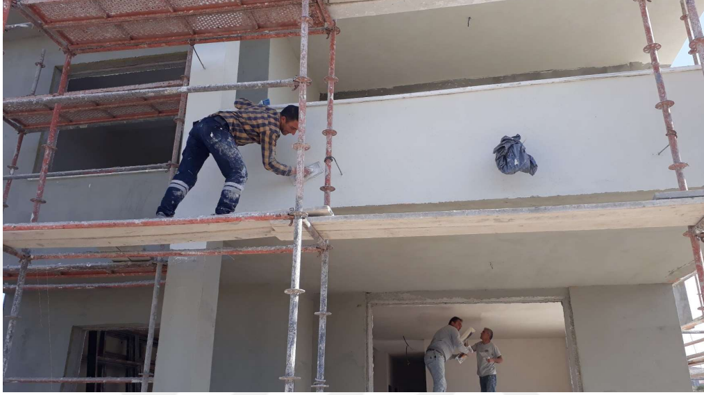
Şekil 5.38. İç ve dış cephe boyasının tamamlanması (Yazar, 2022)
