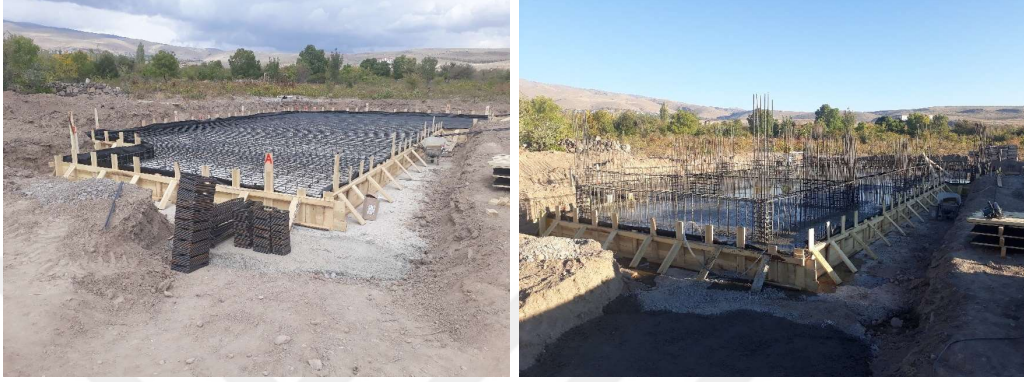
Şekil 5.28. Radye temel beton dökümü (Yazar, 2021)
