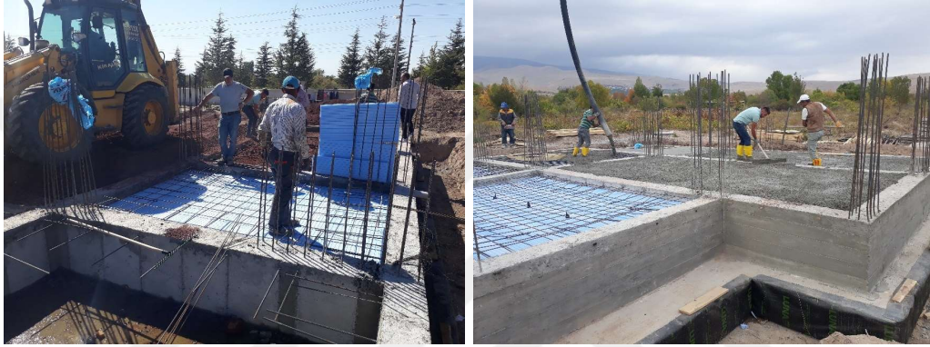
Şekil 5.30. Su basman altı yapım faaliyetlerinin tamamlanması (Yazar, 2021)
