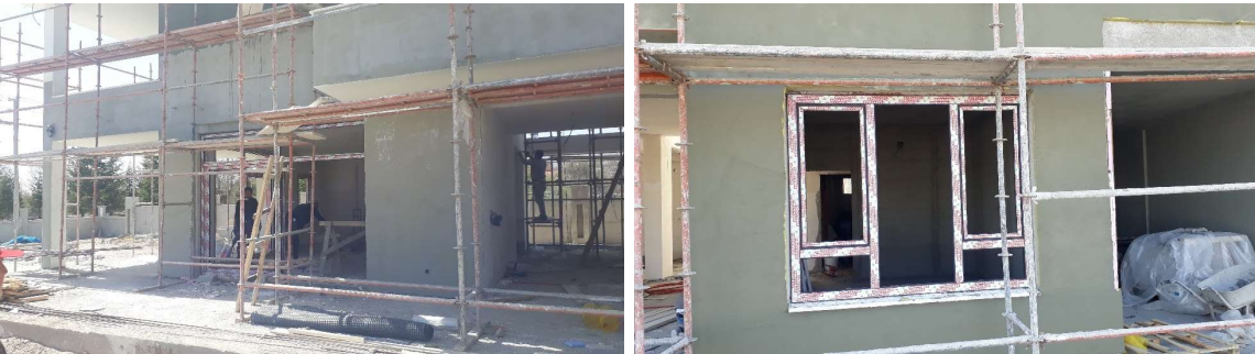
Şekil 5.37. Kapı ve pencere montajları (Yazar, 2022)
