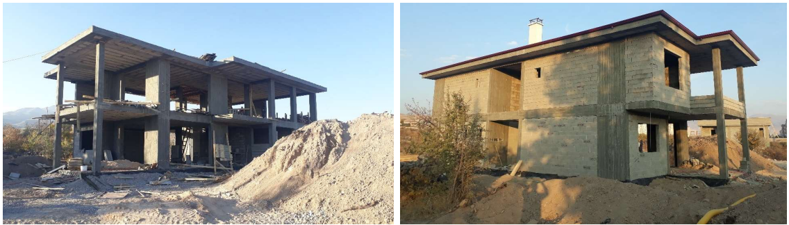
Şekil 5.20. Kaba yapı inşaatının tamamlanması (Yazar, 2022)
