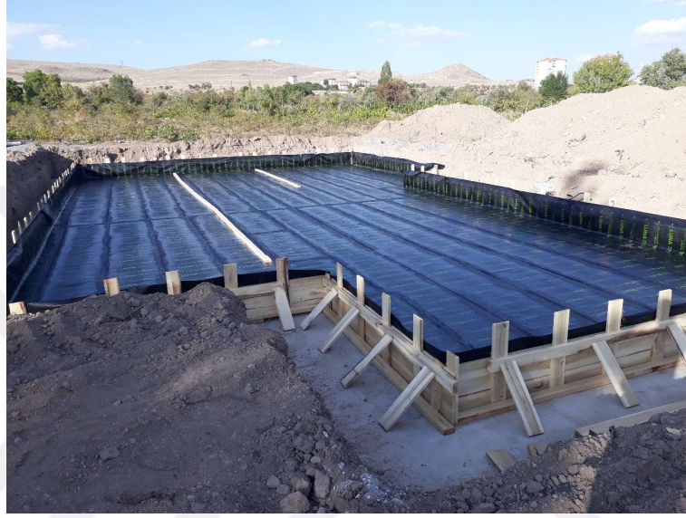
Şekil 5.27. Su yalıtım membranlarının serilmesi (Yazar, 2021)
