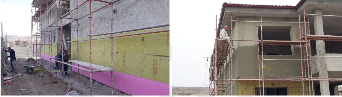
Şekil 5.36. Duvar yalıtımının tamamlanması (Yazar, 2022)
