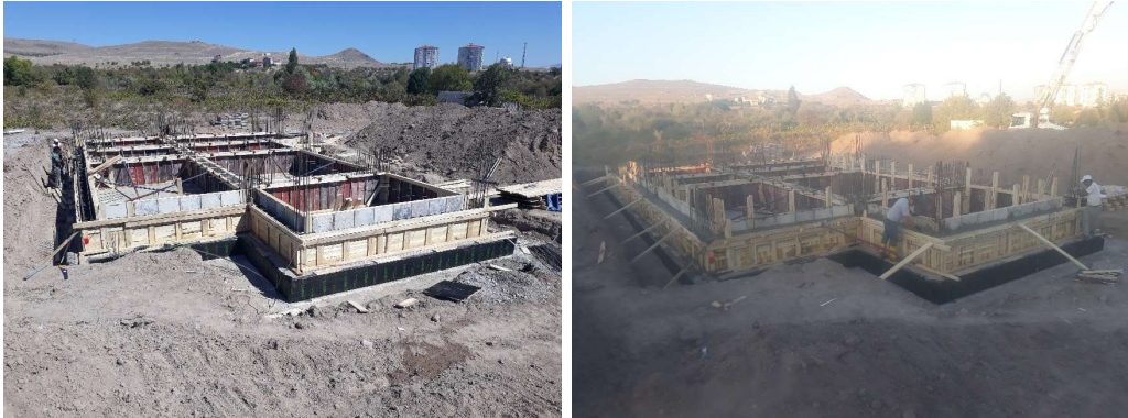
Şekil 5.29. Yükseltme perdeleri beton dökümü (Yazar, 2021)
