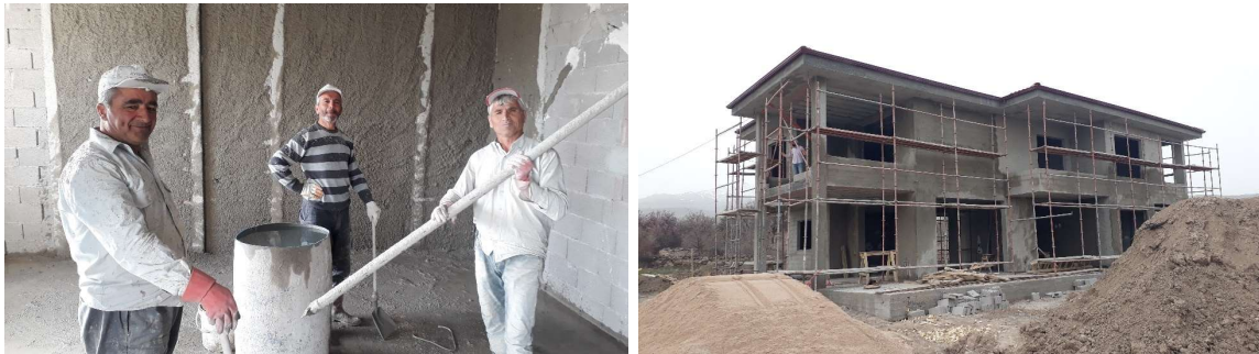
Şekil 5.35. İç ve dış cephe duvarların sıvanması (Yazar, 2022)
