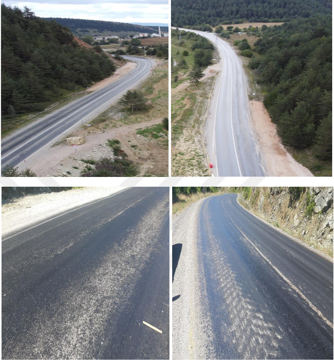
Şekil 6.5 765-01 K. K numaralı yolda meydana gelen kuma ve cilalanma
