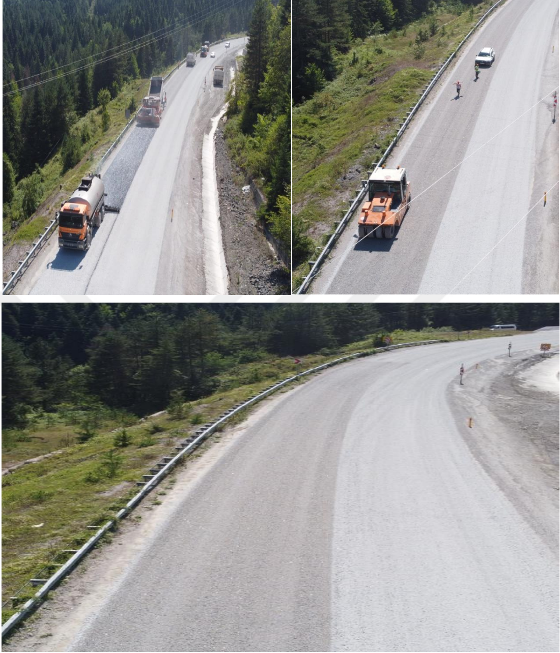
Şekil 6.13 750-01 K.K numaralı yolun sathi kaplama yapıldıktan sonra görünüşü
