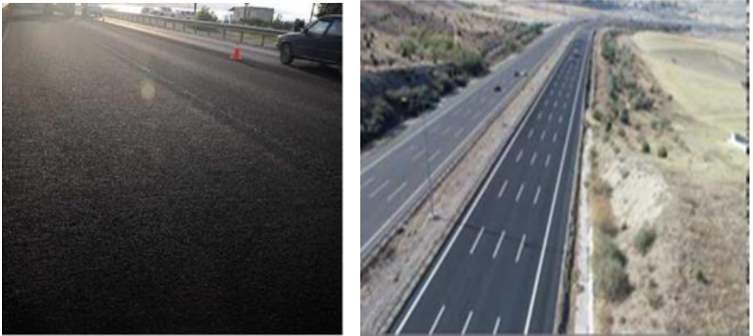
Şekil 6.33 Microsurfacing deneme uygulaması sonunda yolun görünümü
