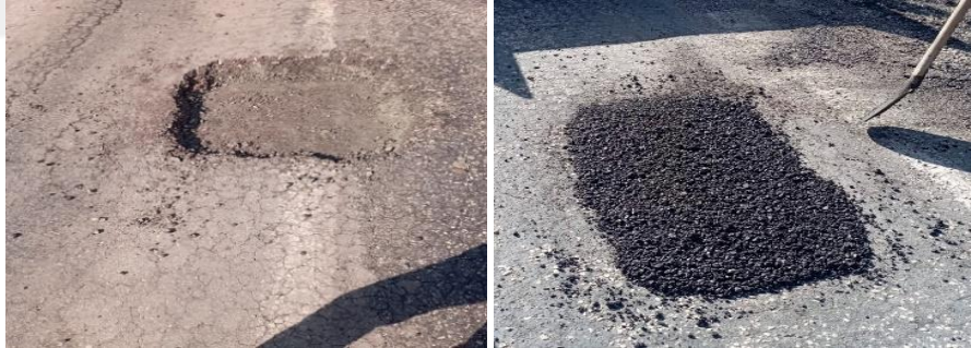
Şekil 5.1 Yama yapılmasına ait bir görünüş
