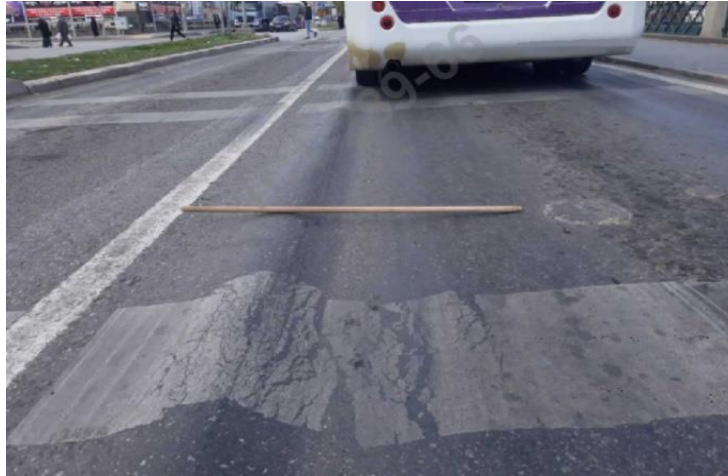
Şekil 4.2 Ondülasyon ve yığılma
