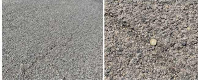
Şekil 6.28 Mevcut kaplamanın deneme uygulaması öncesindeki genel durumu.
