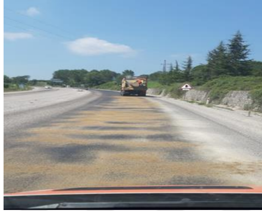
Şekil 5.2 Terleme (Kusma) meydana gelen kesime kum tatbik edilmesine ait bir görünüş
