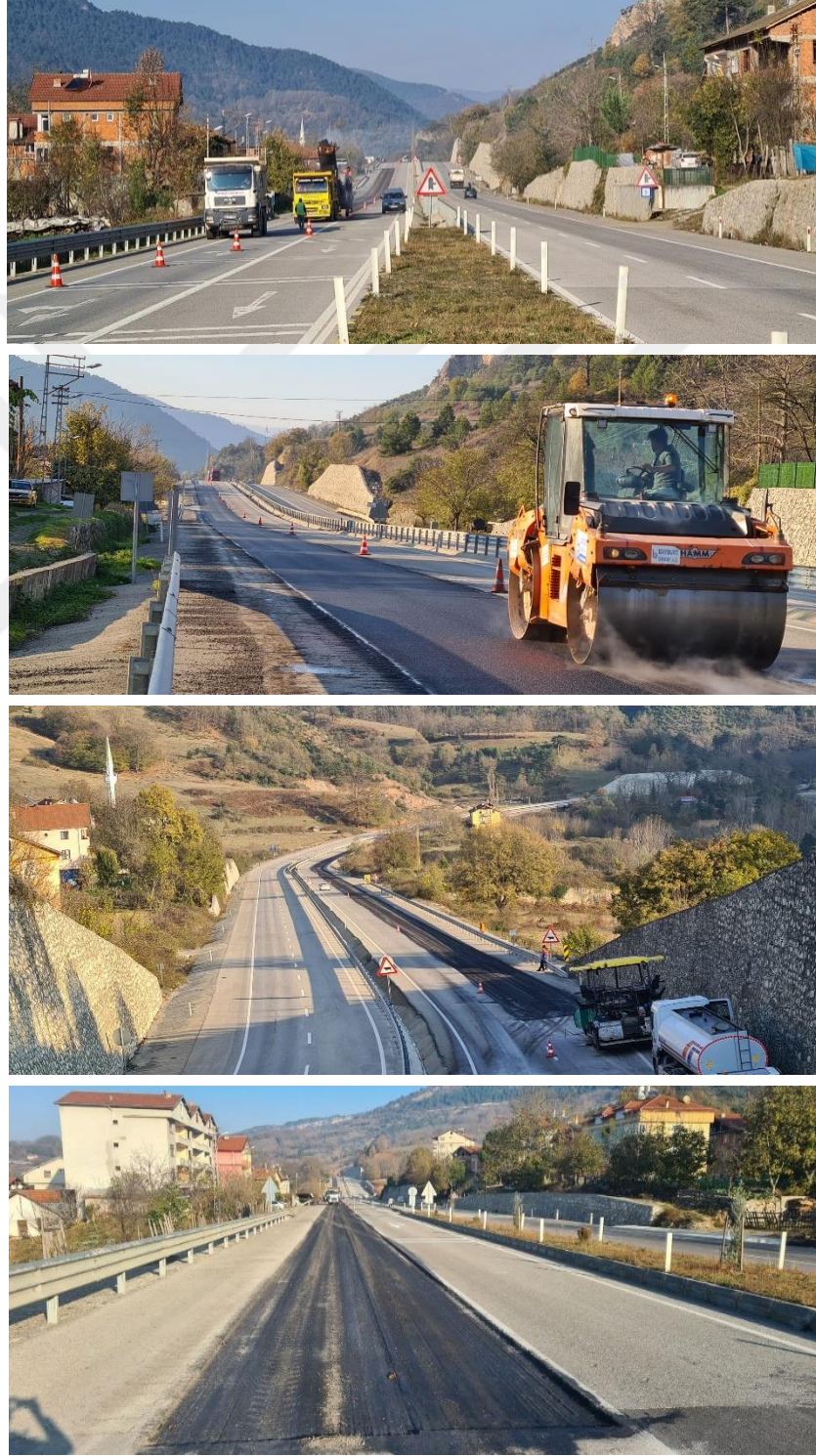
Şekil 6.20 Yolun yapım aşaması
