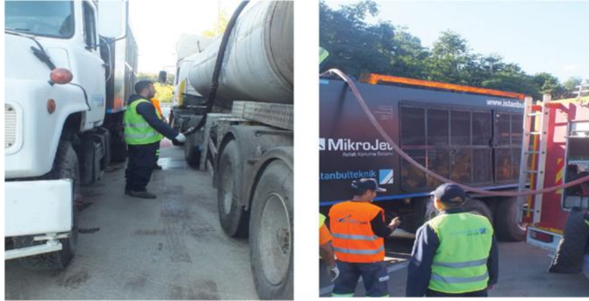
Şekil 6.31 Mikrojet uygulama makinesine polimer modifiye bitüm ve su yüklenmesi
