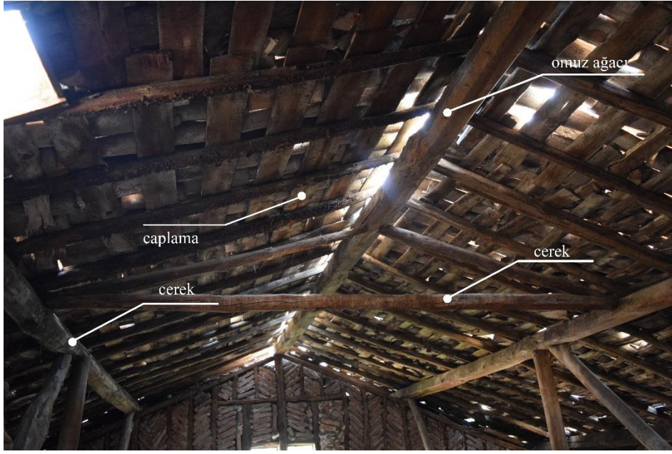
Resim 5.12. Çatı yapı elemanları
