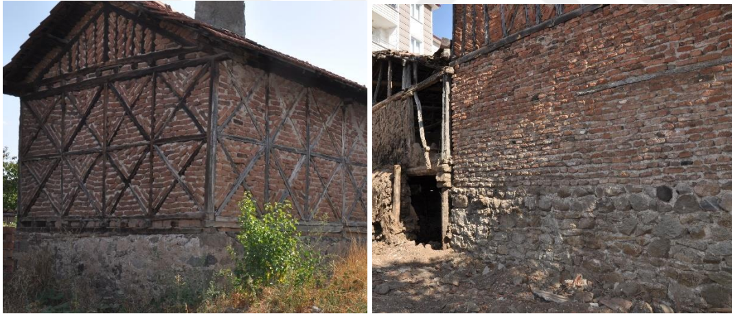
Resim 4.73. Tuğlanın kullanım örnekleri
