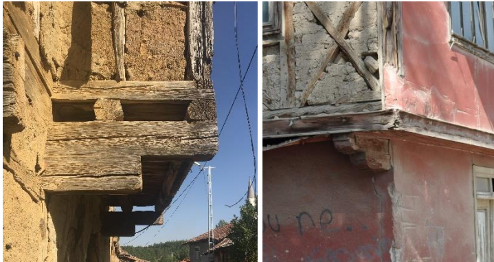
Resim 4.64. Bindirmeli çıkma örneği
