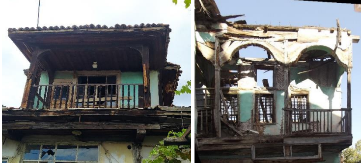
Resim 4.53. Açık çıkma örnekleri
