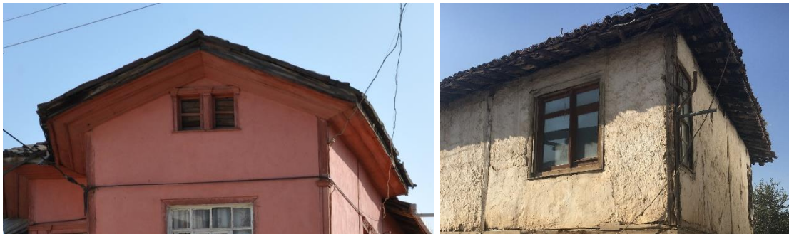
Resim 4.66. Altı kaplamalı ve kaplamasız saçak örnekleri
