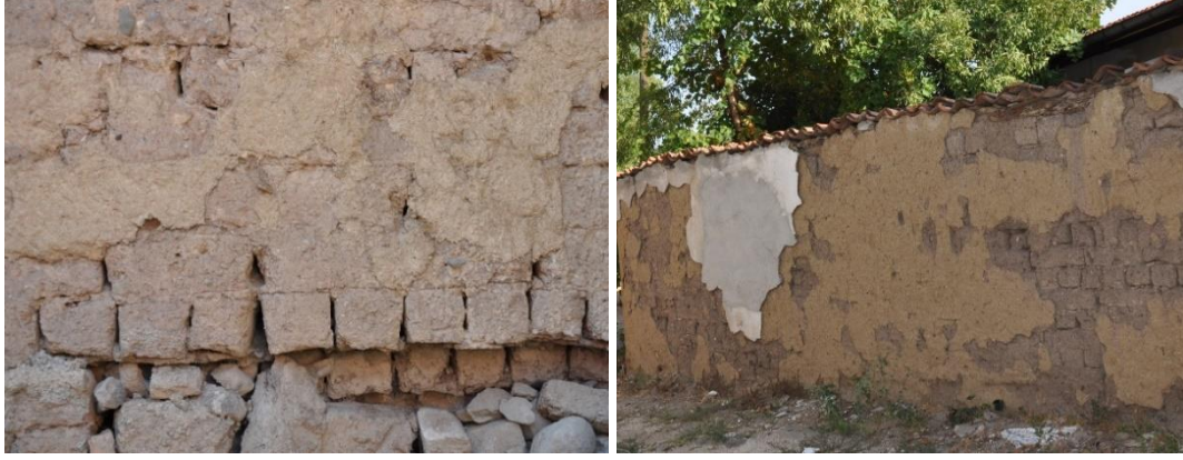
Resim 4.72. Çamur harç sıva örnekleri
