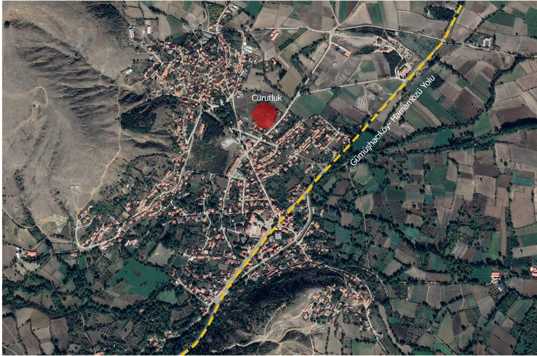
Harita 3.8. Gümüş Tekke Mahallesi maden cüruf yığını (934 ada 11 parsel)
