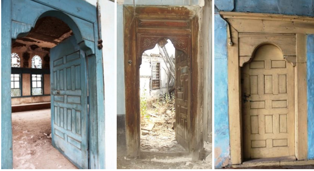
Resim 4.27. Tablalı oda kapılarında yaşmak tahtası örnekleri
