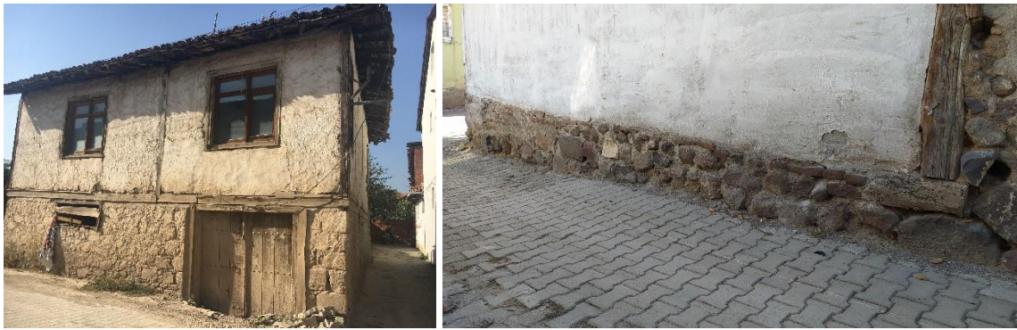
Resim 5.7. Temel duvarında taş kullanımı
