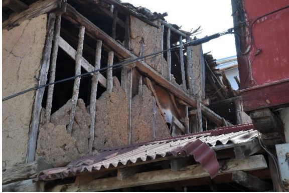
Resim 5.6. İşlenmemiş ağaç parçalarının duvar sisteminde kullanımı
