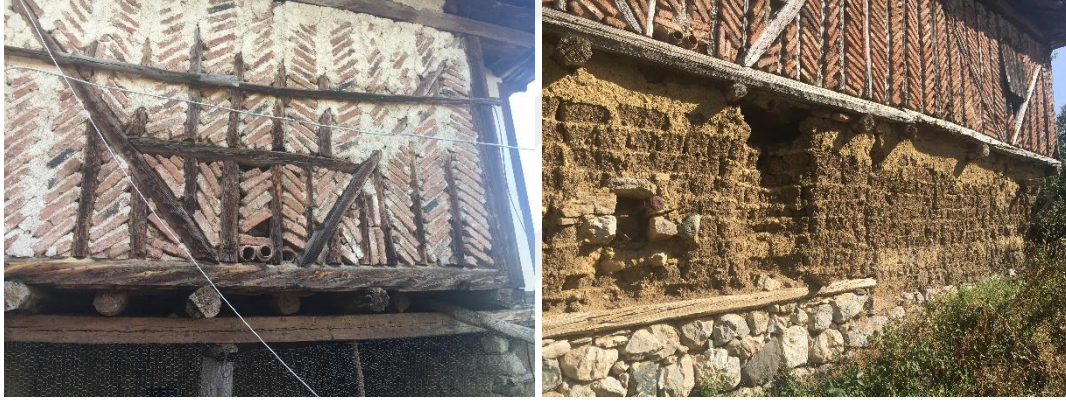
Resim 4.34. Künk kullanılan duvar örneği
