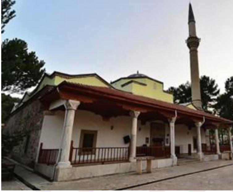
Resim 3.4. Yörgüç Rüstem Paşa Cami
