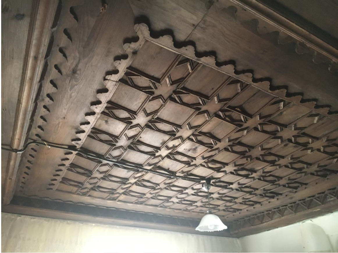
Resim 4.76. Ahşap çıtakari süslemeli tavan
