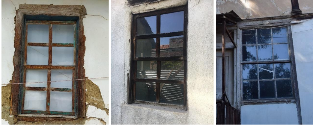
Resim 4.46. Tekli giyotin pencere örnekleri
