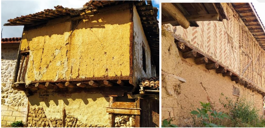
Resim 4.63. Düz kirişlemeli çıkma örneği
