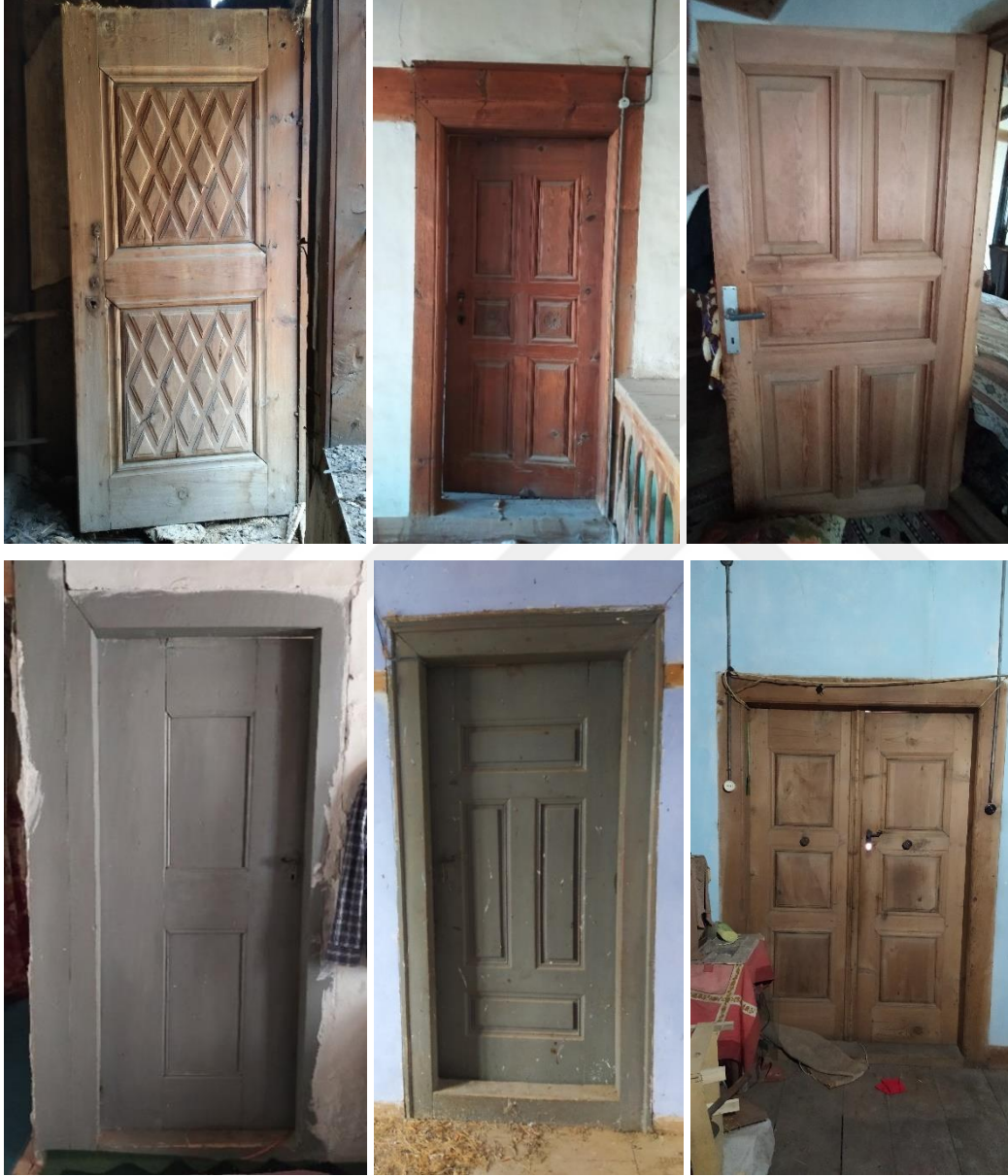
Resim 4.26. Tablalı oda kapıları örnekleri
