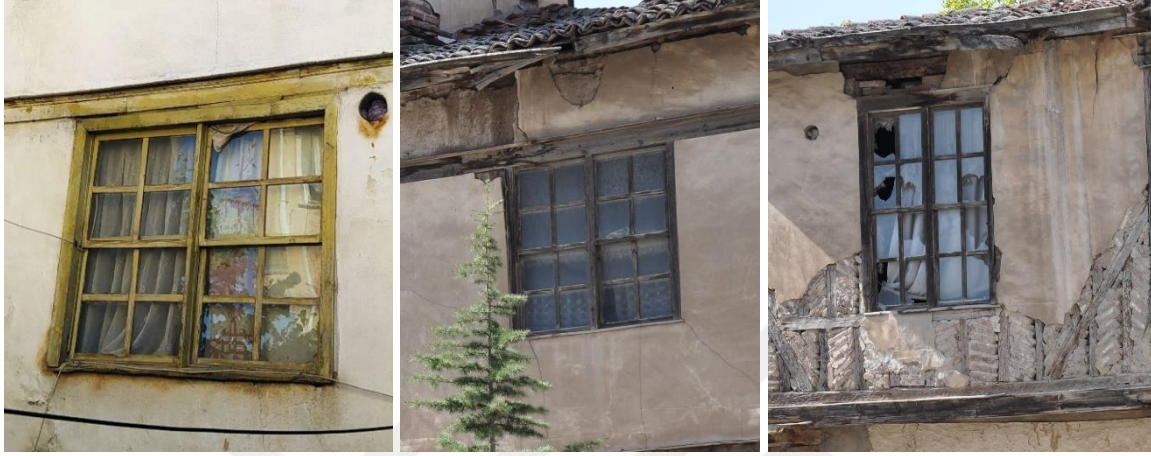
Resim 4.48. İkili giyotin pencere örnekleri
