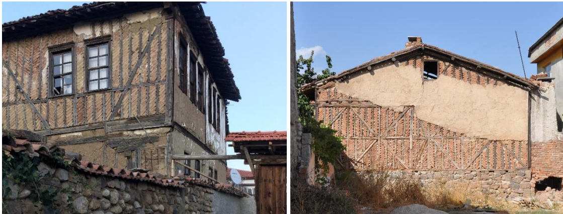
Resim 4.57. Ahşap karkas arası tuğla duvar örnekleri
