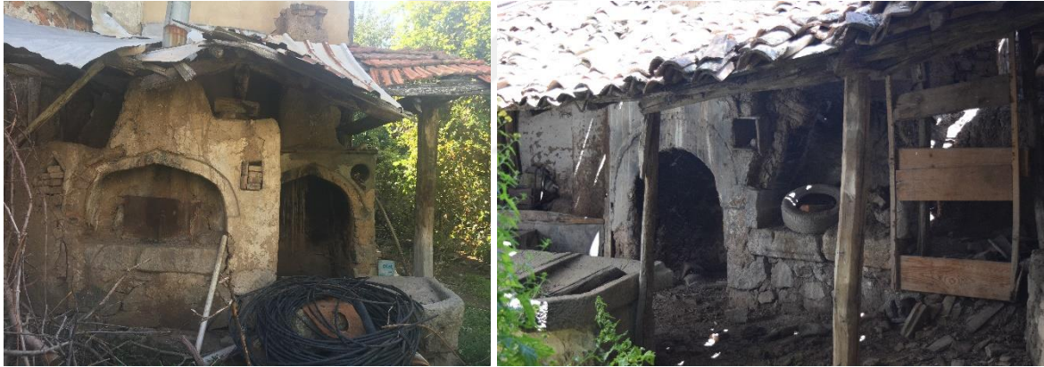
Resim 4.18. Ocak ve fırının bir arada olduğu örnekler (GH 386, GH 244)
