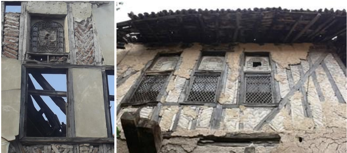
Resim 4.51. Alçı vitraylı pencere örnekleri
