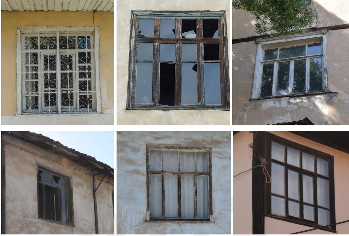
Resim 4.49. Kanatlı pencere örnekleri
