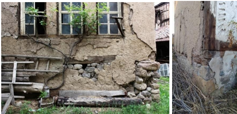
Resim 4.54. Temel duvarlarının subasman seviyesine kadar uzatılması
