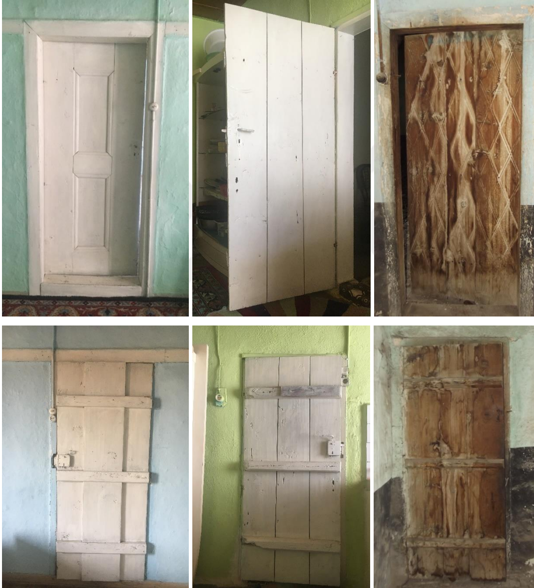
Resim 4.25. Tek katmanlı oda kapıları örnekleri
