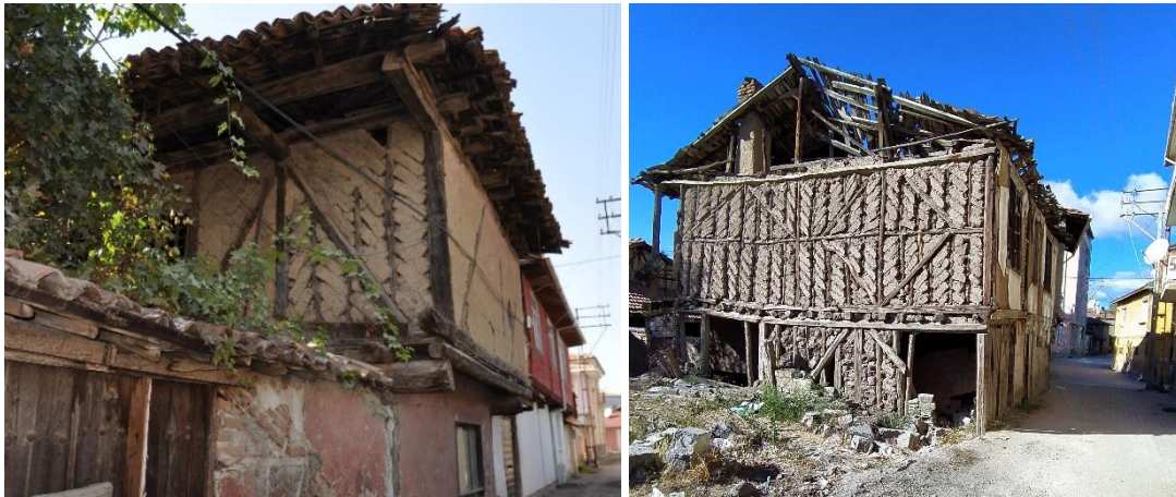
Resim 4.58. Ahşap karkas arası kerpiç dolgu duvar örnekleri
