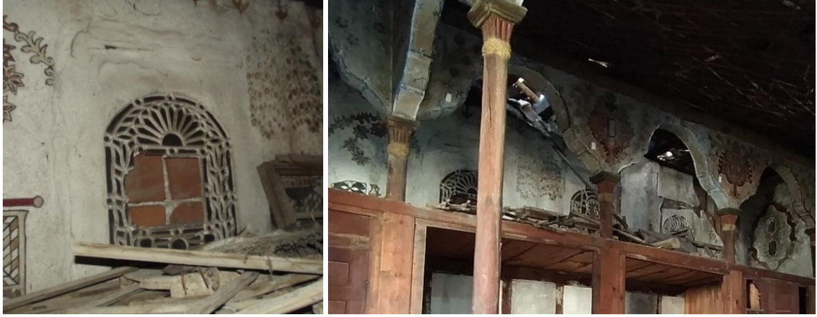
Resim 4.85. Başodada yer alan alçı vitray pencere örnekleri
