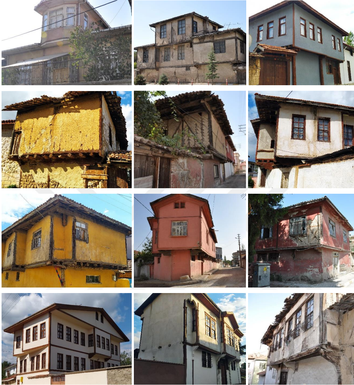
Resim 4.52. Kapalı çıkma örnekler
