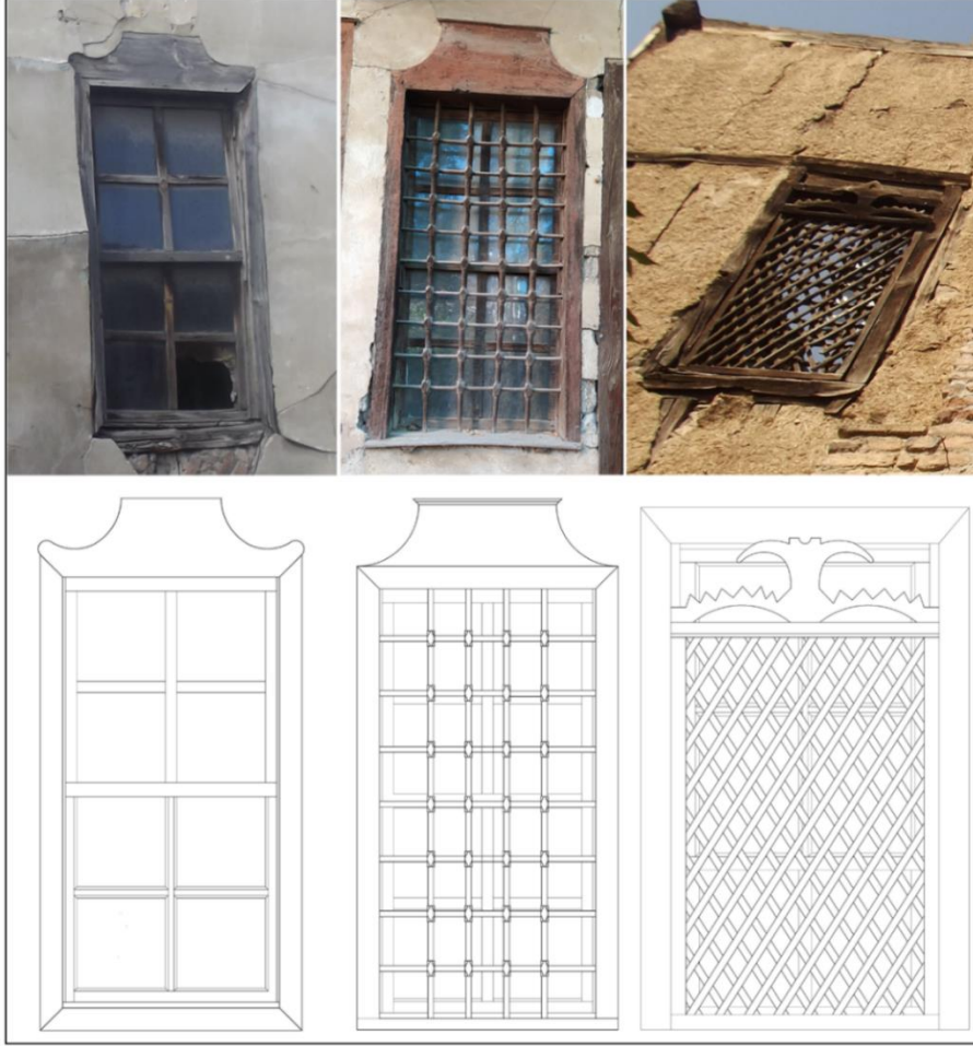
Şekil 4.7. Eğrisel biçimli ahşap süsleme, ahşap kafes, ahşap lokmalı şebeke örnekleri
