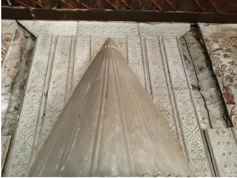
Resim 4.79. Alçı süslemeli ocak detayları
