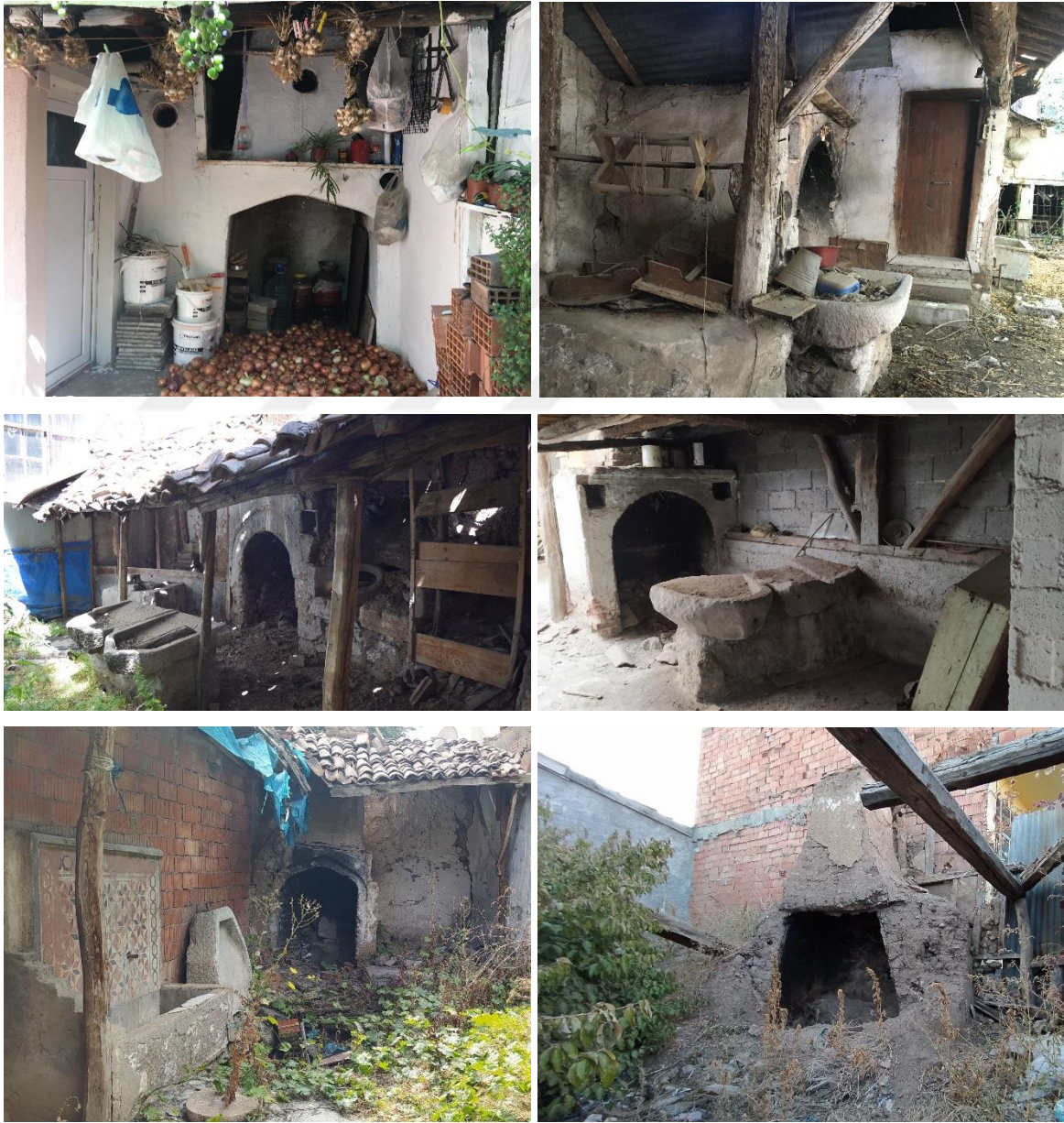
Resim 4.19. Bahçede ocak, çeşme, kuyu ve esvap taşı örnekleri
