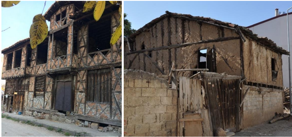
Resim 5.8. Tuğla ve kerpiç dolgulu cizvit konut örneği
