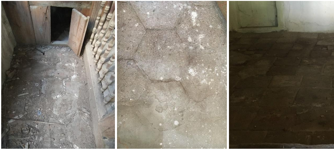
Resim 4.62. Döşeme tuğlası örnekleri
