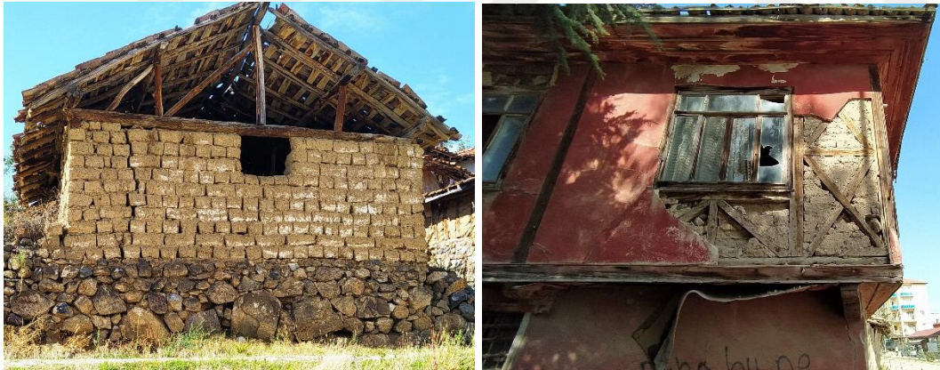
Resim 4.71. Kerpicing duvar elemanı olarak kullanımı
