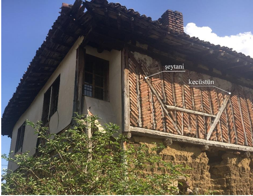
Resim 5.10. Cizvit duvar örgüsünde kecüstün, şeytani
