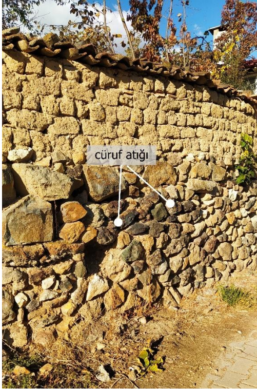
Resim 4.11. Maden cüruf atığı kullanılan duvar örneği
