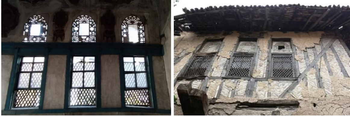
Resim 4.84. Alçı vitray pencere örnekleri
