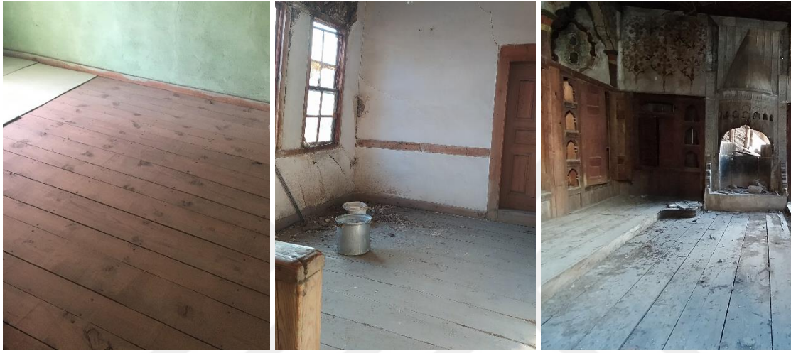
Resim 4.61. Ahşap döşeme kaplaması örnekleri
