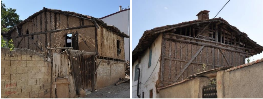
Resim 4.67. Ahşap malzemenin yapı elemanı olarak kullanımı
