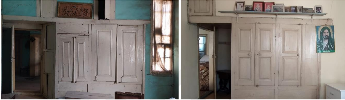
Resim 4.32. Seki altı bölümünün yüklük elemanı ile sınırlandırılması
