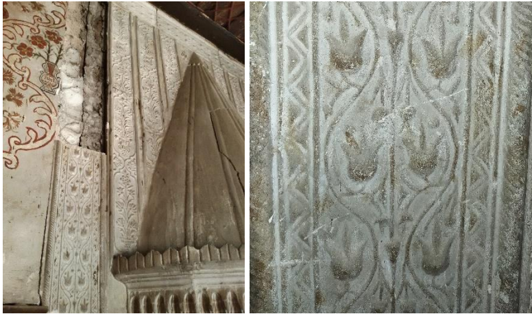
Resim 4.78. Alçı süslemeli ocak detayları
