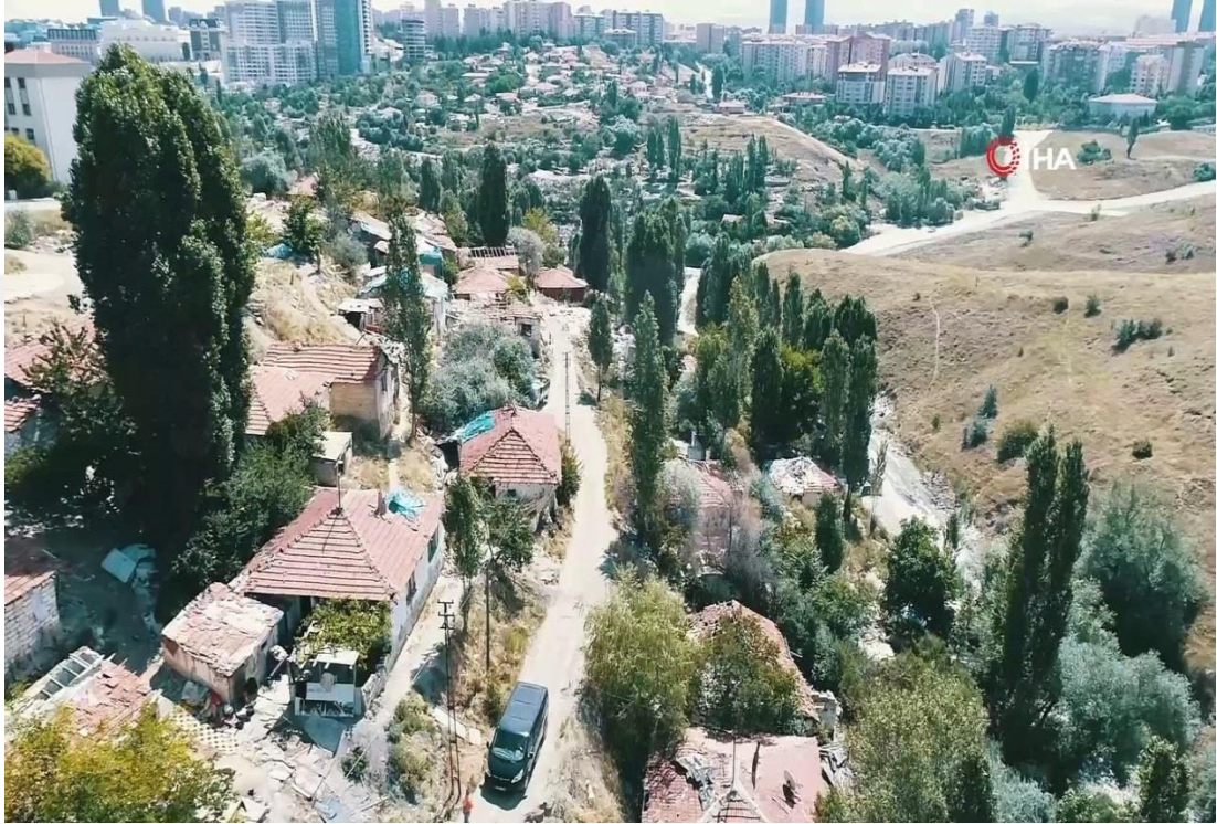
Şekil 4.8 : Dikmen vadisi eski ve yeni yapıların beraber görünümü (İhlas Haber Ajansı).
