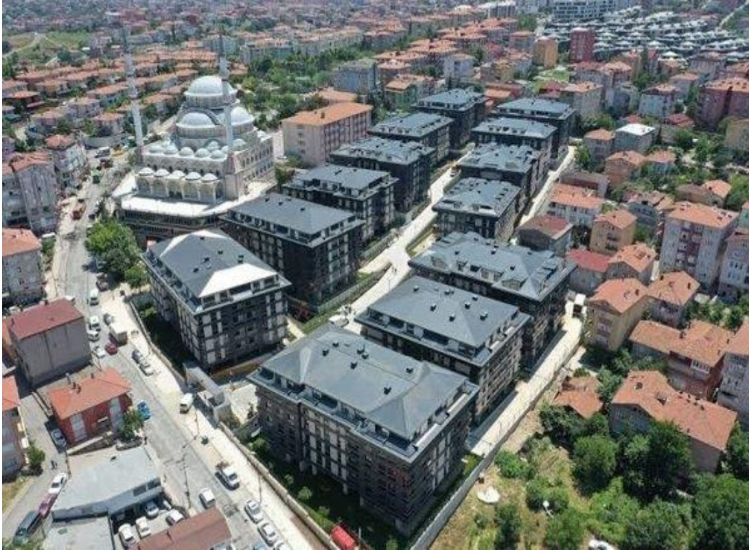
Şekil 4.12 : Üsküdar Belediyesi rezerv konutları (Üsküdar Belediyesi Yapı Kontrol Müdürlüğü).
